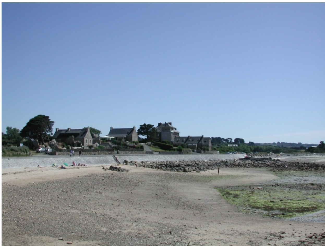
Le mur digue de Pors Scaff
