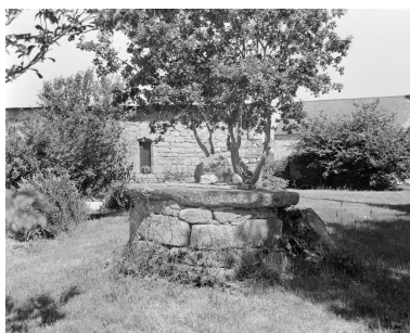
Puits, vue générale. Phot. Bernard Bègne IVR53_19975600669X
