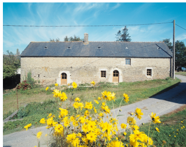
Vue générale sud. Phot. Bernard Bègne IVR53_19975600931XA
