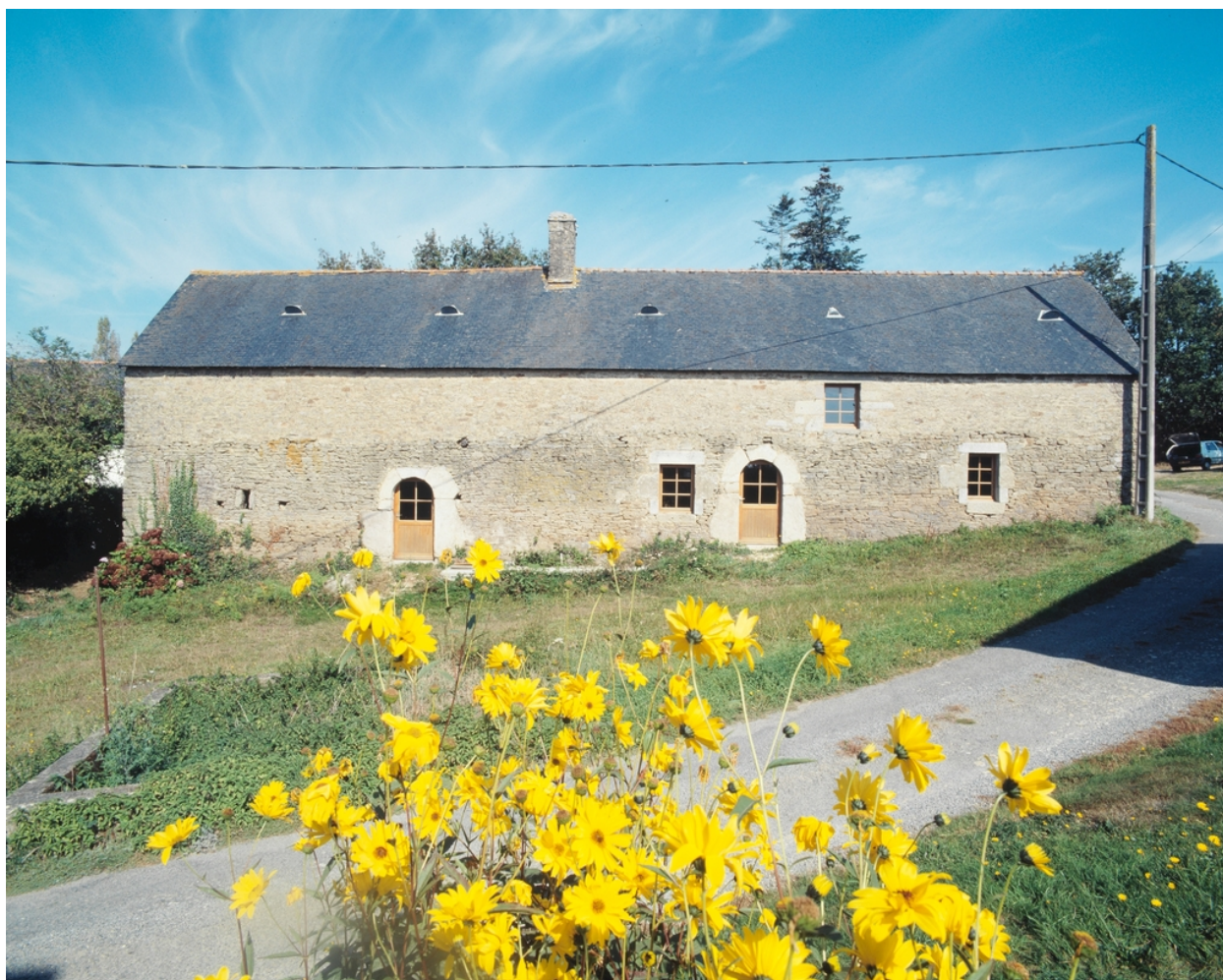
Vue générale sud.
