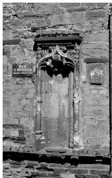
Elévation ouest, porte, niche à dais gauche : vue générale Phot. François Dagorn IVR53_19743500230X
