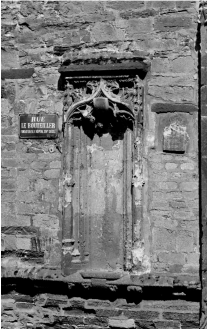
Elévation ouest, porte, niche à dais gauche : vue générale
