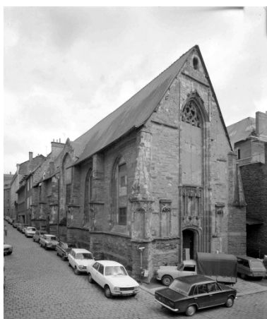
Elévation nord-ouest : vue générale Phot. Isabelle Barbedor IVR53_19743500232V
