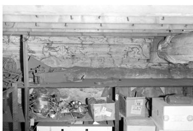
Troisième travée nord, sablière. Phot. Auteur inconnu IVR53_19693500051V
