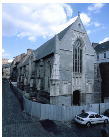
Elévation nord-ouest : vue générale Phot. François Dagorn IVR53_19953500379XA
