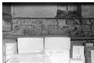
Cinquième travée nord, sablière. Phot. Auteur inconnu IVR53_19693500049V
