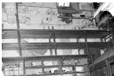
Première travée sud, sablière. Phot. Auteur inconnu IVR53_19693500043V
