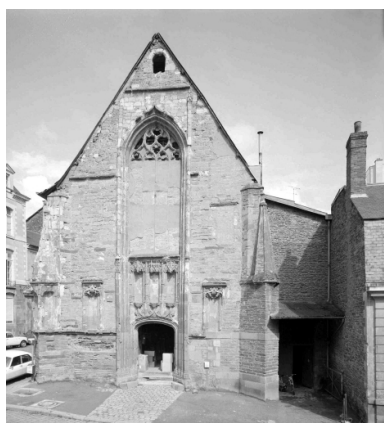
Elévation ouest : vue générale Phot. Isabelle Barbedor IVR53_19743500231V
