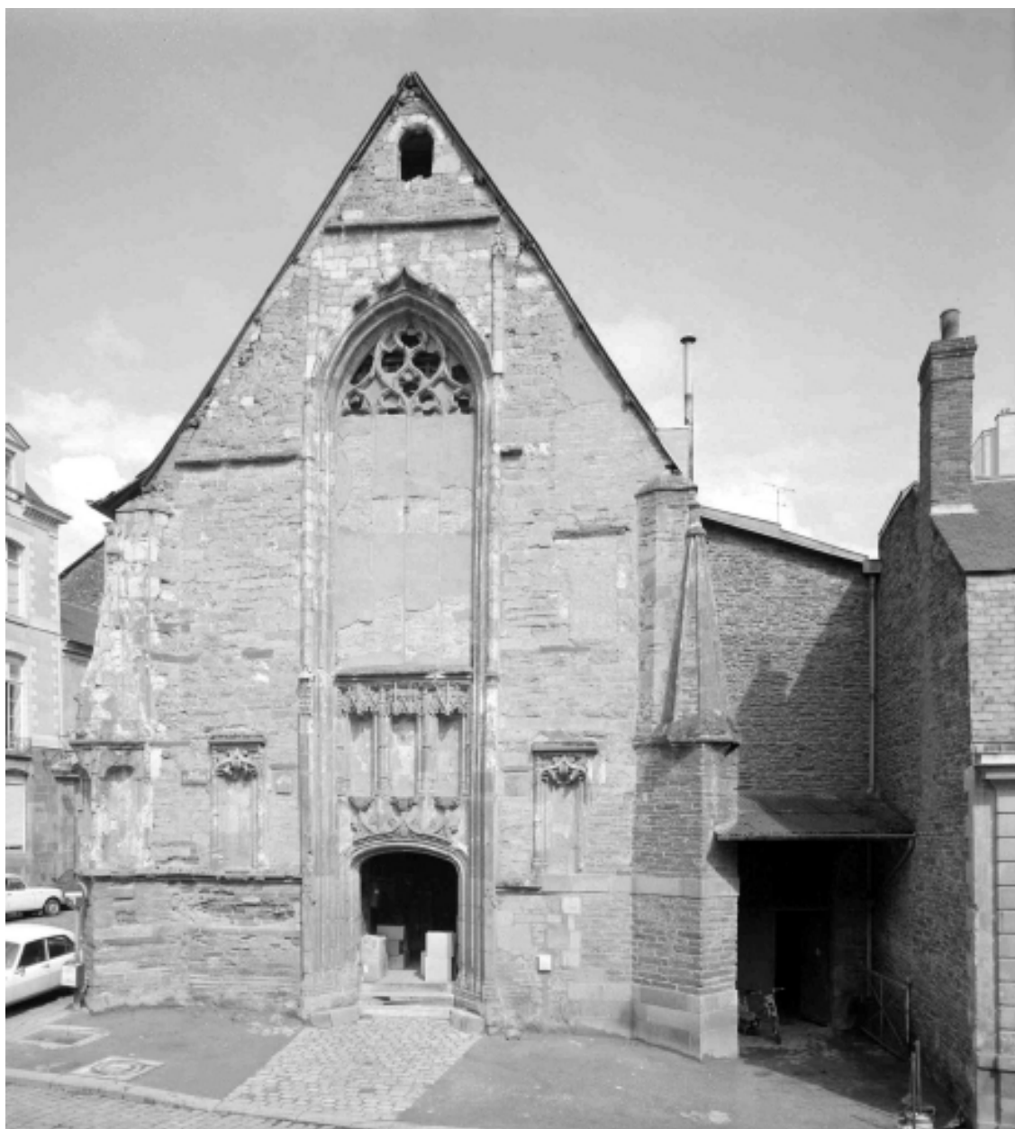
Elévation ouest : vue générale
