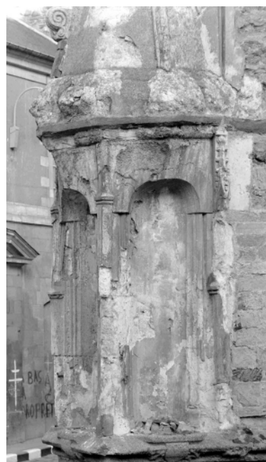
Elévation ouest, pignon nord : détail de la niche supérieure Phot. Isabelle Barbedor IVR53_19693500042V
