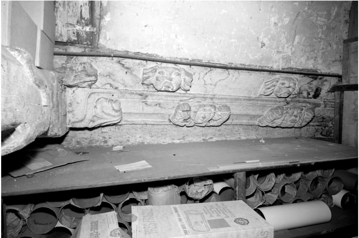
Sixième travée nord, sablière.
