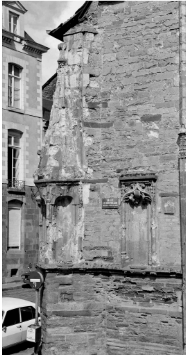
Elévation ouest, pignon gauche : vue générale
