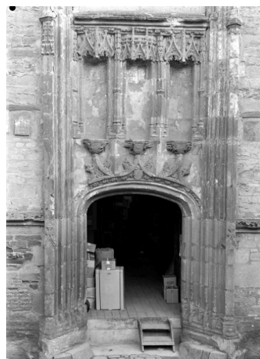
Elévation ouest : détail de la porte Phot. Isabelle Barbedor IVR53_19693500039V
