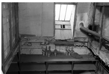
Première travée sud, sablière. Phot. Auteur inconnu IVR53_19693500044V
