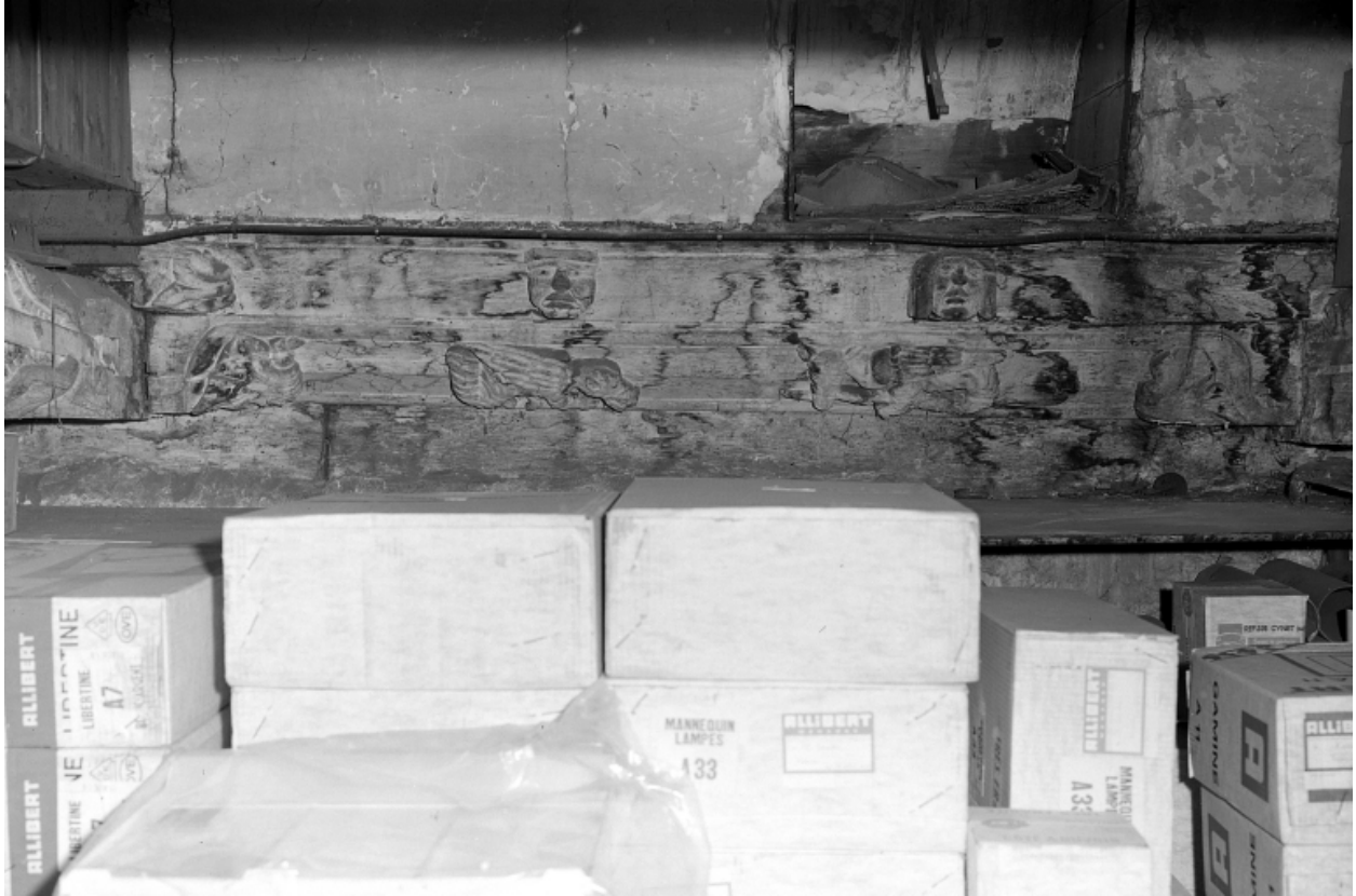
Cinquième travée nord, sablière.
