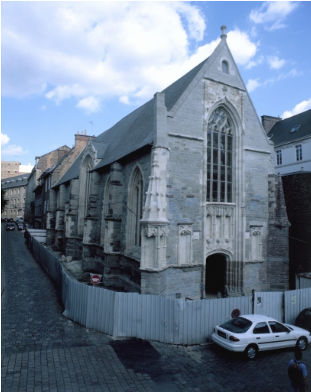
Elévation nord-ouest : vue générale
