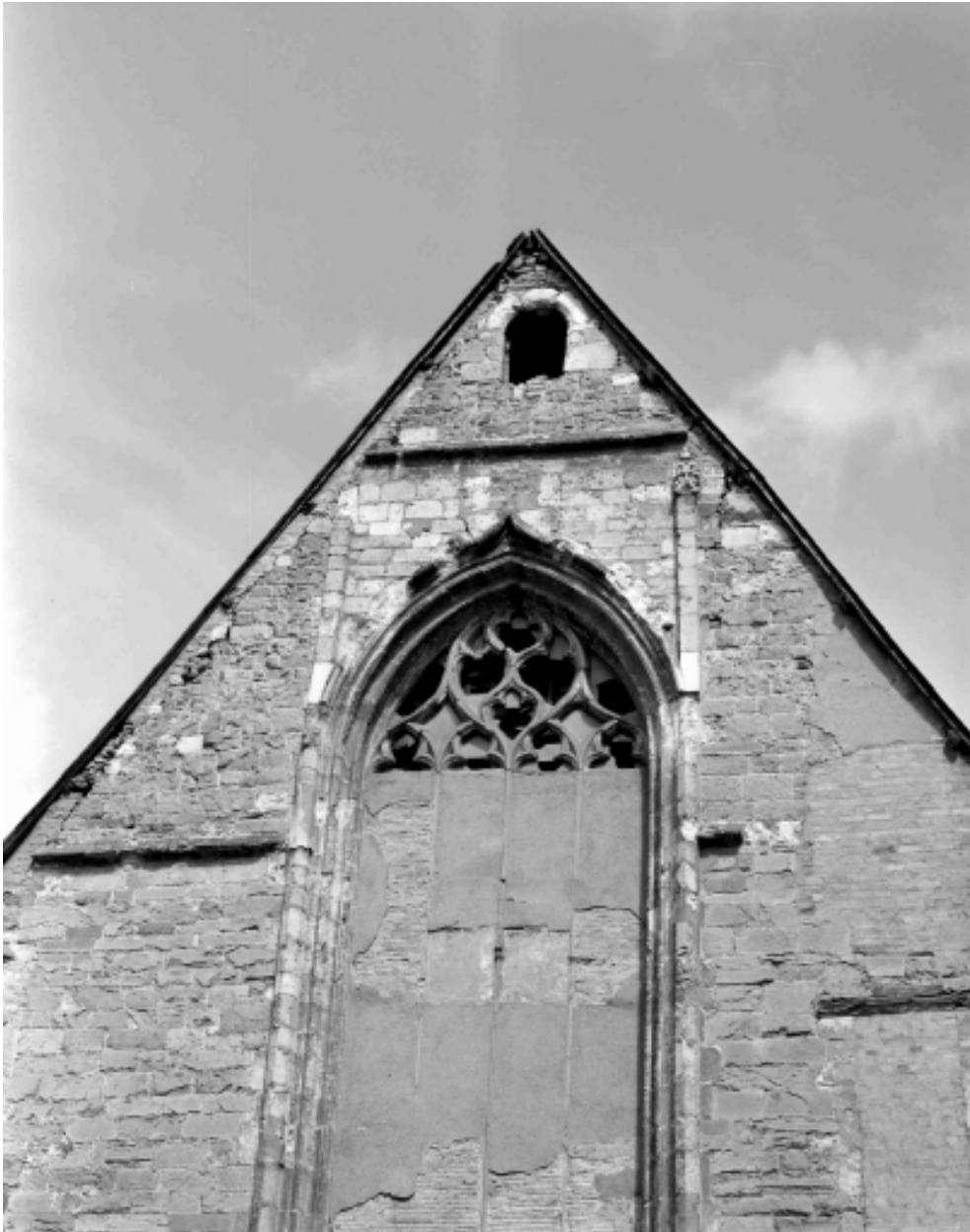
Elévation ouest, fenêtre : vue générale
