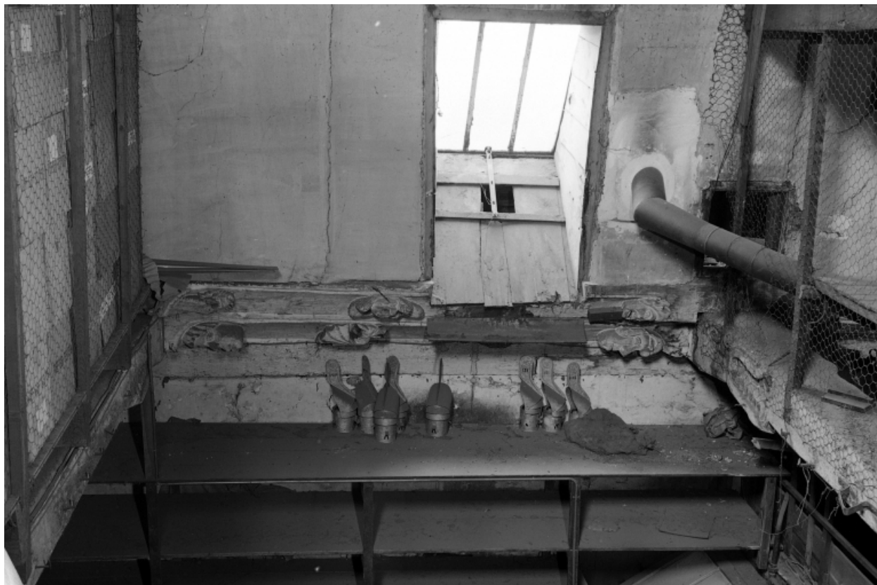
Première travée sud, sablière.
