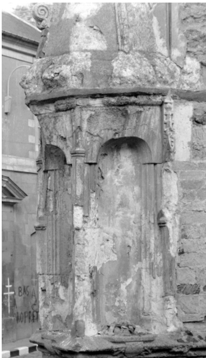
Elévation ouest, pignon nord : détail de la niche supérieure
