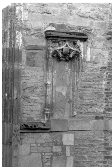
Elévation Ouest, porte, niche à dais droite : vue générale. Phot. François Dagorn IVR53_19693500040V
