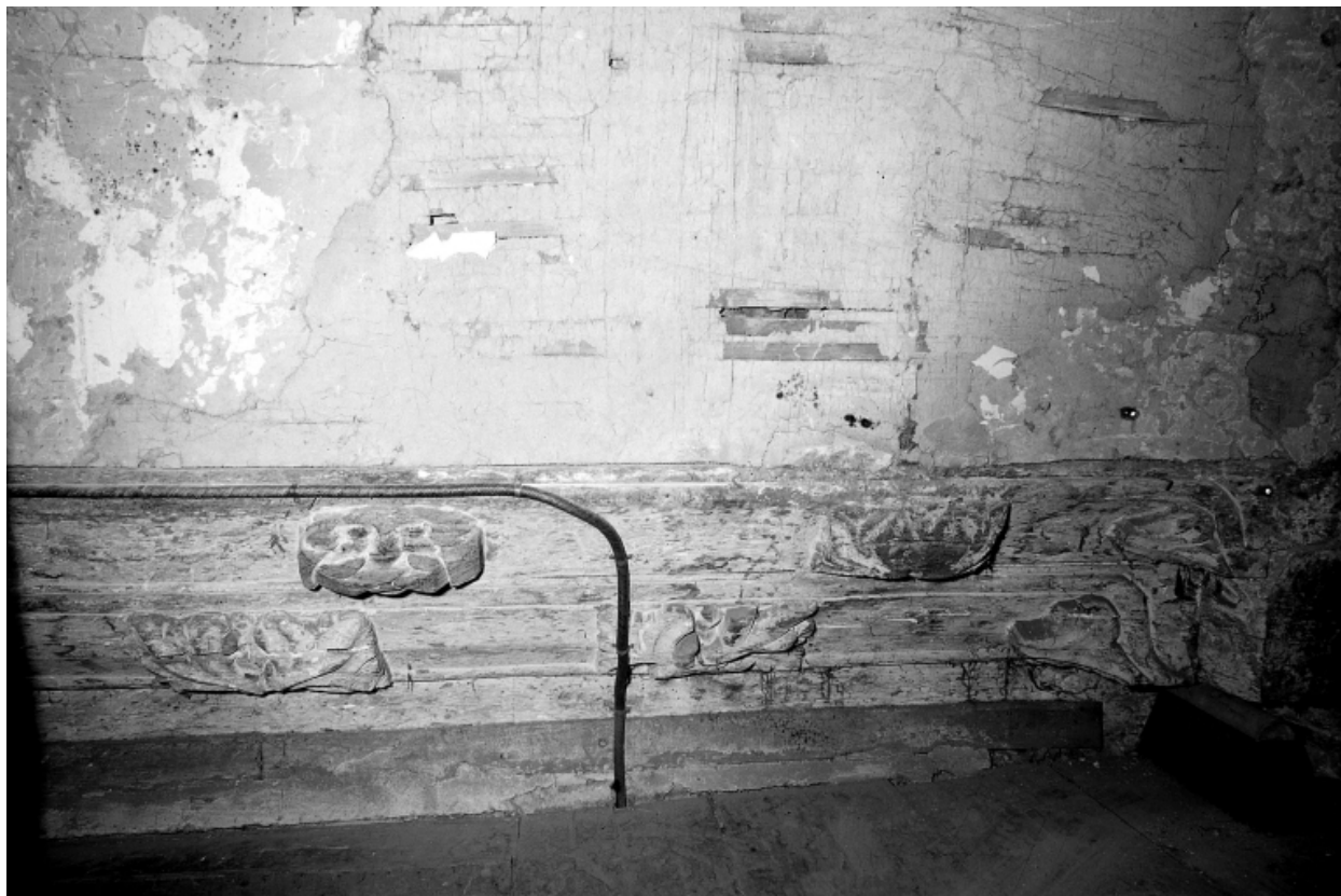
Sixième travée nord, sablière.
