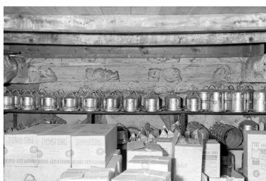
Cinquième travée sud, sablière. Phot. Auteur inconnu IVR53_19693500046V
