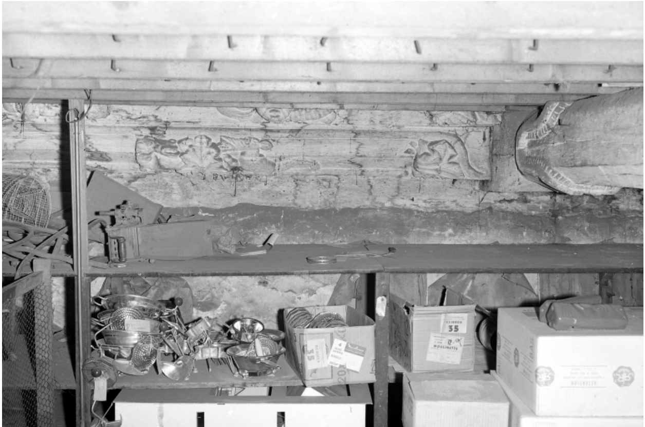
Troisième travée nord, sablière.
