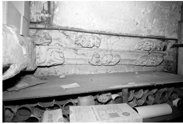
Sixième travée nord, sablière. Phot. Auteur inconnu IVR53_19693500048V
