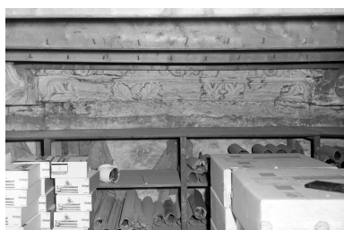
Quatrième travée nord, sablière. Phot. Auteur inconnu IVR53_19693500050V
