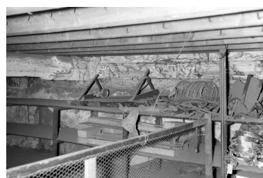
Troisième travée nord, sablière. Phot. Auteur inconnu IVR53_19693500052V
