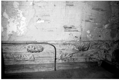
Sixième travée nord, sablière. Phot. Auteur inconnu IVR53_19693500047V
