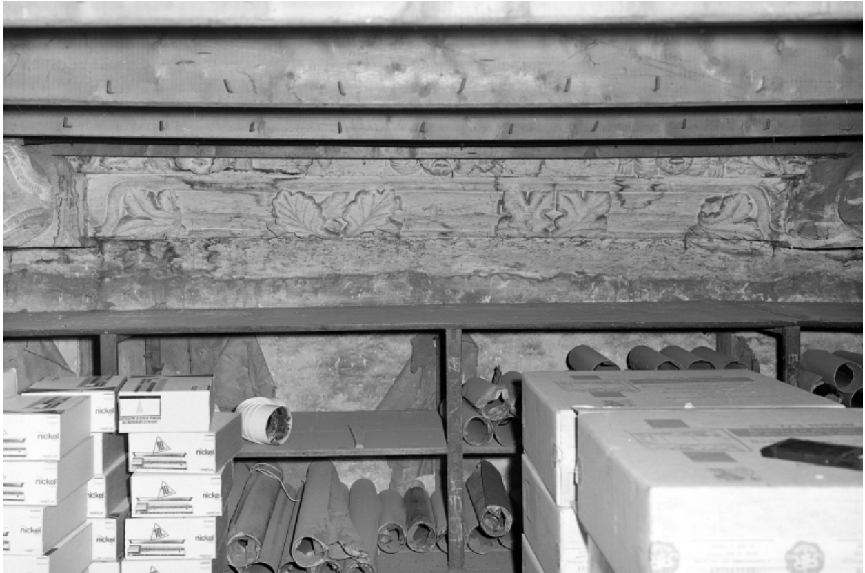
Quatrième travée nord, sablière.
