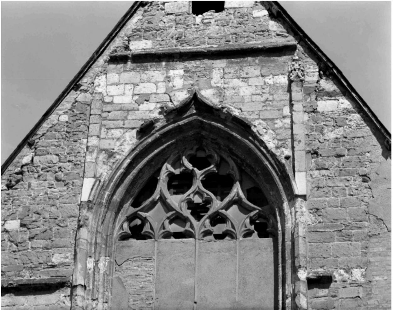
Elévation ouest, fenêtre : détail de la partie haute
