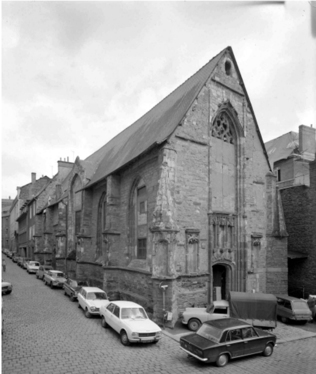
Elévation nord-ouest : vue générale
