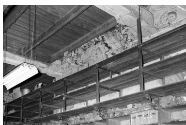
Deuxième travée sud, sablière. Phot. Auteur inconnu IVR53_19693500045V
