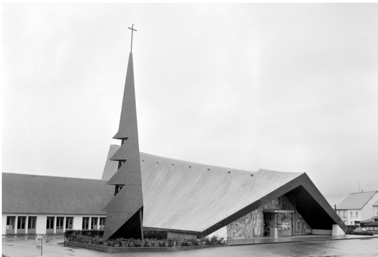
Elévation Ouest : vue générale
