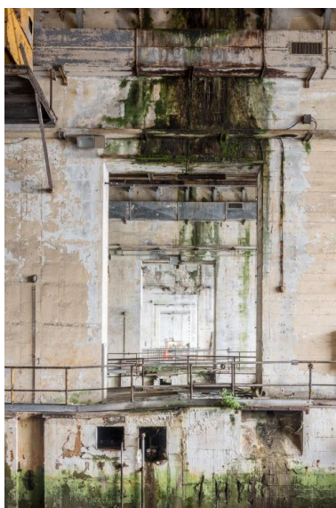
Vue de l'alvéole A (n° 24) : perspective des ouvertures dans les murs de refend Phot. Charlotte Barraud IVR53_20215600669NUCA
