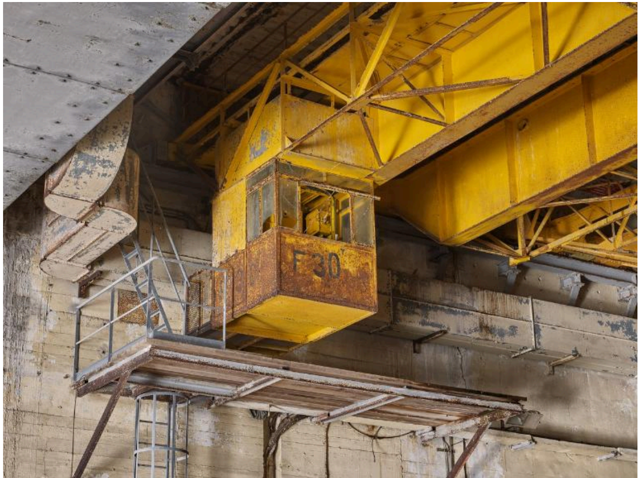
Vue de la cabine du pont roulant. Il disposait d'une capacité maximum de levage de 30 tonnes (F[orce] 30)
