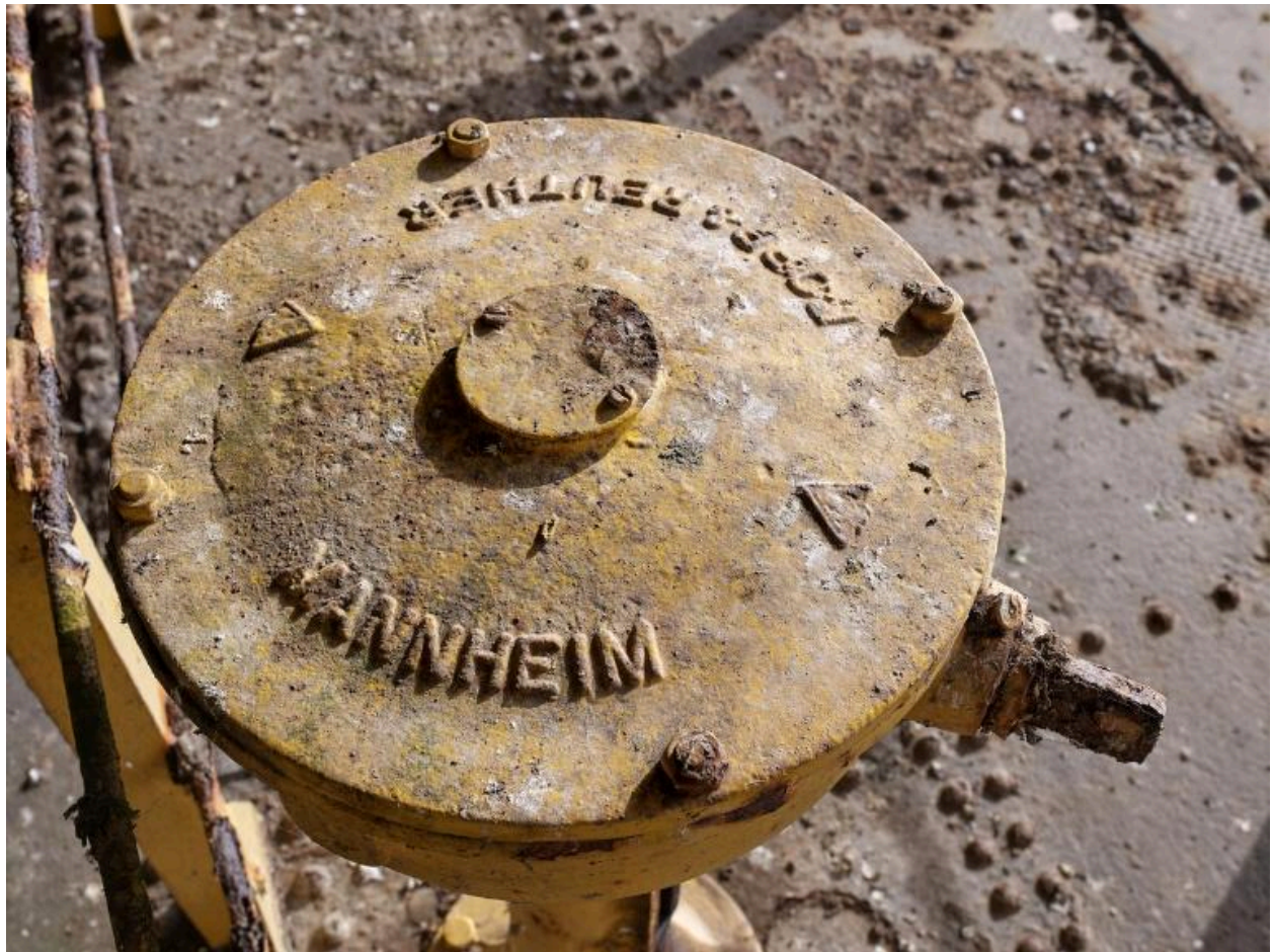
Vue de l'une des deux commandes de pompe sur le bateau-porte fermant le bassin. On peut lire : BOPP et REUTHER VANNHEIM. Elle fonctionnait avec une manivelle
