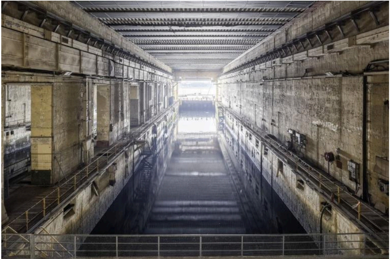
Vue générale de l'alvéole A (n° 24) en eau. Ses portes étanches sont fermées
