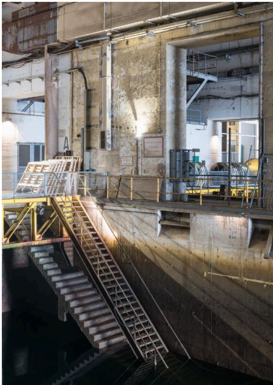
Vue de l'alvéole A (n° 24) : escaliers plongeant dans l'eau. Sur les murs, peintures murales françaises et marquages
