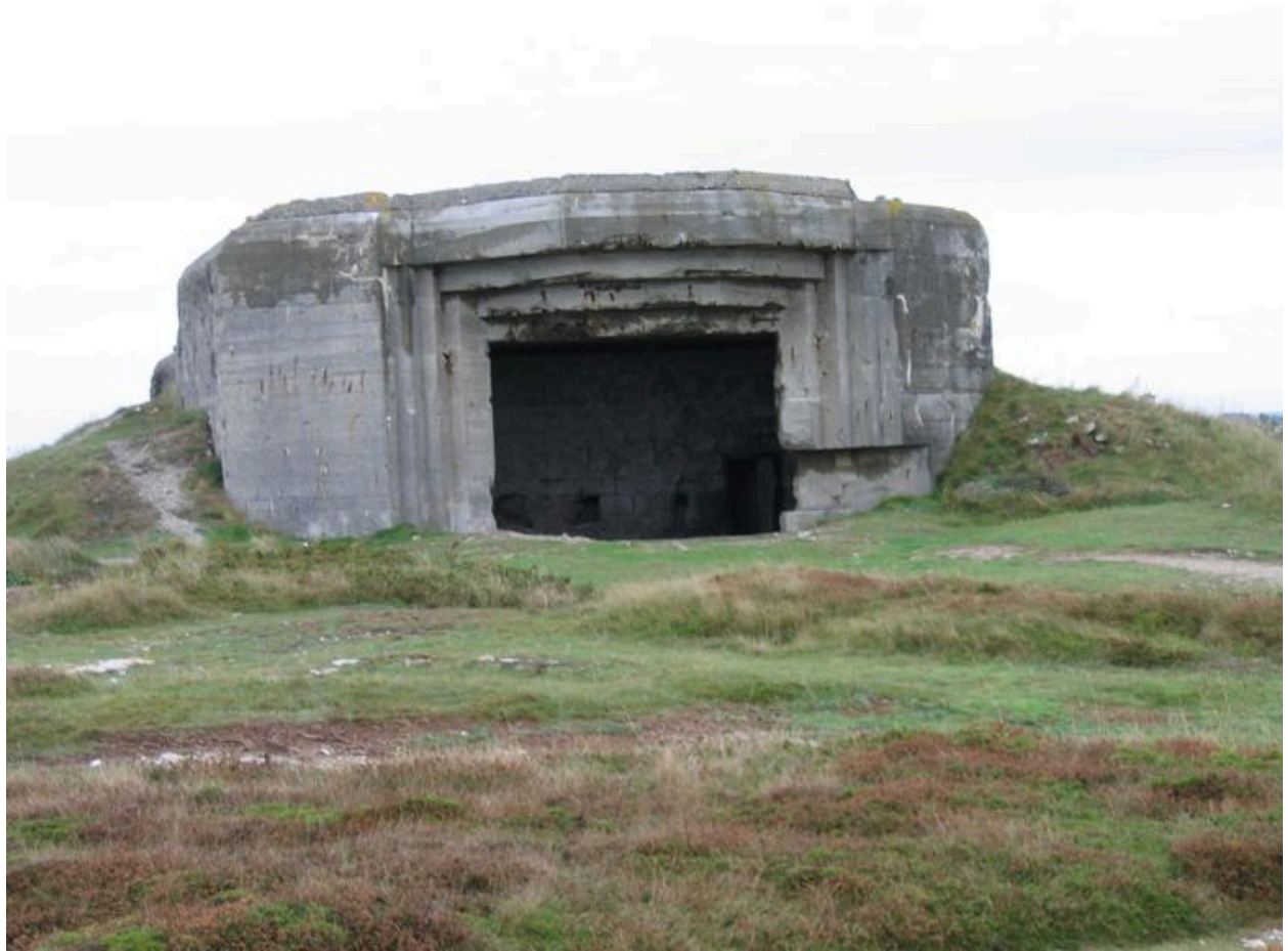
Casemate de la batterie lourde allemande
