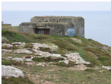
Casemate de la batterie de mortier française Phot. Guillaume Marie IVR53_20062908491NUCA
