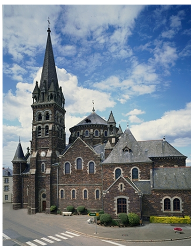
Vue générale sud-est Phot. Guy Artur, Phot. Norbert Lambart IVR53_19923500592VA
