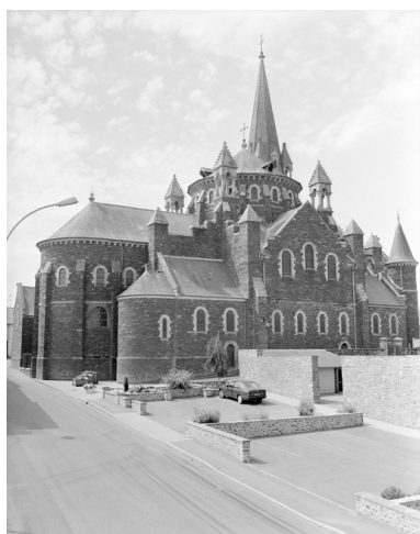
Vue générale nord-est Phot. Guy Artur, Phot. Norbert Lambart IVR53_19943501767X
