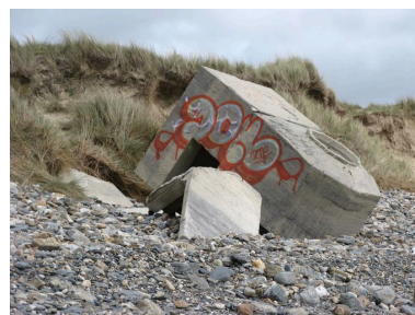
Abri sur la plage de l'Aber, basculé en raison de l'érosion côtière Phot. Guillaume Marie IVR53_20082908340NUCA
