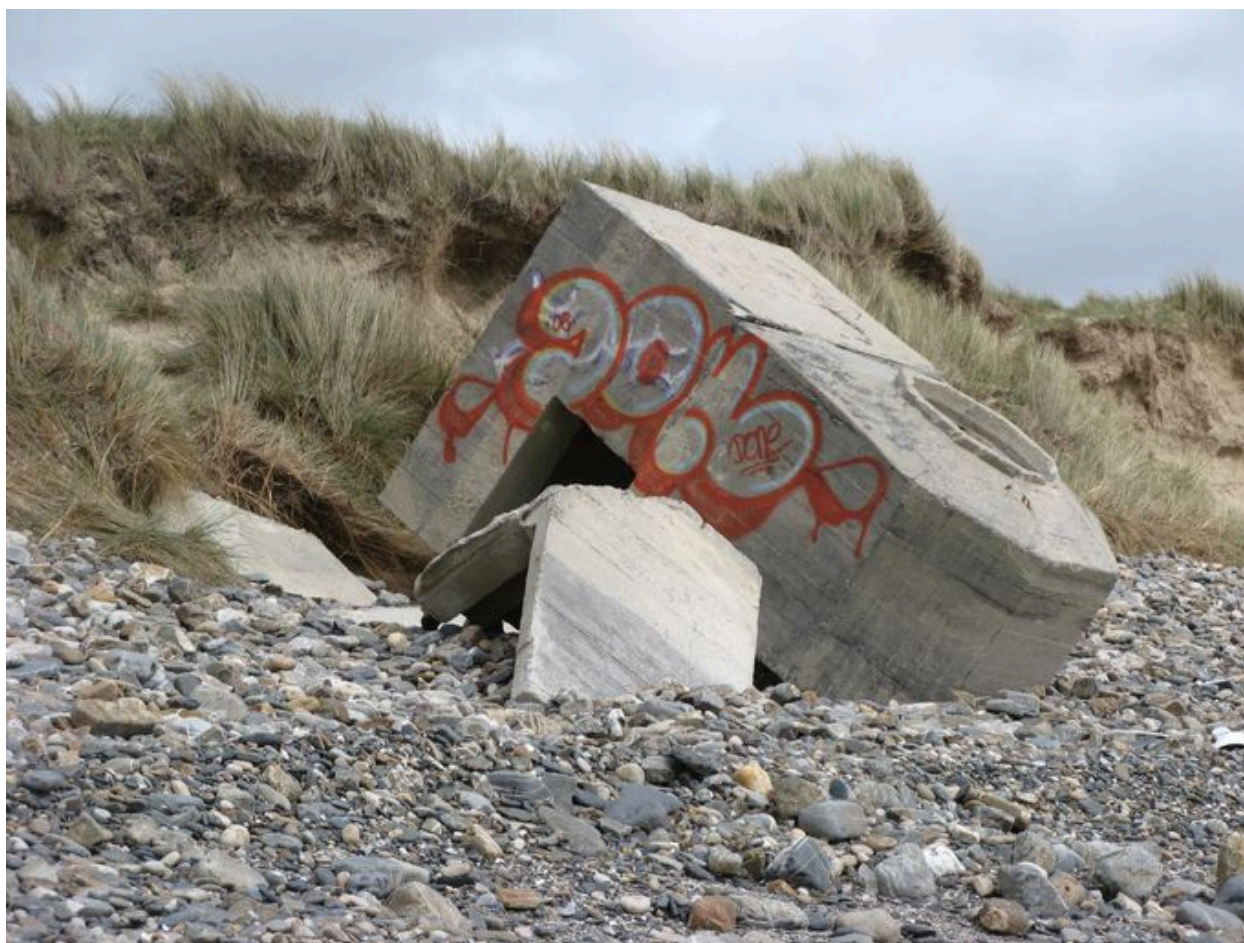
Abri sur la plage de l'Aber, basculé en raison de l'érosion côtière
