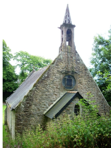
Bohars, chapelle de Loguillo : vue générale nord-ouest Phot. Gwénaél Fauchille IVR53_20082906388NUCA
