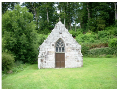
Bohars, chapelle de Loguillo : élévation est Phot. Gwénaél Fauchille IVR53_20082906387NUCA
