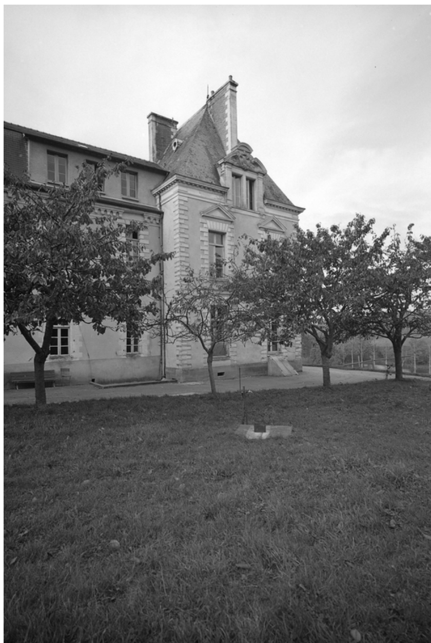
Elévation est : partie nord, vue générale.
