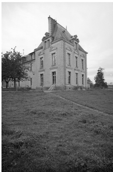
Vue générale nord est. Phot. François Dagorn IVR53_19673500024V
