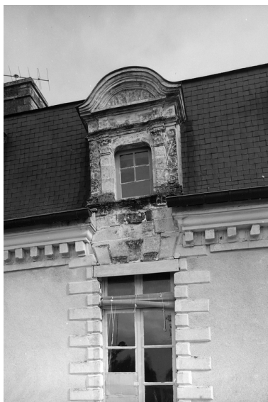
Face ouest, détail de la lucarne centrale. Phot. François Dagorn IVR53_19673500026V
