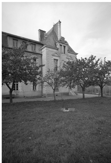
Elévation est : partie nord, vue générale. Phot. François Dagorn IVR53_19673500025V
