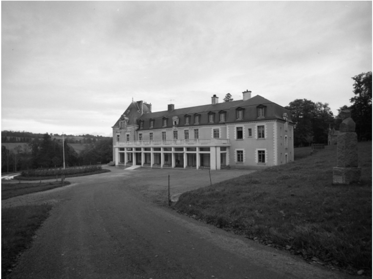
Elévation ouest, vue générale.
