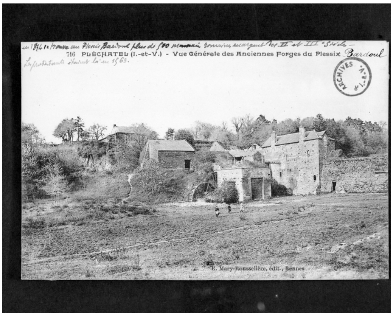
Carte postale ancienne - 716 - Pléchâtel (I.-et-V.) - Vue générale des anciennes forges du Plessis-Bardoul.
