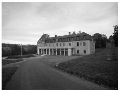
Elévation ouest, vue générale. Phot. François Dagorn IVR53_19673500021V
