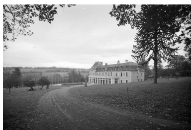
Vue de situation, prise du sud ouest. Phot. François Dagorn IVR53_19673500020V
