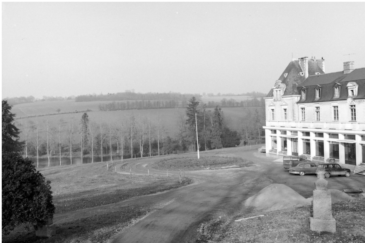
Vue prise du sud ouest.
