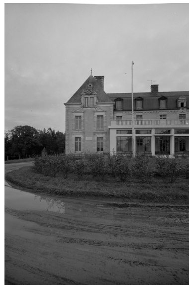
Elévation ouest : pavillon nord, vue générale. Phot. François Dagorn IVR53_19673500022V
