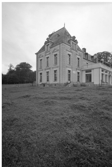
Vue générale nord ouest. Phot. François Dagorn IVR53_19673500023V
