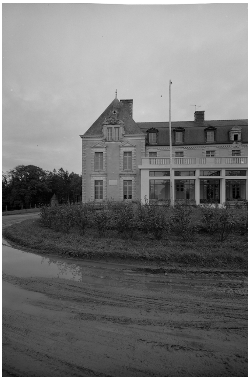
Elévation ouest : pavillon nord, vue générale.
