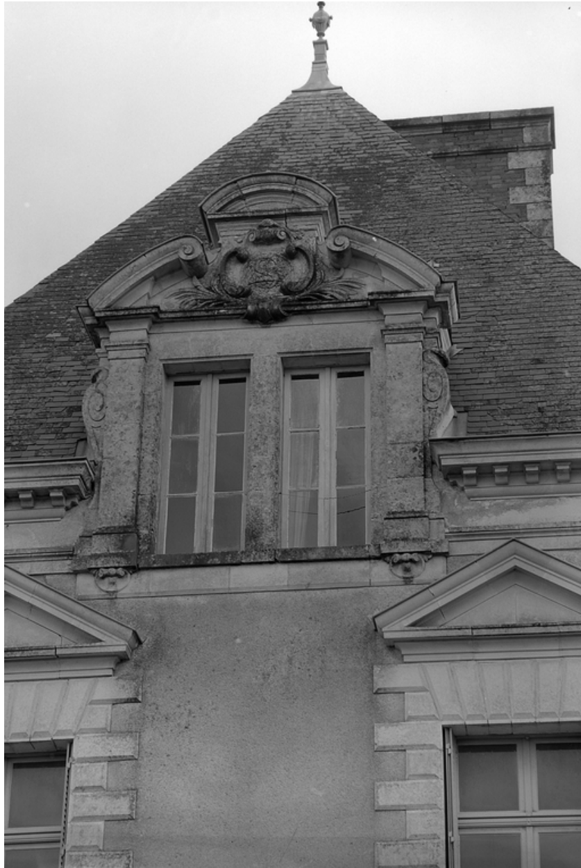
Face ouest : détail de la lucarne.
