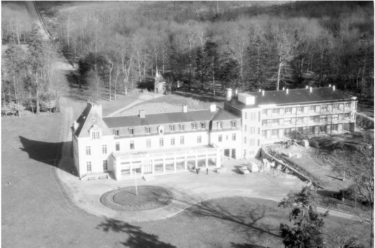
Vue aérienne rapprochée ouest.
