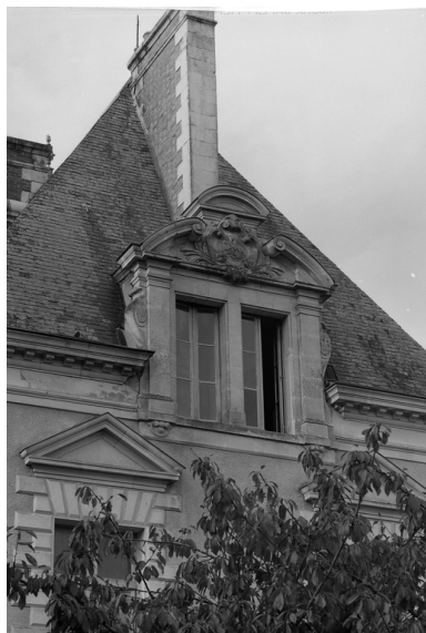
Face est : détail de la lucarne. Phot. François Dagorn IVR53_19673500030V
