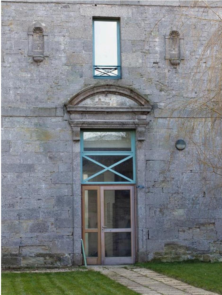
Grand corps de logis. Elévation nord. Détail de la porte d'entrée réalisée avec des remplois de la fin du 17<sup>e</sup> siècle
