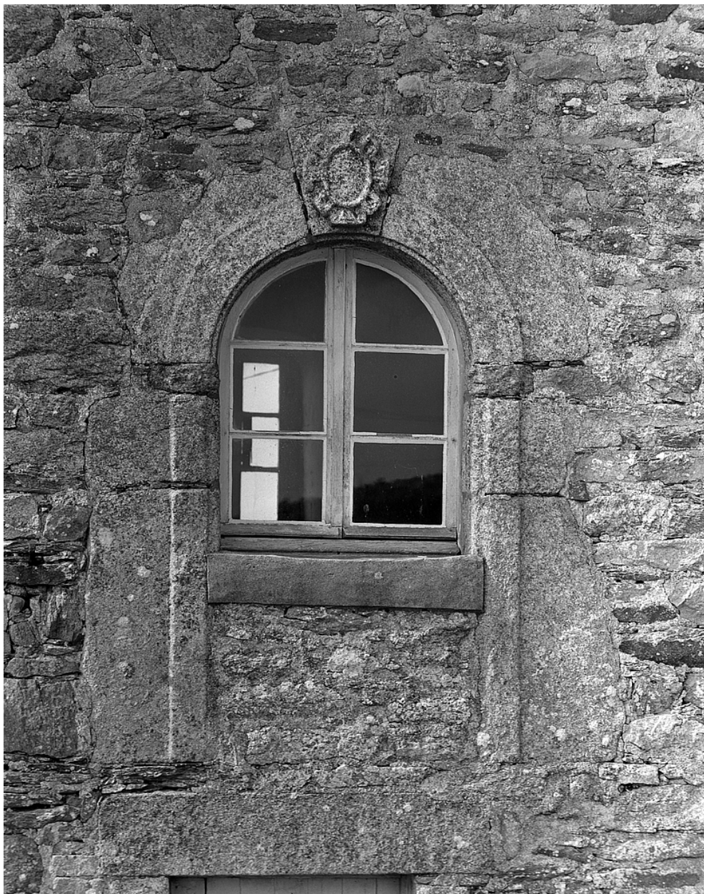
Logis, élévation est, détail fenêtre de l'étage
