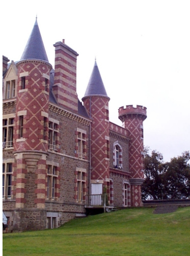
Elévation nord-ouest : vue générale Phot. Claude Quillivic IVR53_20003509080NUCA
