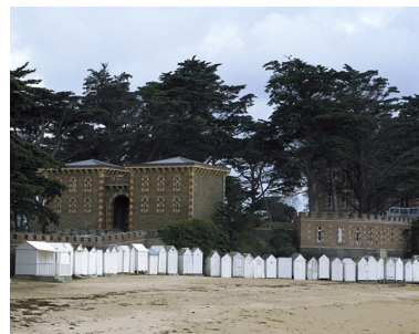
Vue de situation ouest Phot. Guy Artur, Phot. Norbert Lambert IVR53_19993501921XA
