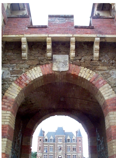
Vue depuis le corps de passage au nord Phot. Claude Quillivic IVR53_20003509079NUCA
