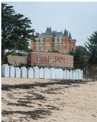
Vue de situation à l'ouest Phot. Charlotte Barraud IVR53_20223500019NUCA
