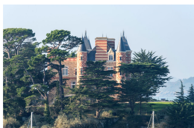
Vue générale depuis l'est Phot. Charlotte Barraud IVR53_20223500044NUCA
