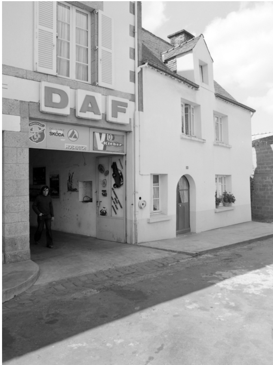
10 place Bisson, vue générale façade nord.
