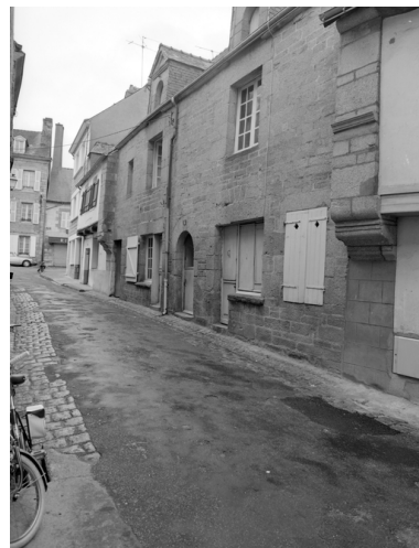
6-8 rue du Perroquet, vue générale des façades. Phot. François Dagorn IVR53_19745600438X
