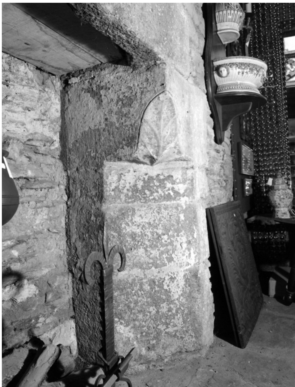
15 rue du fil, cheminée, détail.
