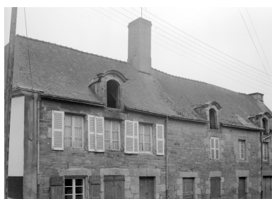
Angle des rues de la Fontaine et du Général Kenivet, vue de situation prise du sud-ouest. Phot. Brachet IVR53_19705600367V
