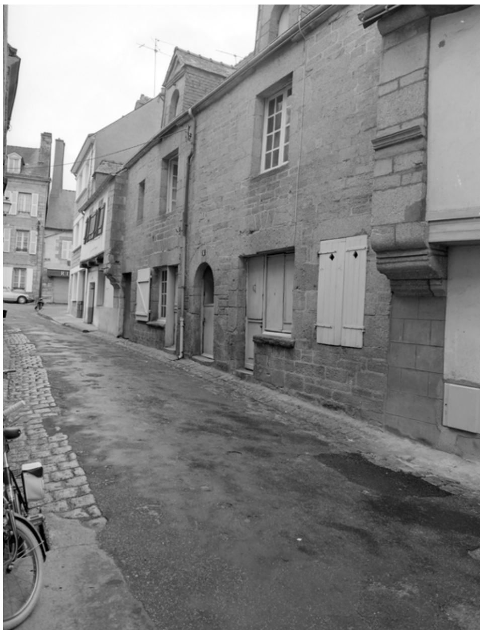
6-8 rue du Perroquet, vue générale des façades.
