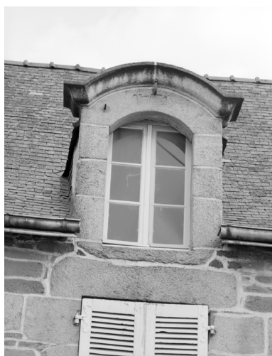
36 rue de la Fontaine, lucarne, détail. Phot. François Dagorn IVR53_19745600397X
