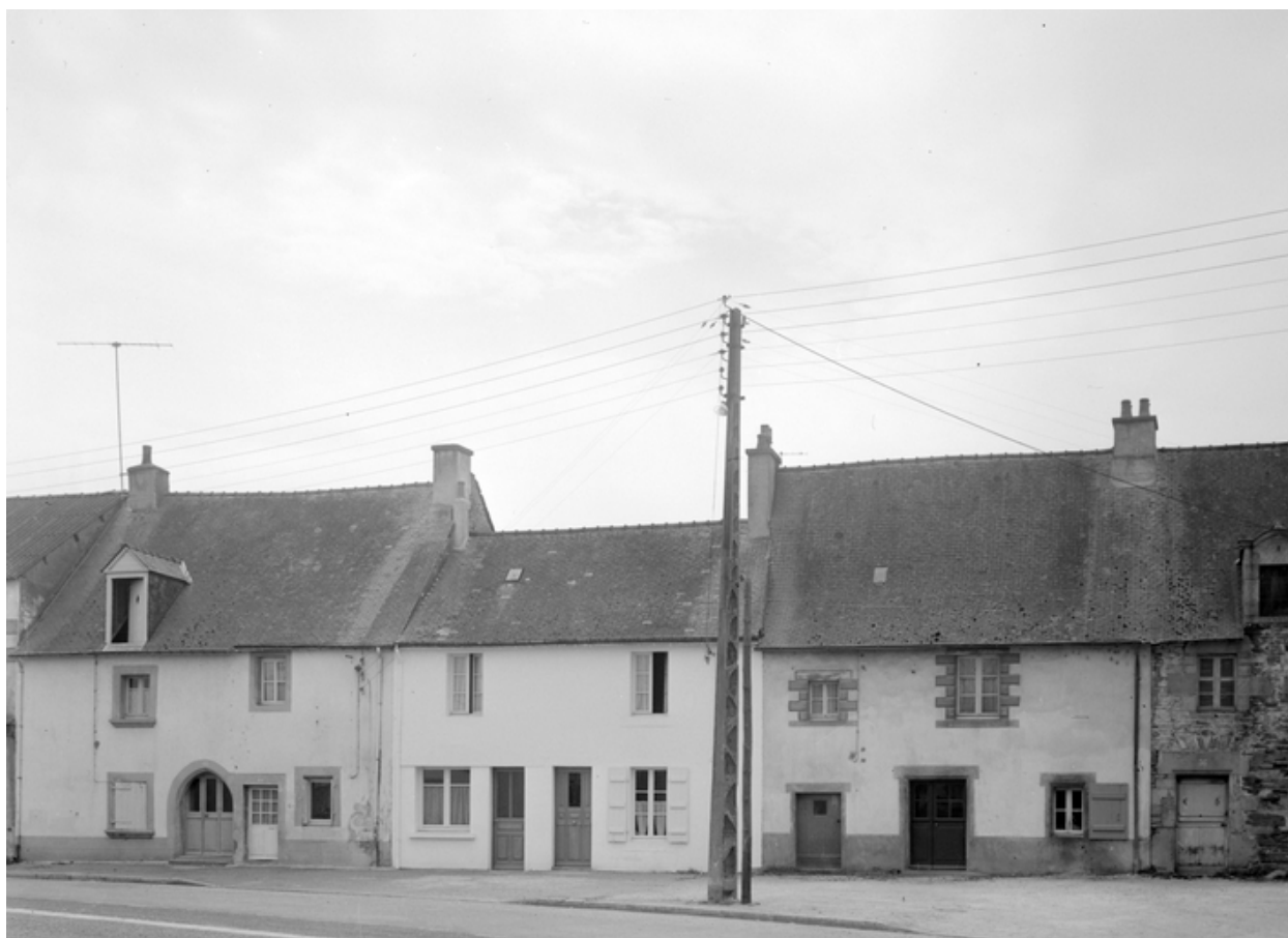
36 à 44 rue de la Fontaine, vue d'ensemble des façades est.
