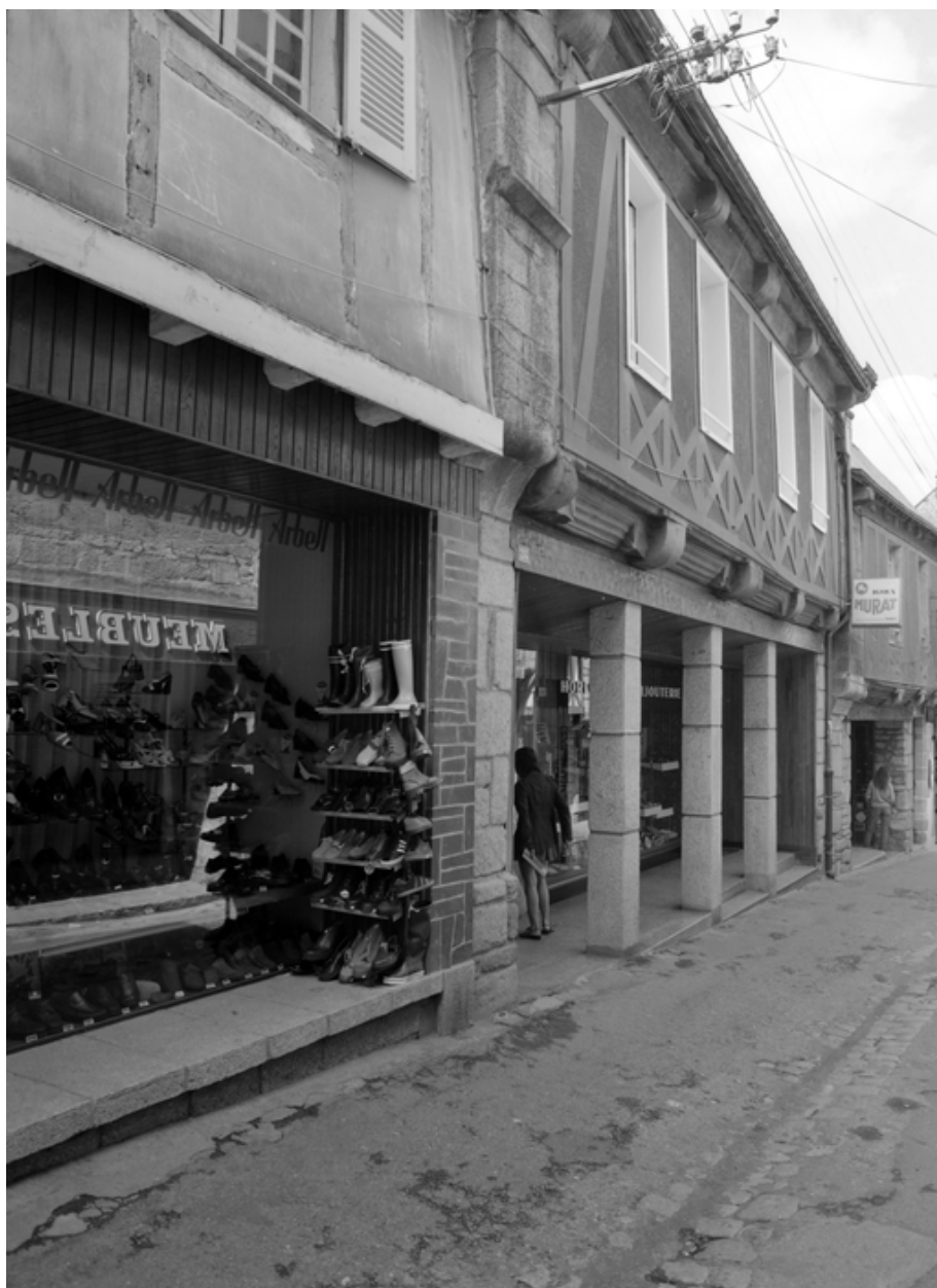
24 rue du Pont, vue générale de la façade.
