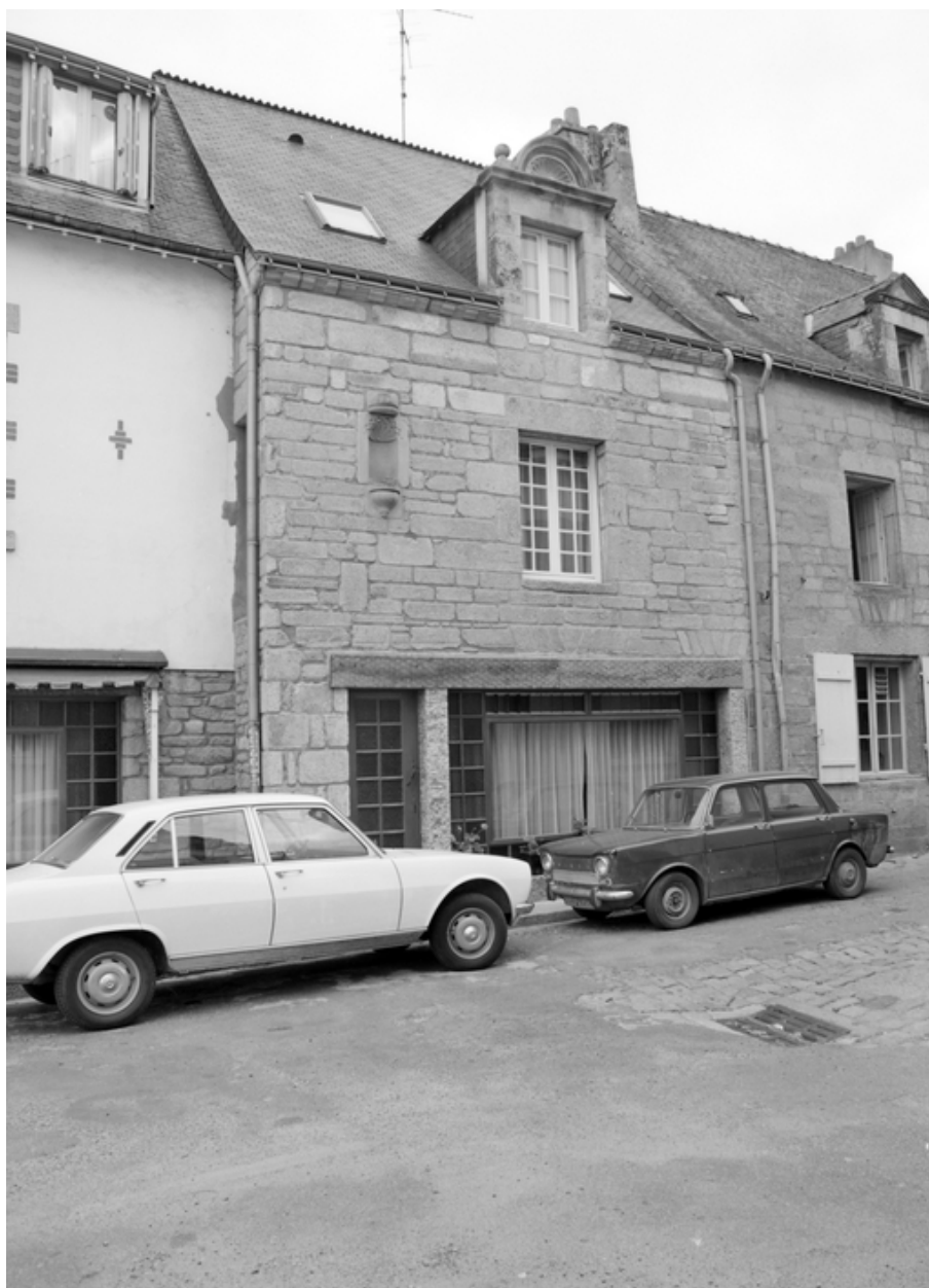
3 rue de l'Ancien Pont, vue générale de la façade.
