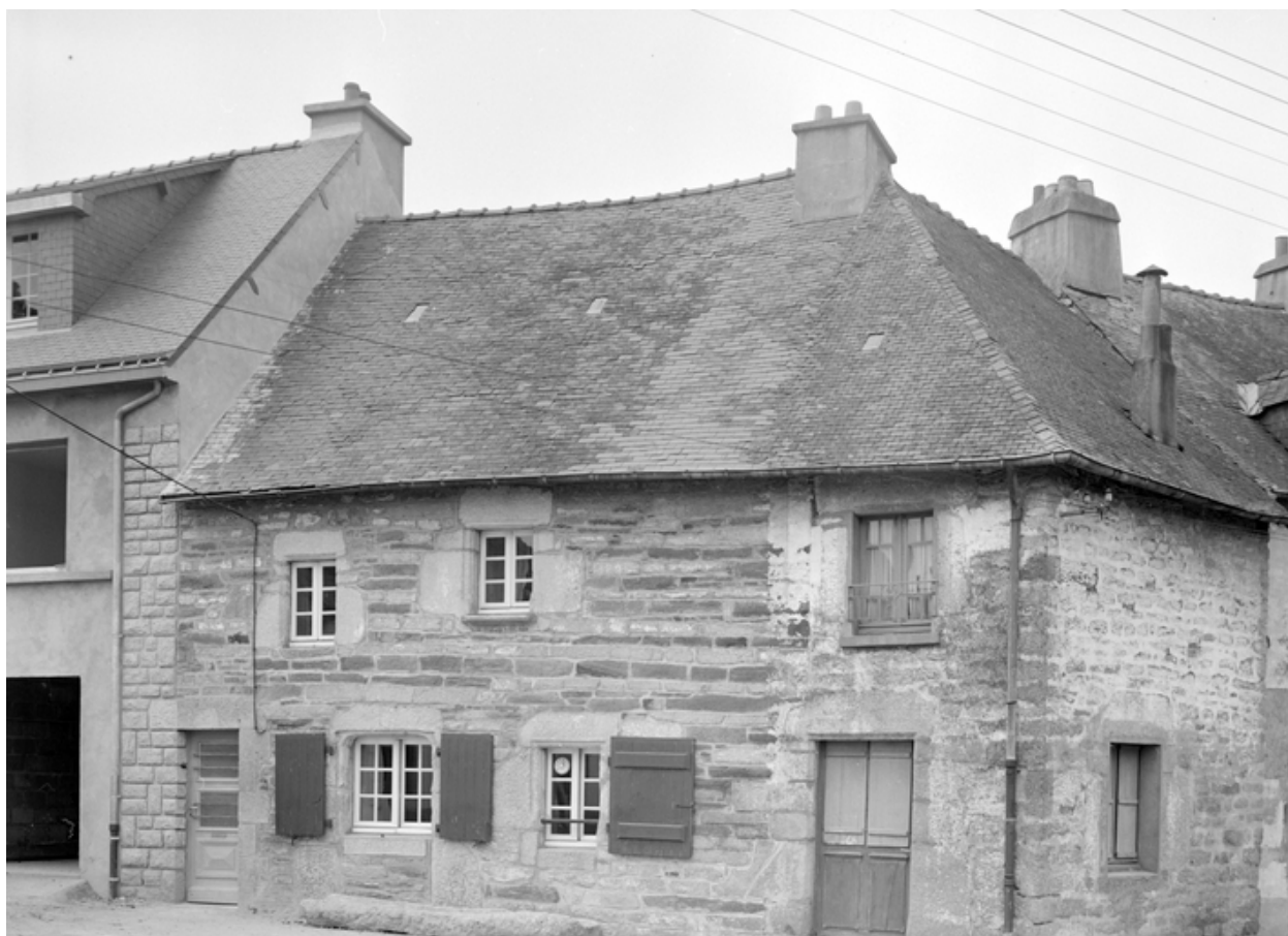
28 rue de la Fontaine, vue de situation prise de sud-est.
