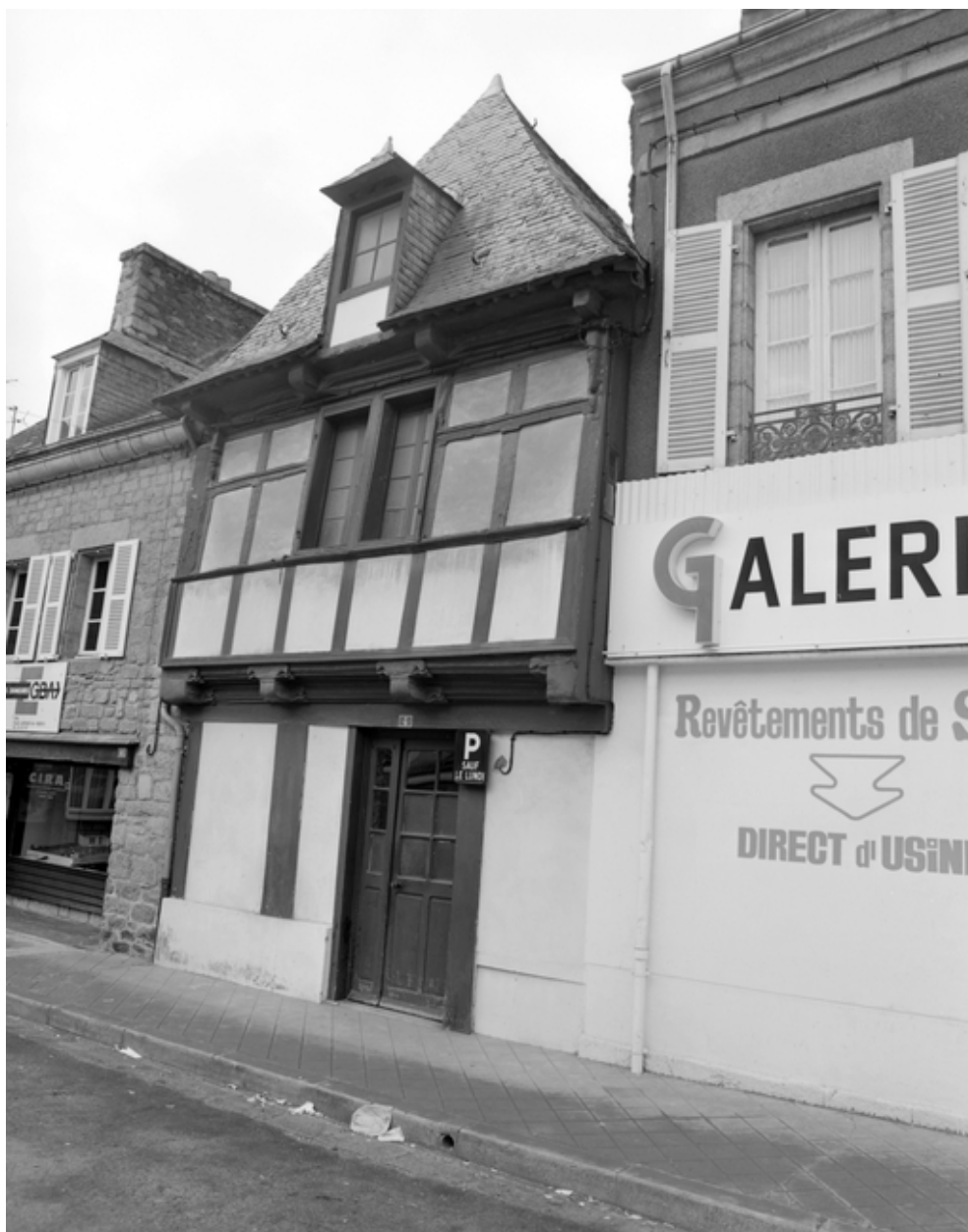
4 place Leperdit, vue générale.
