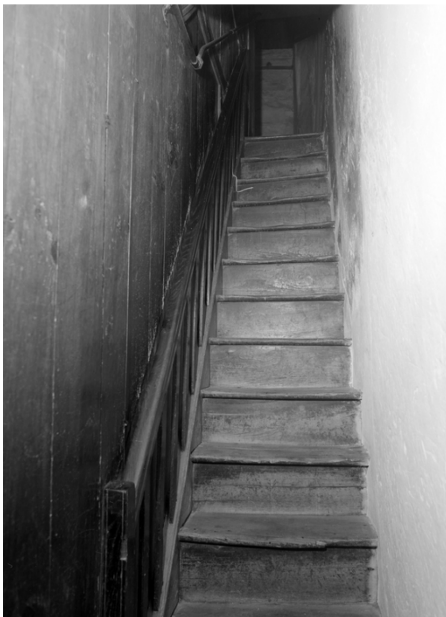
10 rue du fil, escalier, détail.
