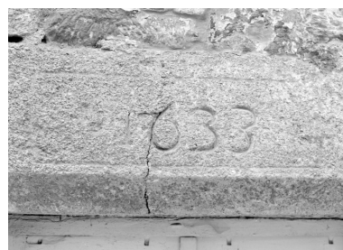
linteau daté 1633, 10-12 rue des Forges, détail. Phot. François Dagorn IVR53_19745600412X
