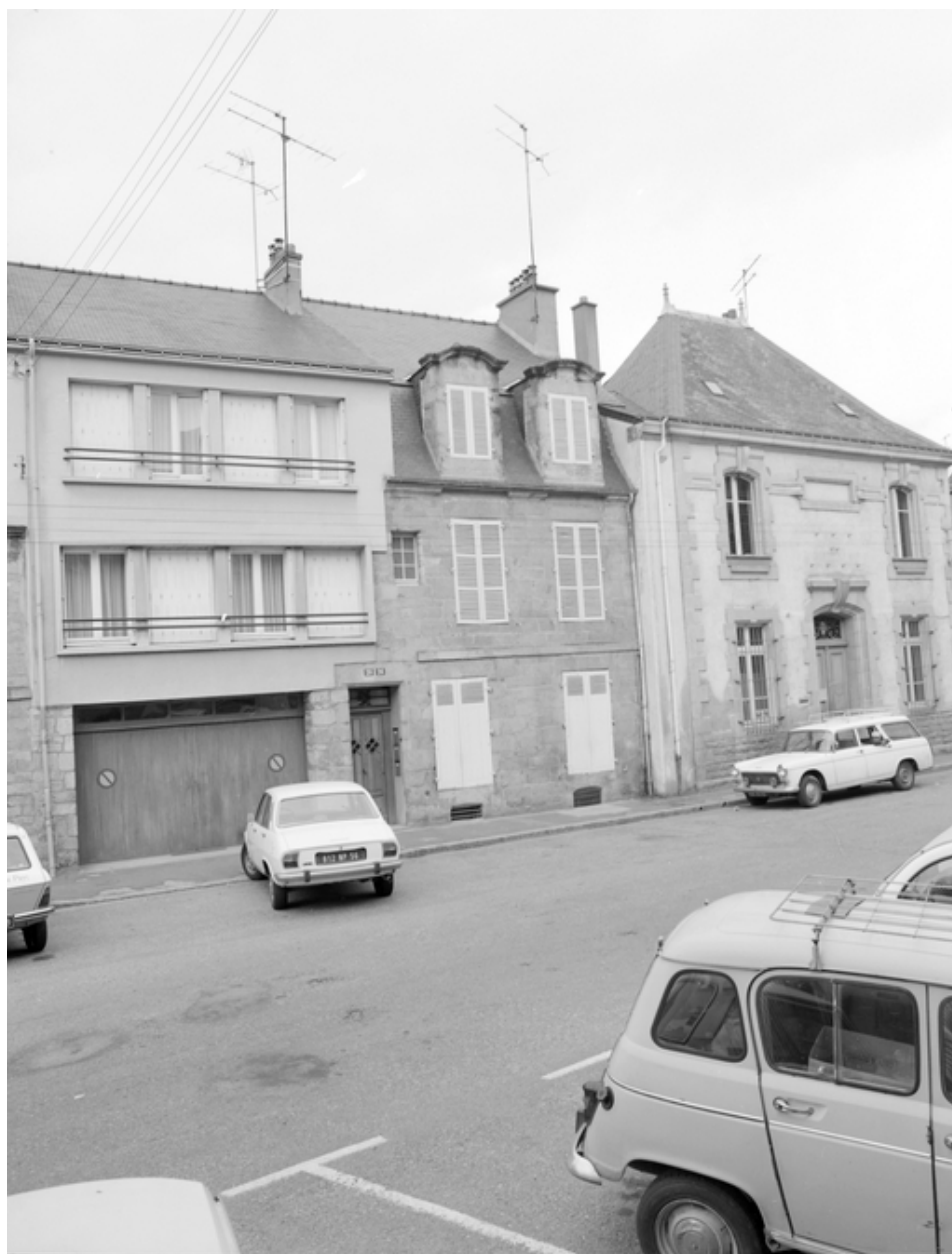
26 rue de Lourmel, vue générale de la façade.
