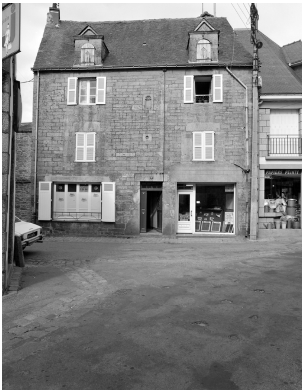
11 rue de l'Ancien Pont, vue générale de la façade.
