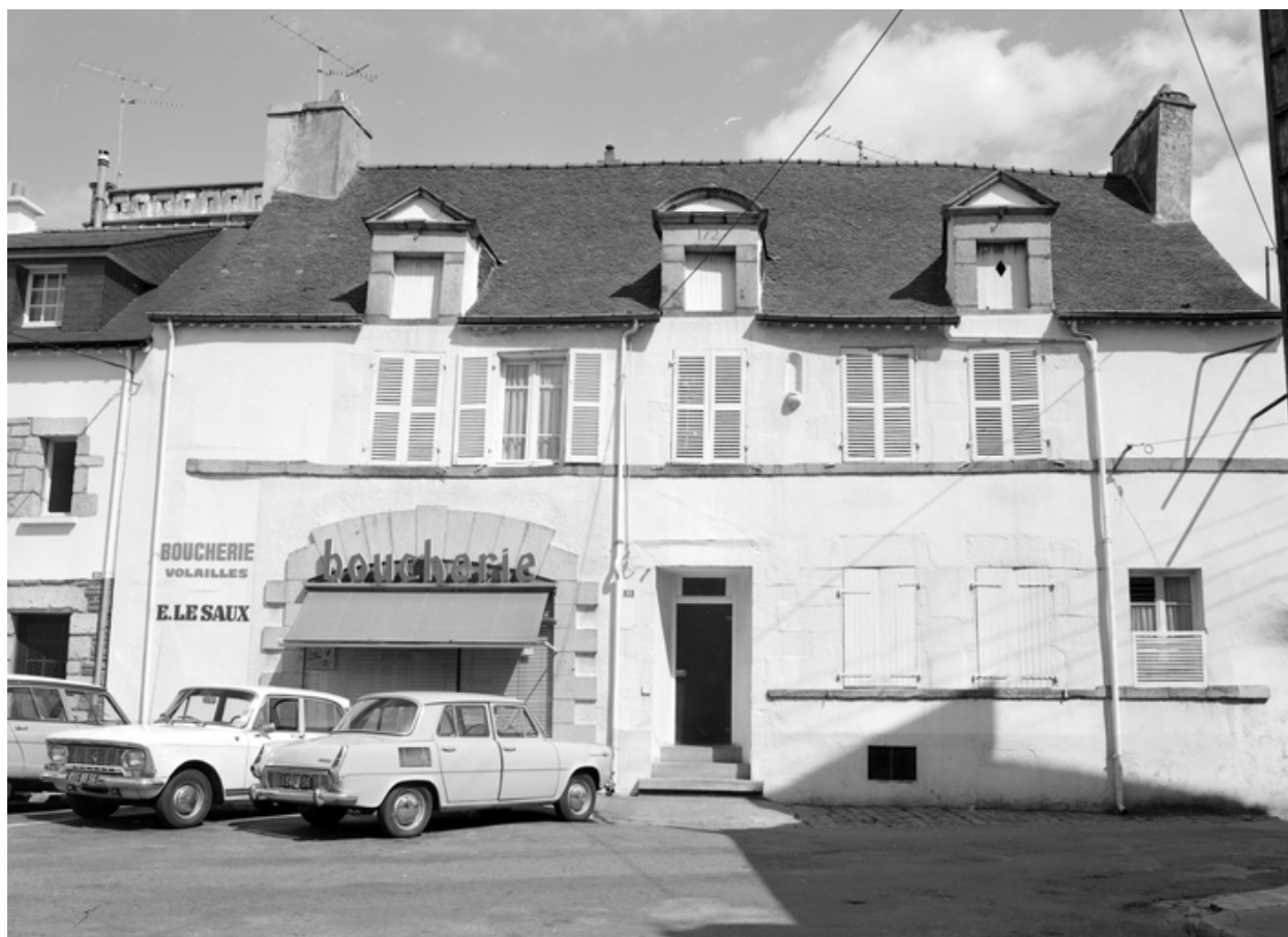
16 place Bisson, vue générale façade ouest.
