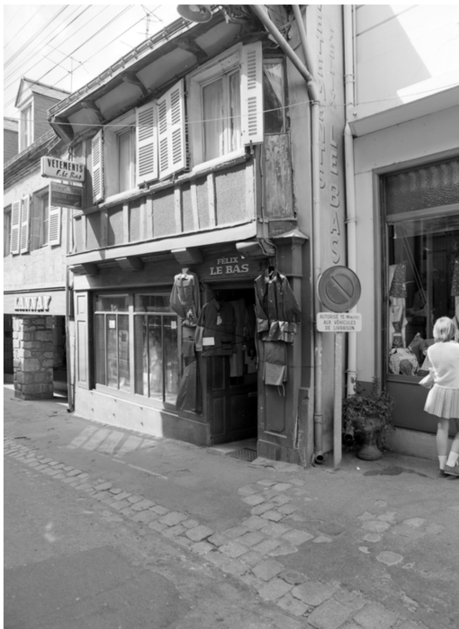
33 rue du Pont, vue générale de la façade.
