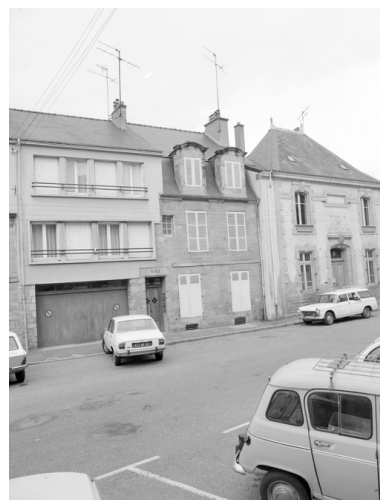
26 rue de Lourmel, vue générale de la façade.
