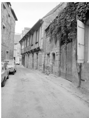
41 rue du Pont, vue générale. Phot. François Dagorn IVR53_19745600446X
