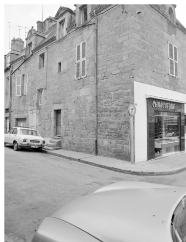
2 rue des Forges, vue générale de la façade. Phot. François Dagorn IVR53_19745600416X
