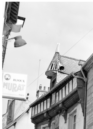
16 rue du Pont, détail lucarne. Phot. François Dagorn IVR53_19745600355X
