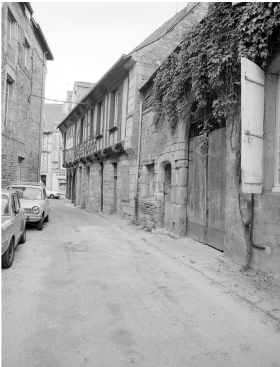
41 rue du Pont, vue générale.
