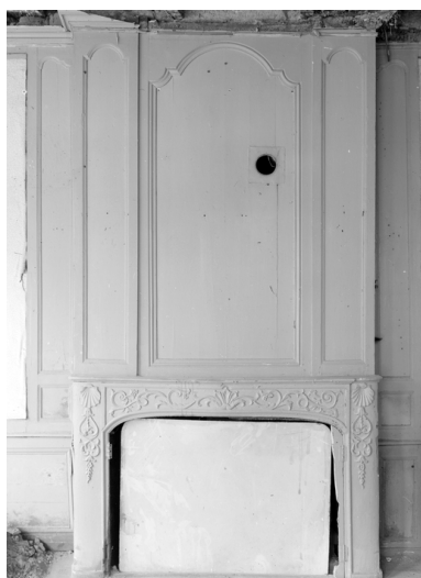
Maison EDF rue du Pont et place du Martray, cheminée. Phot. François Dagorn IVR53_19705600366V
