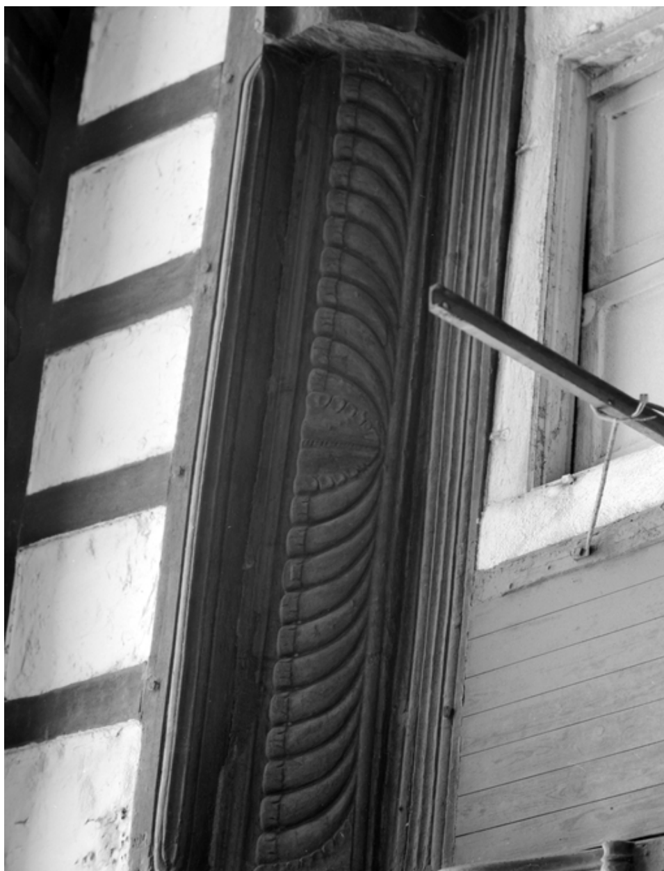
16 rue du Pont, décor sur la façade.
