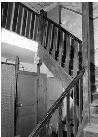
10 rue du fil, escalier, détail. Phot. François Dagorn IVR53_19745600591X
