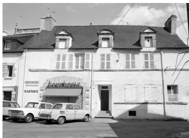
16 place Bisson, vue générale façade ouest. Phot. François Dagorn IVR53_19745600341X
