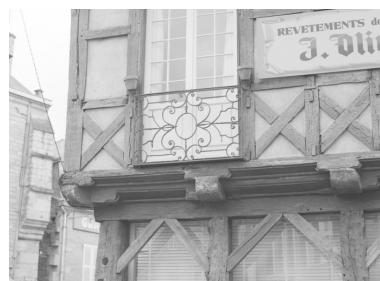
41 rue du Pont, détail garde-corps. Phot. François Dagorn IVR53_19745600447X
