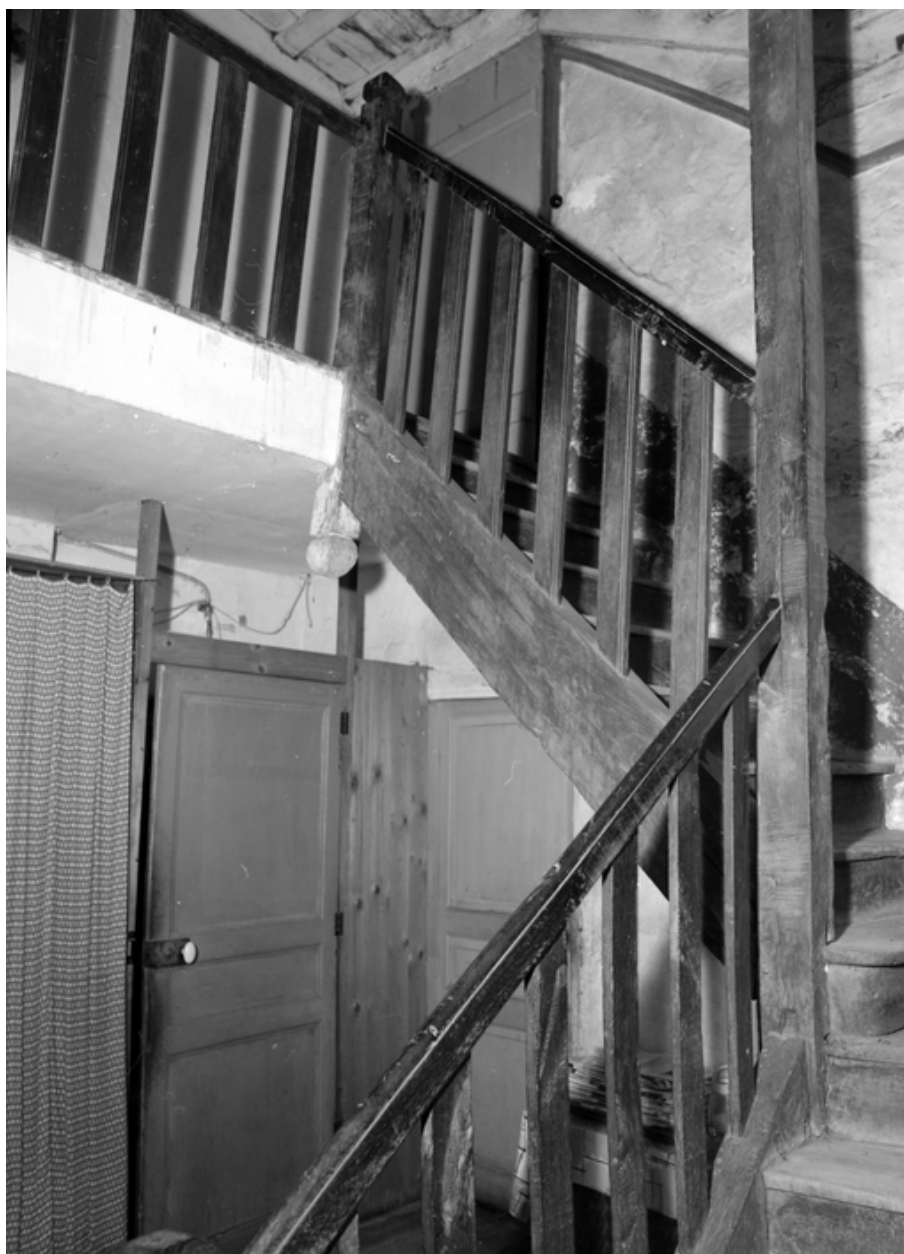
10 rue du fil, escalier, détail.
