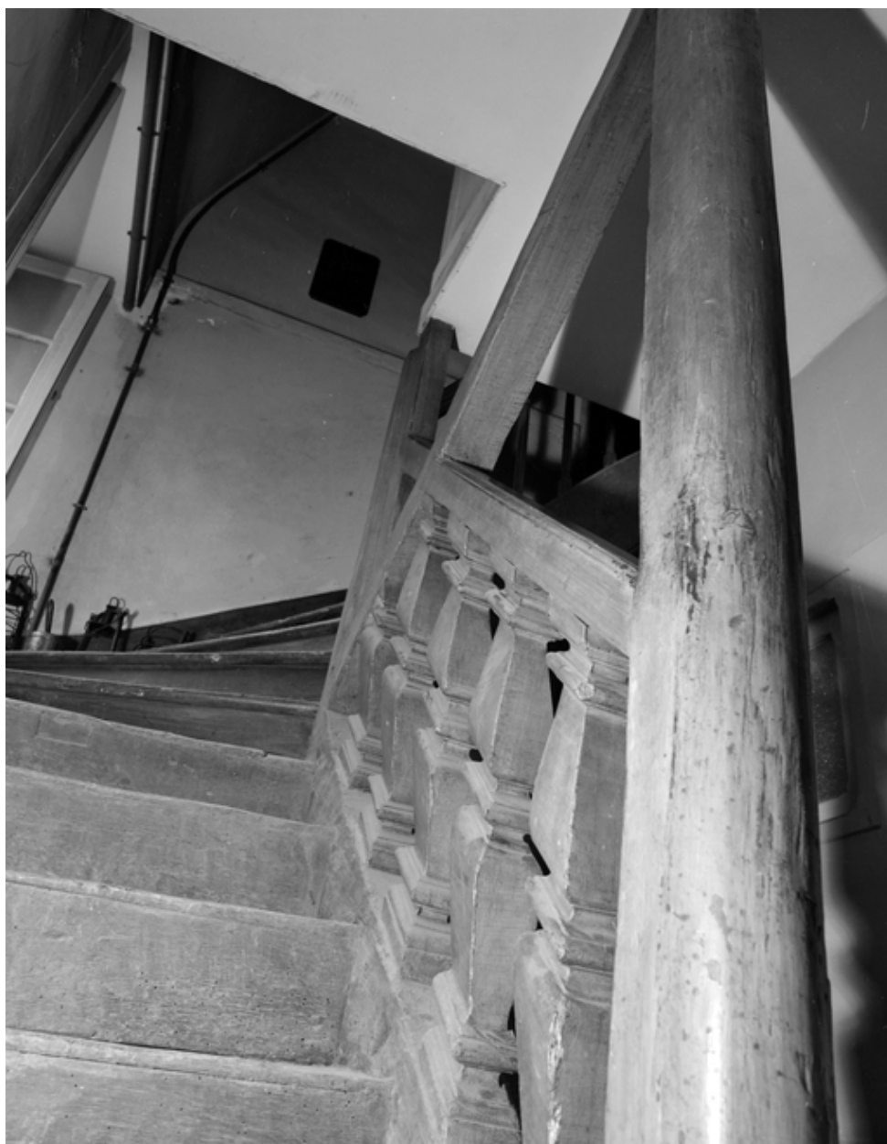
2 rue des Forges, escalier, détail.
