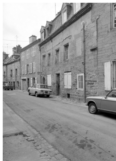
6 rue des Forges, vue générale de la façade. Phot. François Dagorn IVR53_19745600414X
