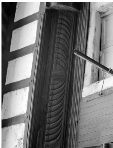
16 rue du Pont, décor sur la façade.
