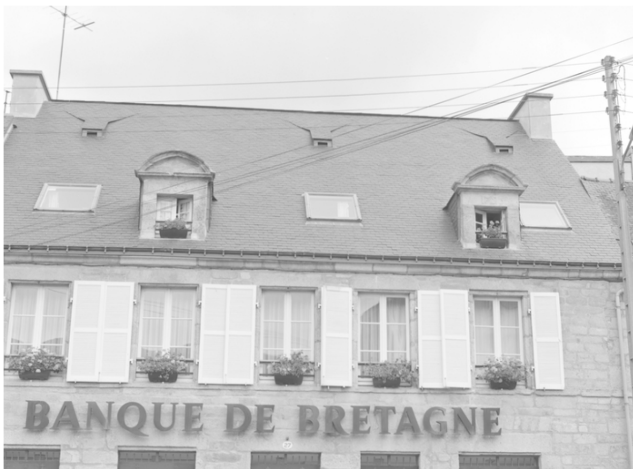
27 rue de Lourmel, lucarnes, détail.
