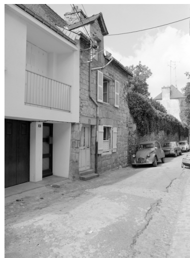
6 rue du Paradis, vue générale de la façade. Phot. François Dagorn IVR53_19745600371X
