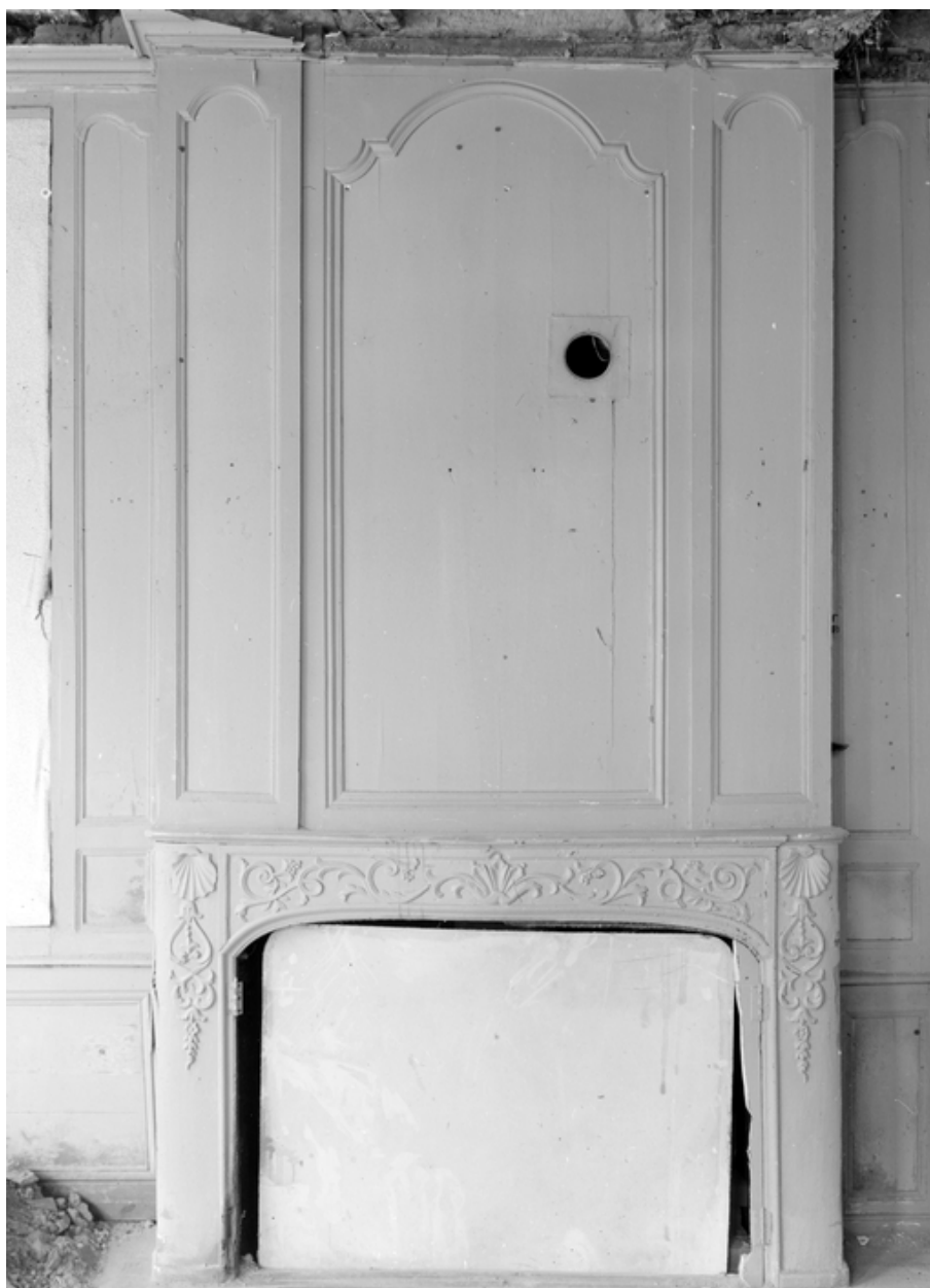
Maison EDF rue du Pont et place du Martray, cheminée.
