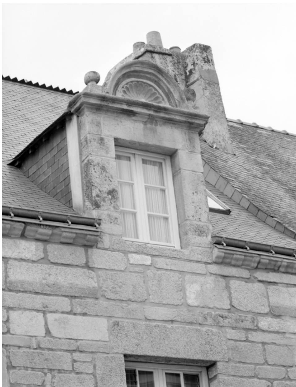
3 rue de l'Ancien Pont, détail, lucarne.
