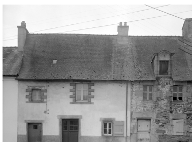
36 et 38 rue de la Fontaine, vue d'ensemble des façades est. Phot. Brachet IVR53_19705600365V
