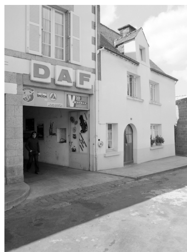
10 place Bisson, vue générale façade nord.
