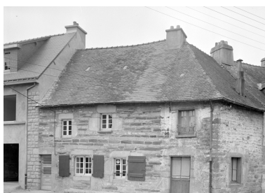
28 rue de la Fontaine, vue de situation prise de sud-est. Phot. Brachet IVR53_19705600362V
