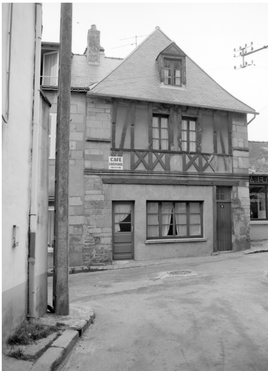
9 rue de la Motte, vue générale de la façade.
