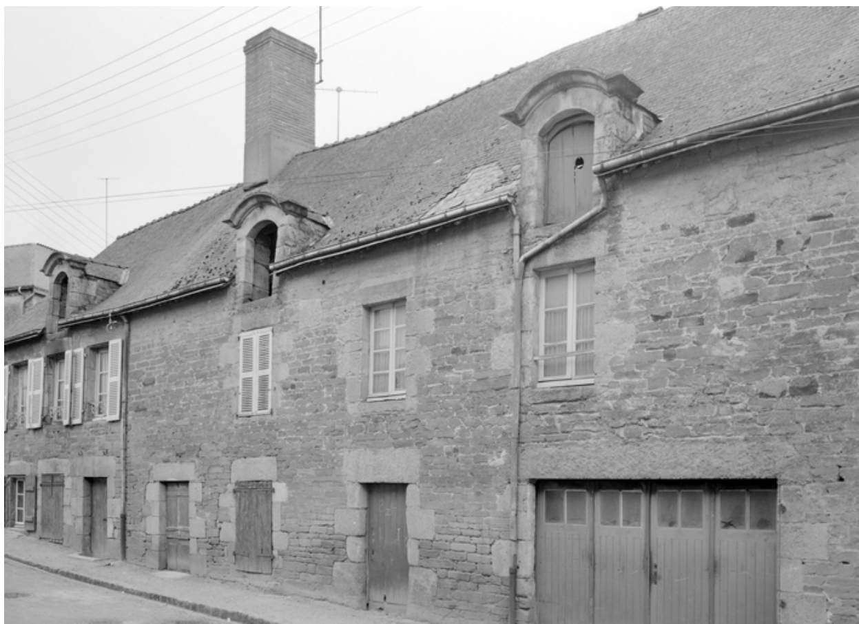
Angle des rues de la Fontaine et du Général Kenivet, vue d'ensemble de la façade ouest.
