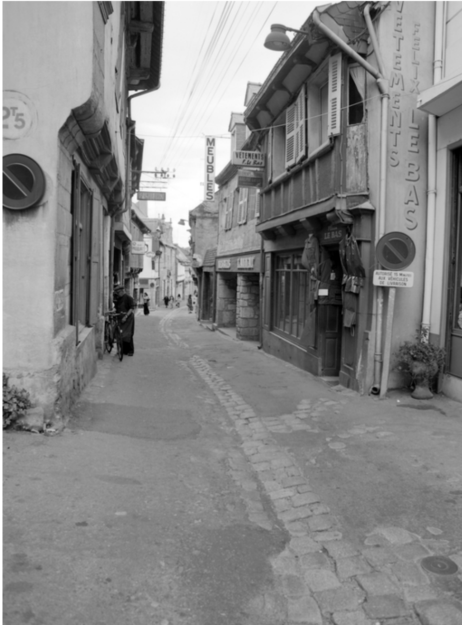
Rue du pont, vue générale.
