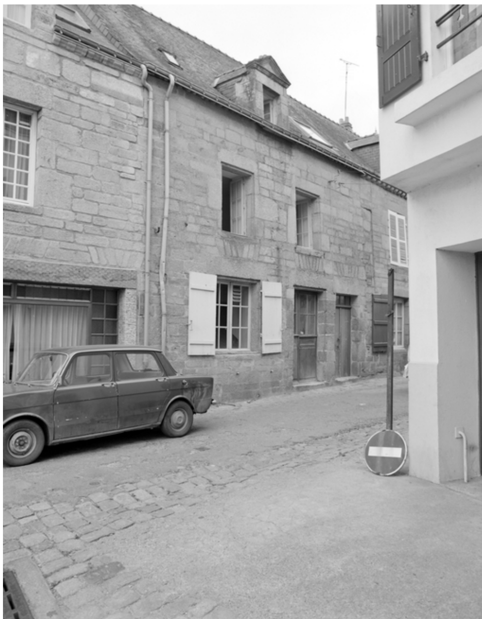
5 rue de l'Ancien Pont, vue générale de la façade.
