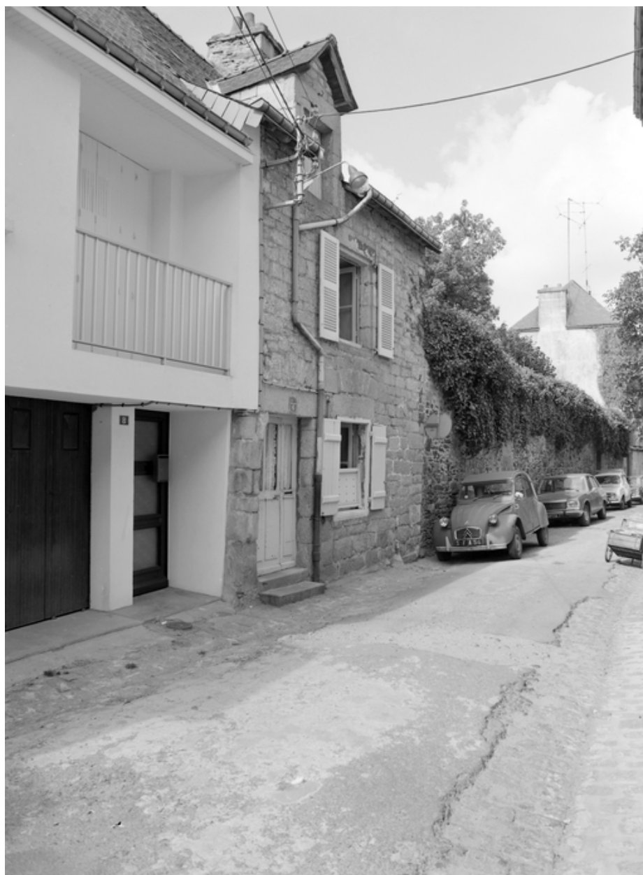
6 rue du Paradis, vue générale de la façade.
