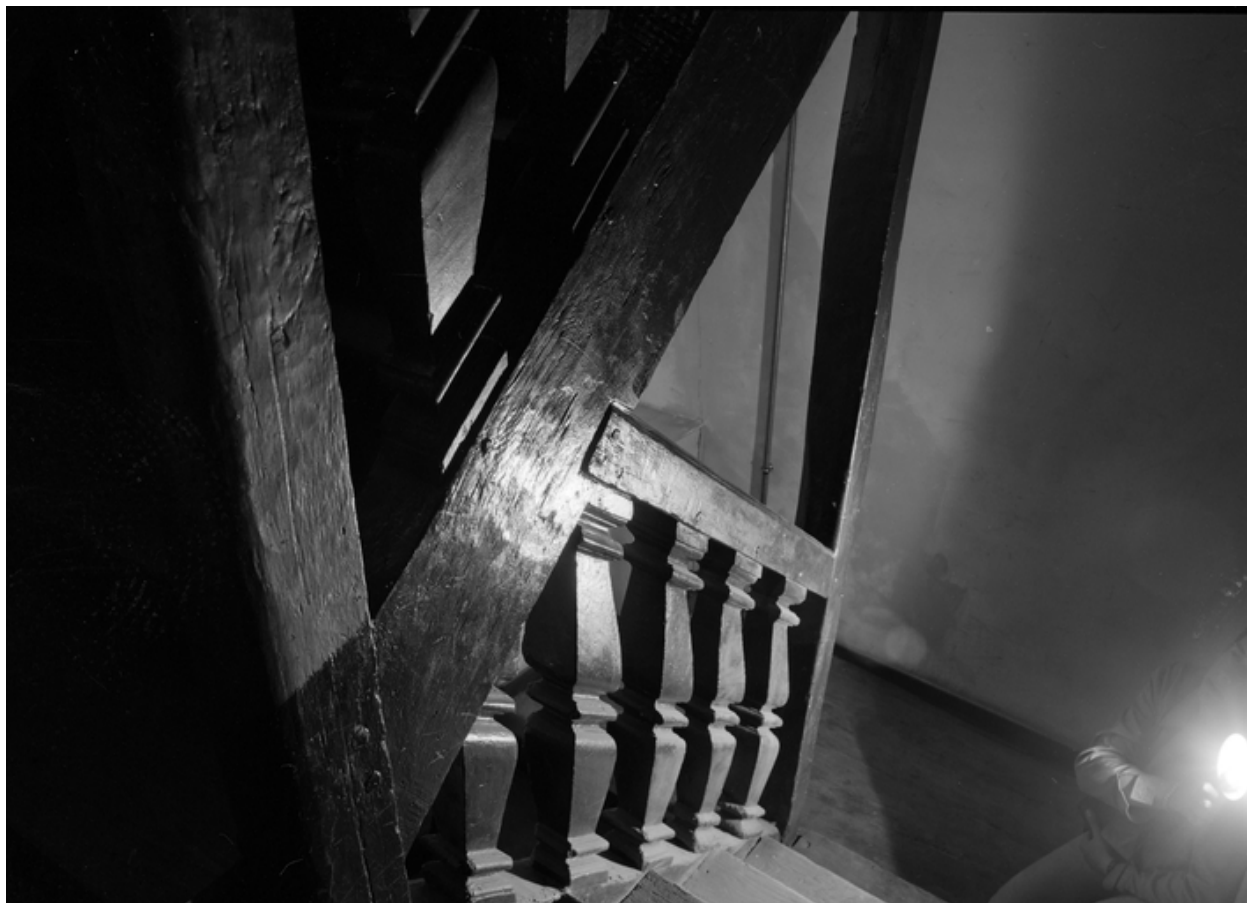
2 rue des Forges, escalier, détail.
