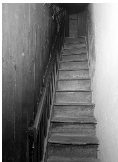
10 rue du fil, escalier, détail. Phot. François Dagorn IVR53_19745600590X
