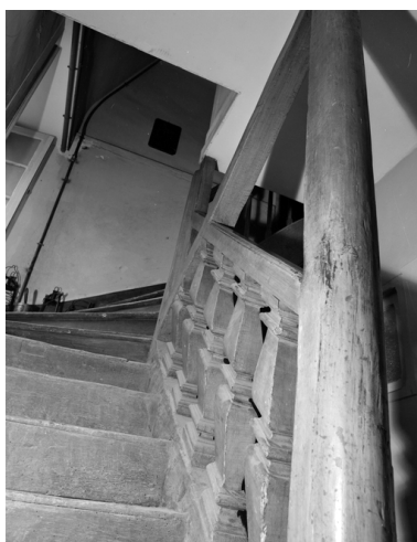
2 rue des Forges, escalier, détail. Phot. François Dagorn IVR53_19745600419X
