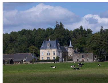
Vue générale prise du sud Phot. Bernard Bègne IVR53_20115601732NUCA
