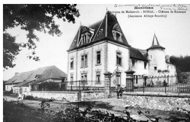
Vue générale prise du sud- est, carte postale, 1er quart 20e siècle (A. D. Ille-&-Vilaine, 6 Fi) Autr. Ch. Bailly IVR53_20045606239NUCB
