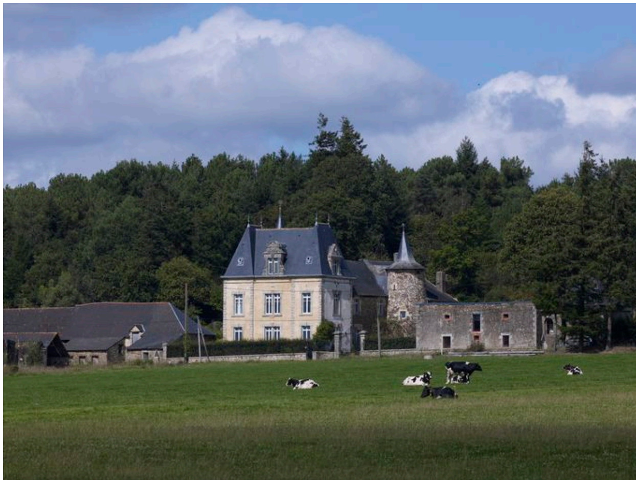
Vue générale prise du sud
