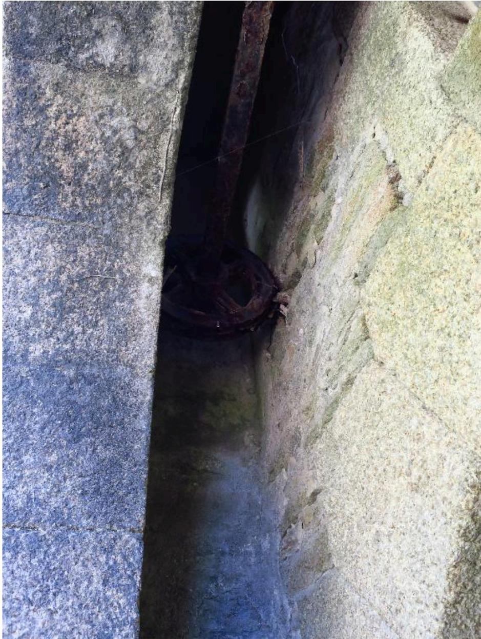
Groix, batterie de Nosterven, corps de garde crénelé, mécanisme du pont-levis.
