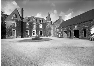
Vue générale sud-est. Phot. François Dagorn IVR53_19775600701V
