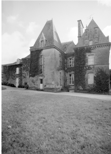
Elévation ouest du logis A. Phot. François Dagorn IVR53_19775600702V
