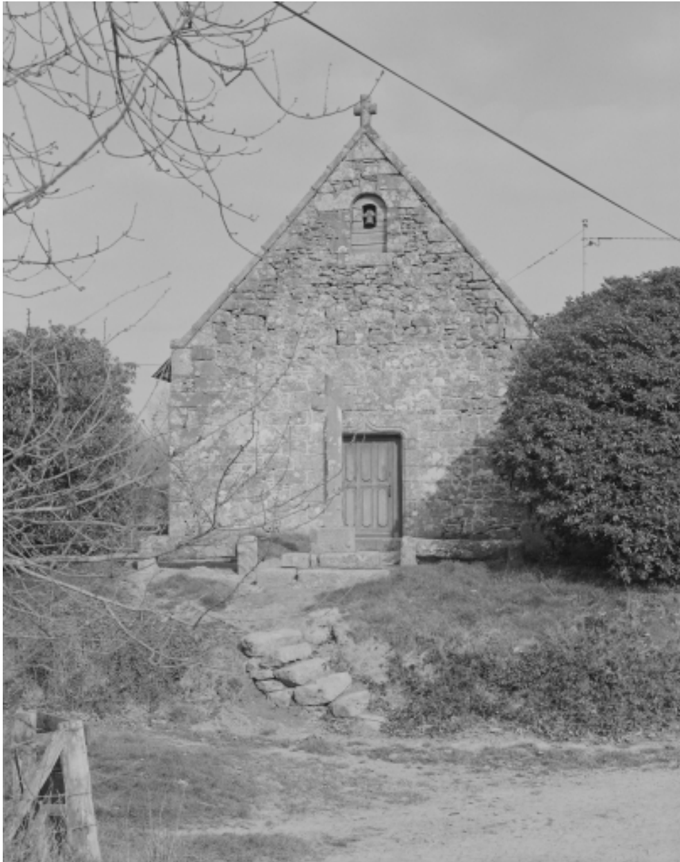
Elévation Ouest : vue générale
