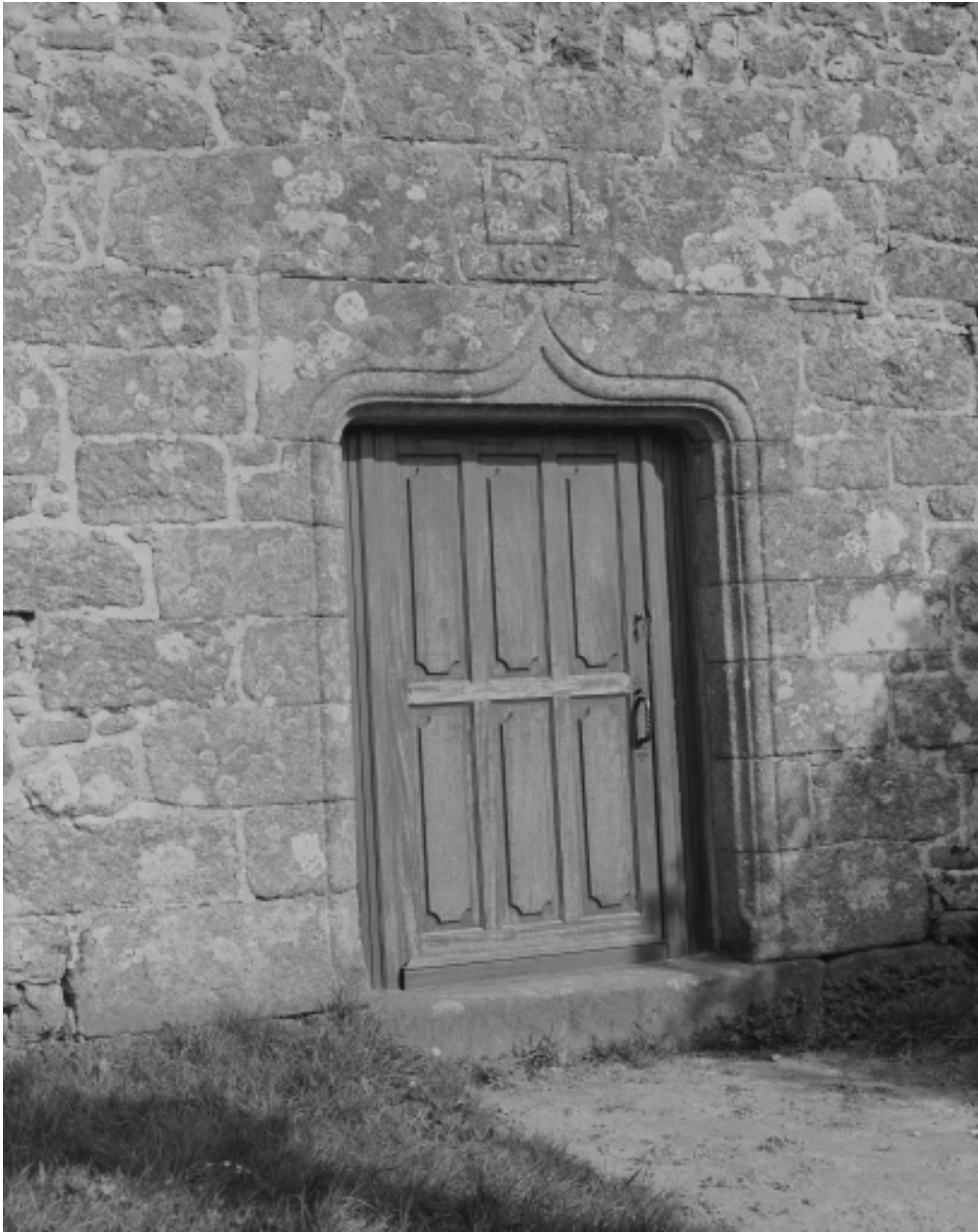
Elévation Ouest, porte : vue générale
