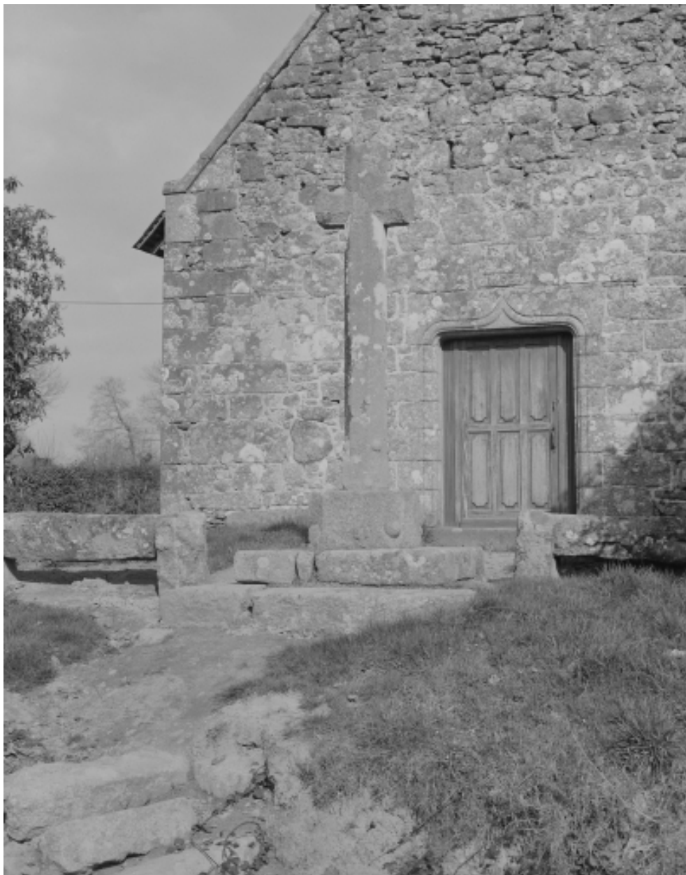
Croix monumentale, face Ouest : vue générale
