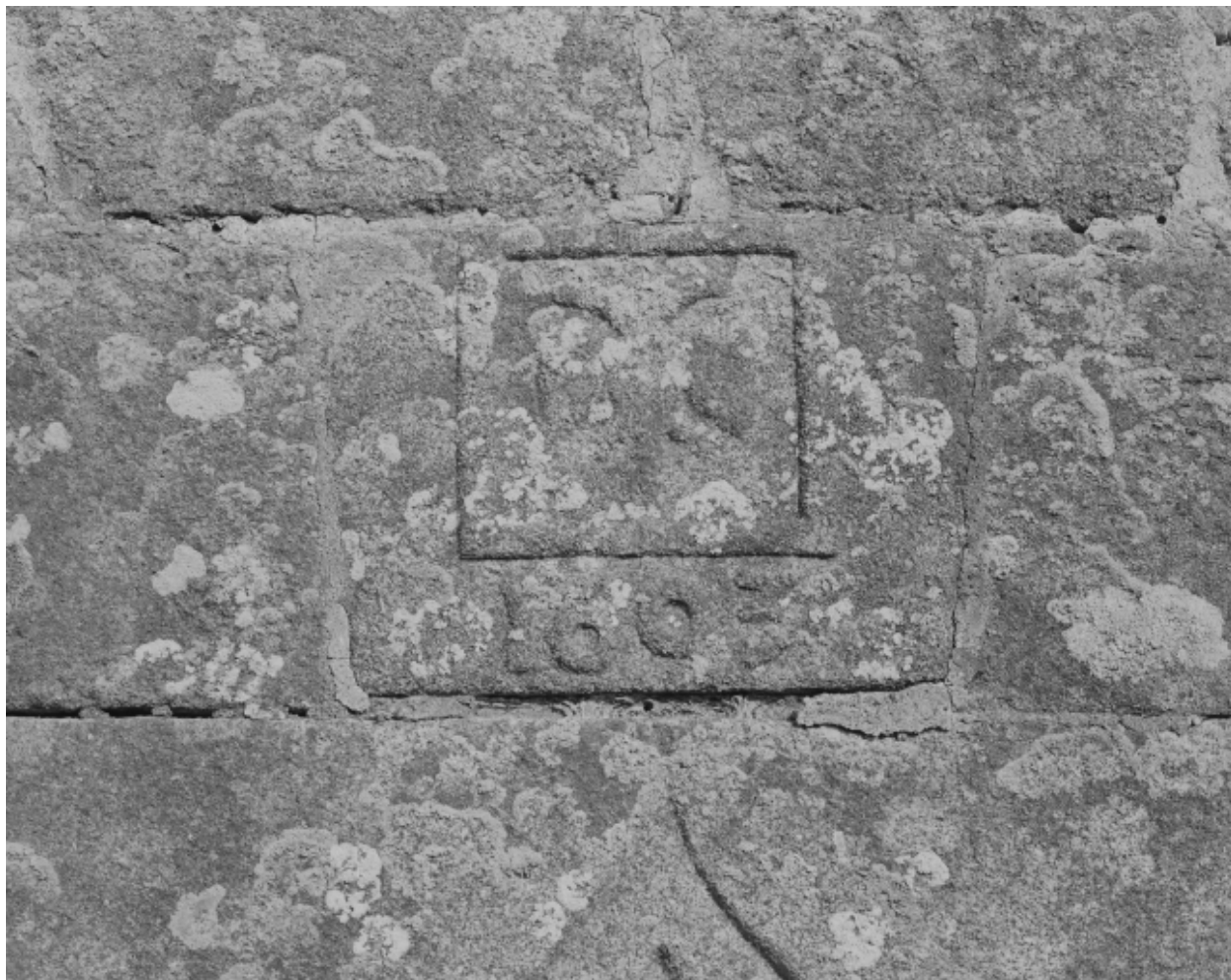
Elévation Ouest, porte datée 1603 : détail d'une pierre
