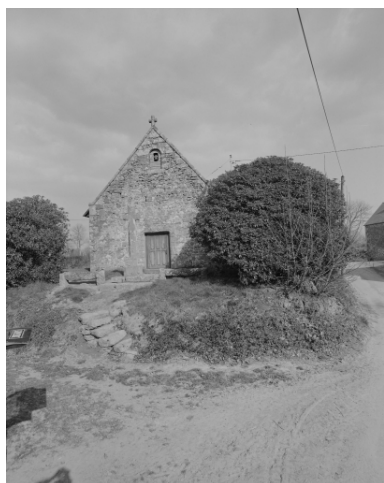
Elévation Ouest : vue de situation Phot. Bernard Bègne, Phot. M. Loyon IVR53_19933500335X
