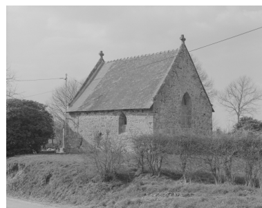
Elévation Sud-Est : vue générale Phot. Bernard Bègne, Phot. M. Loyon IVR53_19933500339X
