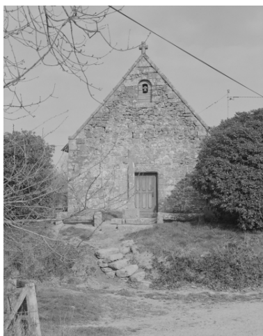
Elévation Ouest : vue générale Phot. Bernard Bègne, Phot. M. Loyon IVR53_19933500337X
