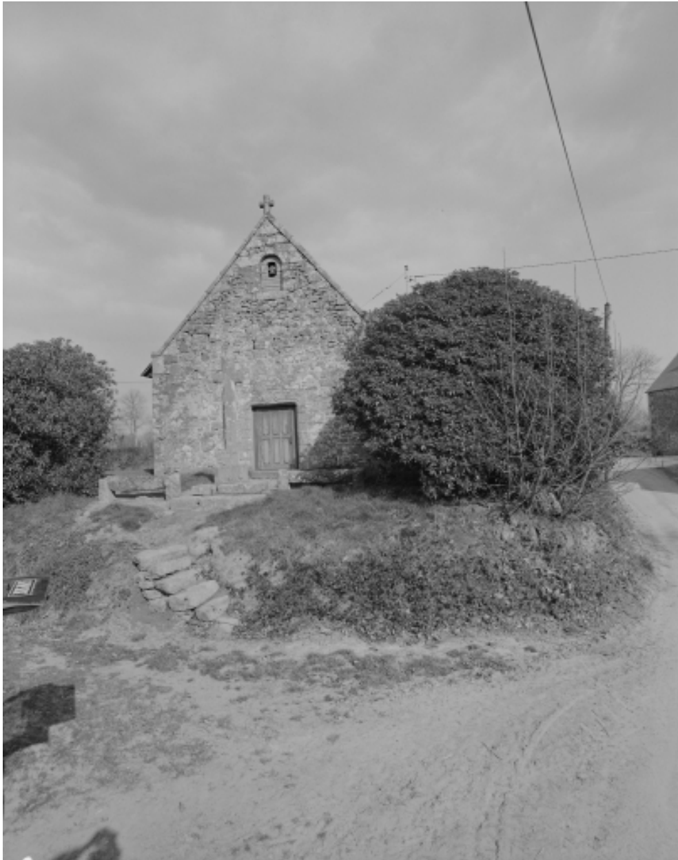
Elévation Ouest : vue de situation
