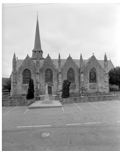
Façade sud de l'église Repro. Guy Artur, Repro. Norbert Lambart IVR53_19943501510XB
