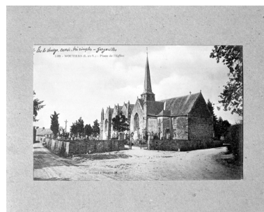
Carte postale, vue sud-est, église et cimetière paroissial Repro. Guy Artur, Repro. Norbert Lambart IVR53_19933500800XB
