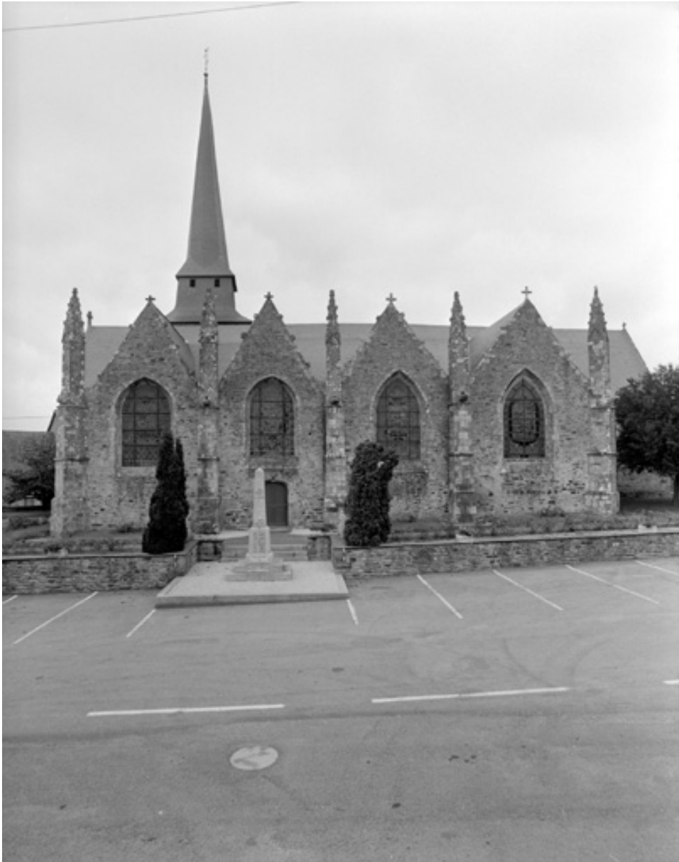
Façade sud de l'église
