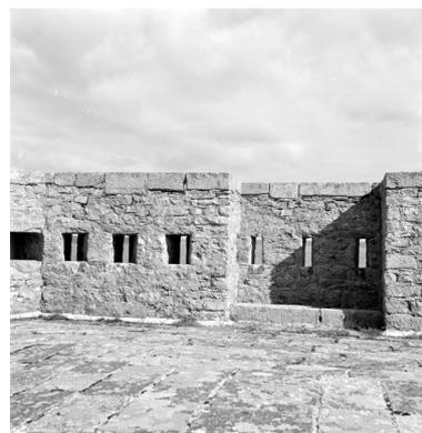
Camaret-sur-Mer, pointe du Toulinguet : vue de la tour-modèle n° 3 en 1969, terrasse, parapet percé de créneaux de fusillade
