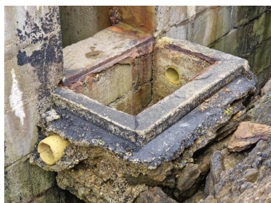
Vue du puisard subsistant devant l'entrée ouest de l'élévation nord. De ce côté, l'érosion marine a emporté le substrat de l'îlot : entrée et puisard sont dans le vide Phot. Guillaume Lécueillier IVR53_20242911251NUCA
