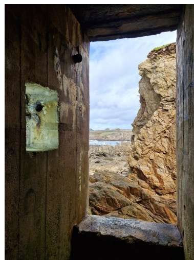
Vue intérieure : salle de garde est. Le bunker est construit avec des parpaings dans lesquels a été coulé le béton Phot. Guillaume Lécueillier IVR53_20242911272NUCA
