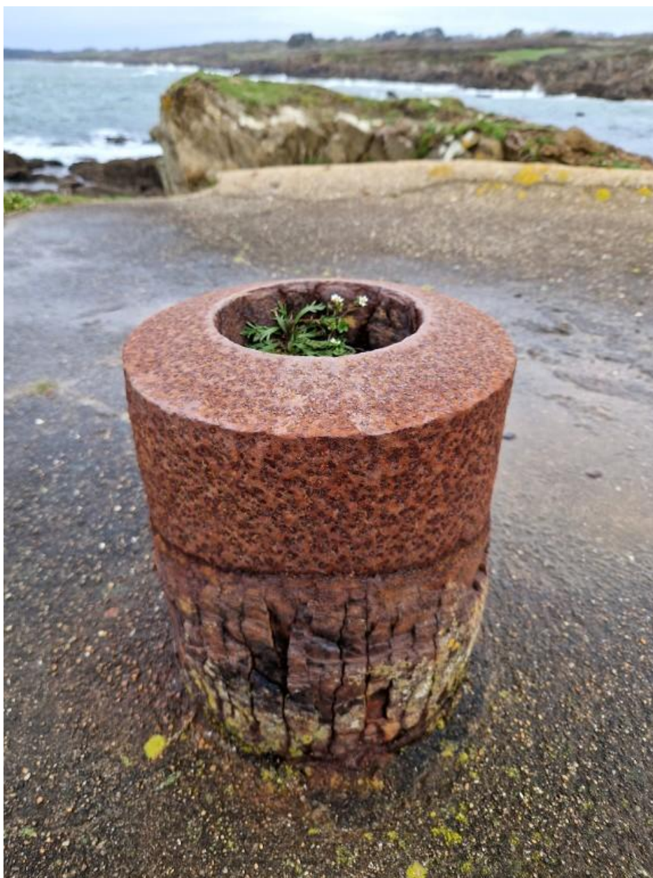
Vue du conduit du périscope émergeant de la dalle de couverture
