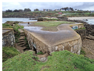
Vue générale depuis le sud. L'accès sud - visible sur la photographie - est percé dans l'élévation ouest. A gauche, le Tobruk pour mortier Phot. Guillaume Lécueillier IVR53_20242911253NUCA
