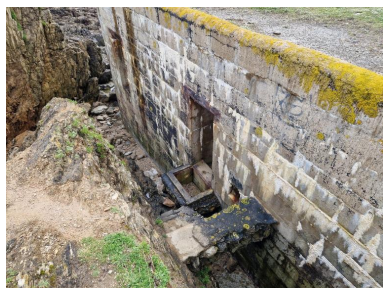
Vue de l'élévation nord avec ses deux entrées. De ce côté, l'érosion marine a emporté le substrat de l'îlot : entrées, puisard et escalier sont dans le vide Phot. Guillaume Lécueillier IVR53_20242911248NUCA
