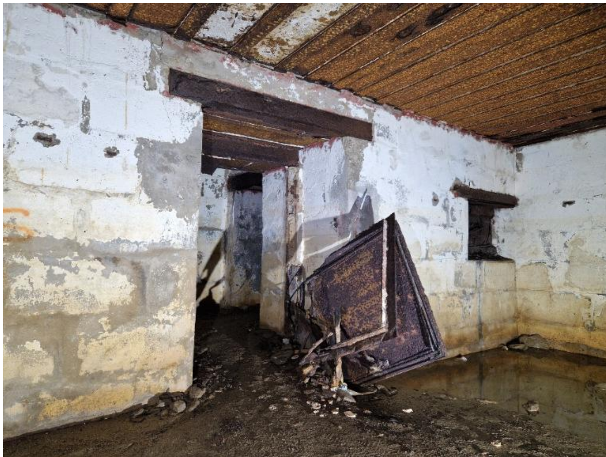
Vue intérieure : salle de garde ouest, vestiges de la porte de l'accès sud. A droite, le créneau blindée de défense
