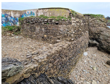
Vue depuis le sud-sud-est. La maçonnerie de moellon masque le bunker - abri Phot. Guillaume Lécueillier IVR53_20242911231NUCA
