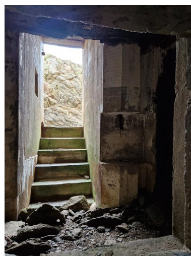
Vue intérieure : entrée ouest de l'accès nord à travers le créneau blindé de la salle de garde ouest Phot. Guillaume Lécueillier IVR53_20242911270NUCA
