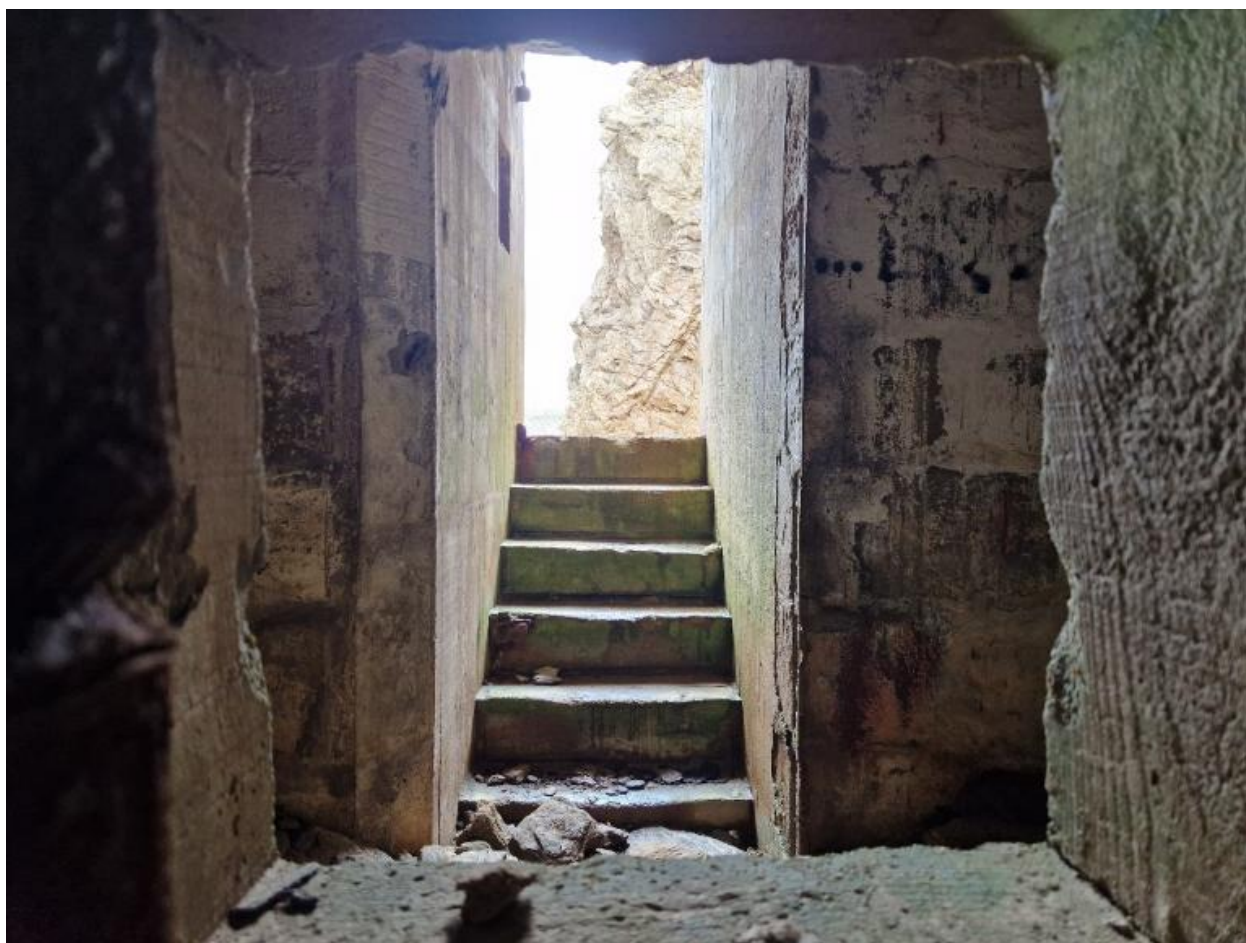
Vue intérieure : accès nord, entrée ouest à travers le créneau blindé de la salle de garde est
