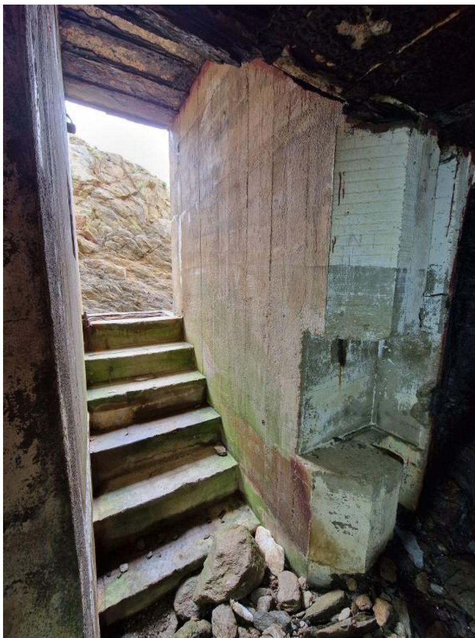
Vue intérieure : accès nord (entrée ouest). A droite, pan coupé du couloir d'accès au sas
