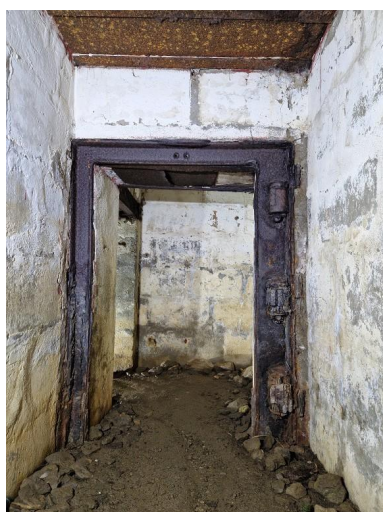
Vue intérieure : accès sud avec l'huissierie de la porte blindée Phot. Guillaume Lécueillier IVR53_20242911257NUCA
