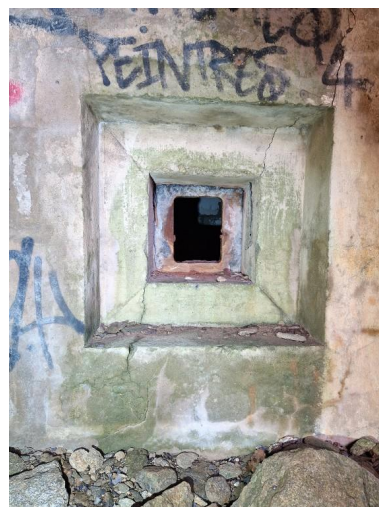
Vue intérieure : accès nord (entrée est) défendue par un créneau blindé Phot. Guillaume Lécueillier IVR53_20242911280NUCA
