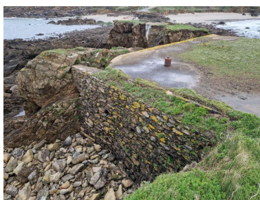
Vue générale. La maçonnerie de moellon masque le bunker - abri à l'ouest. A droite, la dalle de couverture du bunker : le conduit du périscope émerge de la dalle de couverture Phot. Guillaume Lécueillier IVR53_20242911240NUCA
