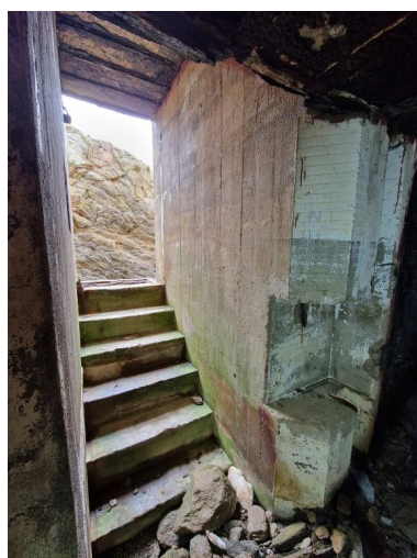
Vue intérieure : accès nord (entrée ouest). A droite, pan coupé du couloir d'accès au sas Phot. Guillaume Lécueillier IVR53_20242911276NUCA
