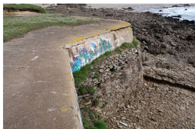
Vue depuis le sud-ouest. La maçonnerie de moellon masque le bunker - abri Phot. Guillaume Lécueillier IVR53_20242911230NUCA
