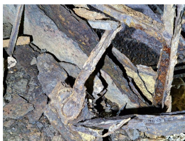
Vue intérieure : salle de garde ouest, vestiges de la porte de l'accès sud Phot. Guillaume Lécueillier IVR53_20242911260NUCA
