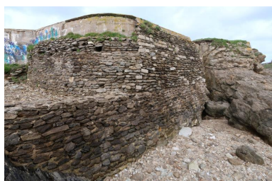
Vue depuis le sud-sud-est. La maçonnerie de moellon masque le bunker - abri Phot. Guillaume Lécueillier IVR53_20242911233NUCA
