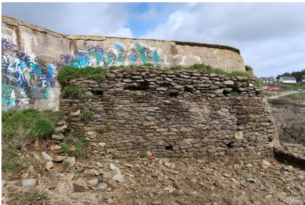
Vue depuis le sud. La maçonnerie de moellon masque le bunker - abri
