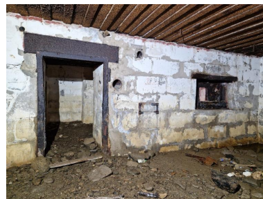
Vue intérieure : salle de garde est. La porte donne sur les accès nord (est et ouest) Phot. Guillaume Lécueillier IVR53_20242911268NUCA
