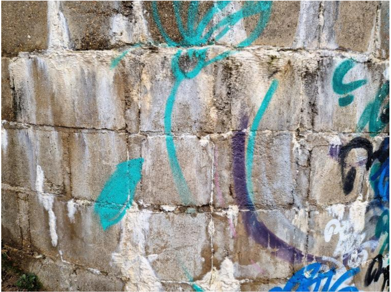
Vue de détail au sud-est. Le bunker est construit avec des parpaings dans lesquels a été coulé le béton. Il est tagué
