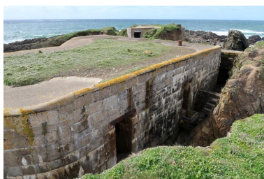
Vue générale de l'élévation nord. De ce côté, l'érosion marine a emporté le substrat de l'îlot : les deux entrées - est et ouest - sont dans le vide. En arrière-plan, le Tobruk pour mortier Phot. Guillaume Lécueillier IVR53_20242911243NUCA
