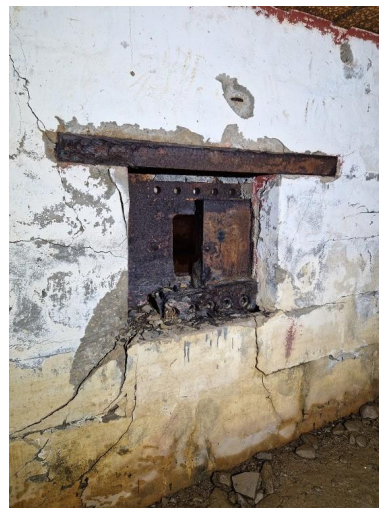
Vue intérieure : créneau blindé de la salle de garde ouest Phot. Guillaume Lécueillier IVR53_20242911269NUCA
