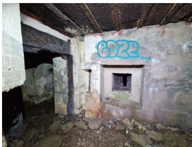
Vue intérieure : accès nord (entrée ouest) défendue par un créneau blindé Phot. Guillaume Lécueillier IVR53_20242911281NUCA
