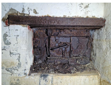
Vue intérieure : salle de garde ouest, créneau blindé défendant l'accès sud Phot. Guillaume Lécueillier IVR53_20242911261NUCA
