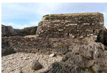
Vue générale depuis l'est. La maçonnerie de moellon masque le bunker - abri Phot. Guillaume Lécueillier IVR53_20242911234NUCA
