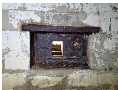
Vue intérieure : créneau blindé de la salle de garde est défendant l'entrée Phot. Guillaume Lécueillier IVR53_20242911273NUCA
