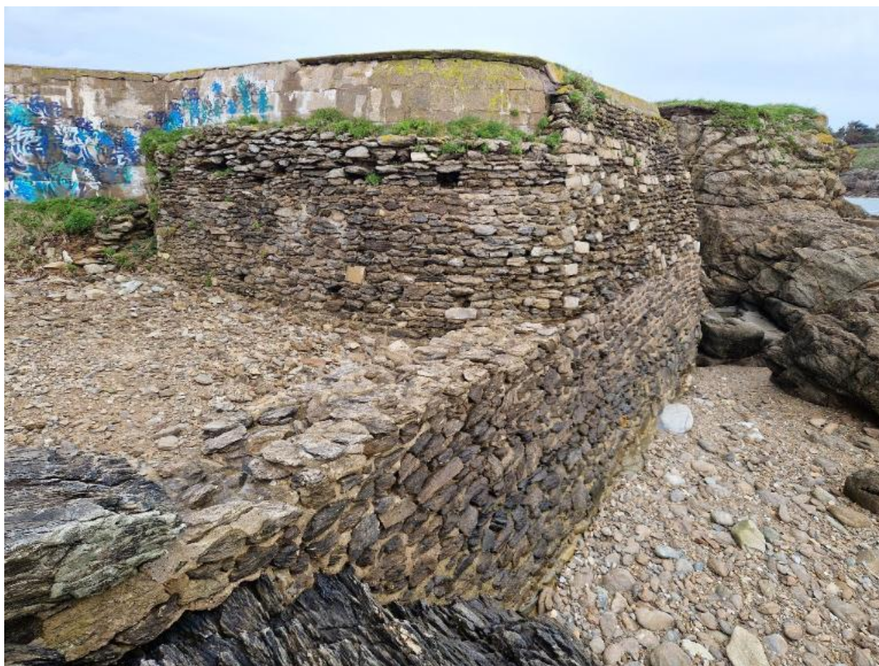
Vue depuis le sud-sud-est. La maçonnerie de moellon masque le bunker - abri
