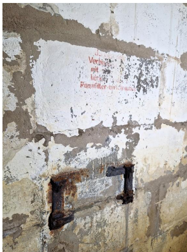
Vue intérieure : salle de garde est, emplacement du ventilateur et marquage en allemand Phot. Guillaume Lécueillier IVR53_20242911267NUCA
