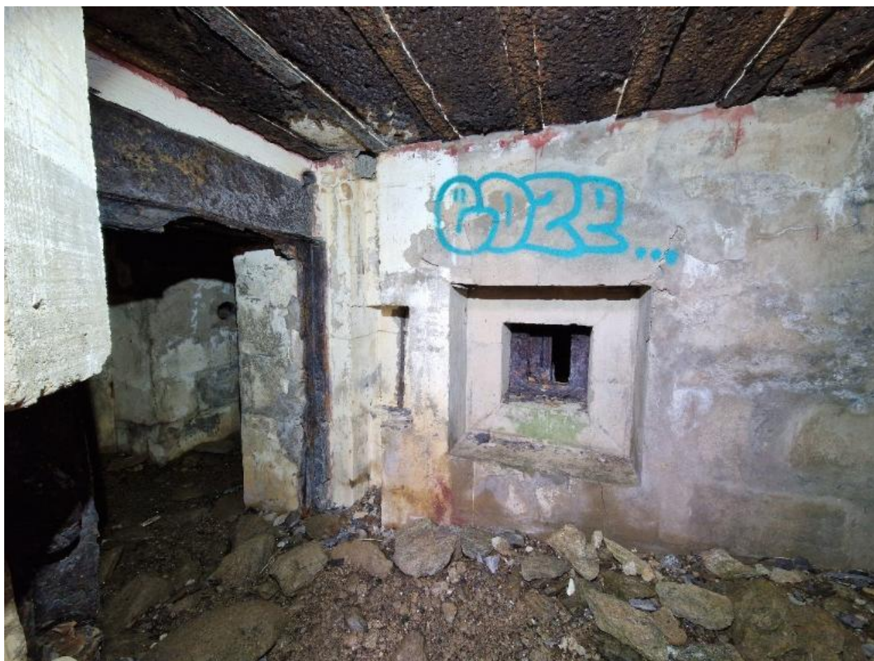
Vue intérieure : accès nord (entrée ouest) défendue par un créneau blindé
