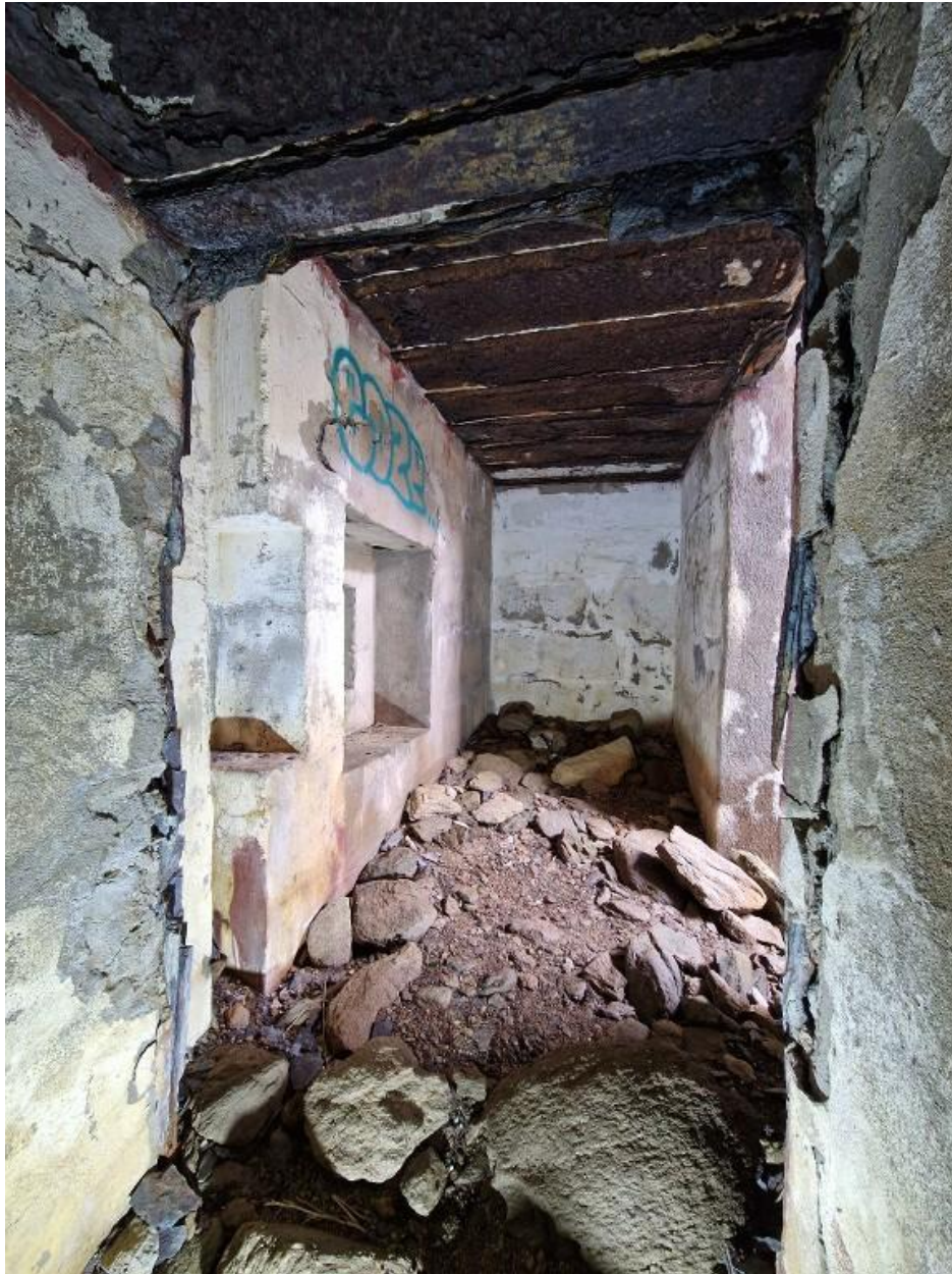
Vue intérieure : accès nord (entrée ouest), couloir d'accès au sas
