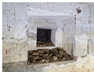
Vue intérieure : créneau blindé défendant l'accès sud Phot. Guillaume Lécueillier IVR53_20242911256NUCA
