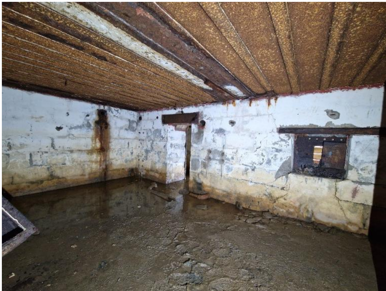
Vue intérieure : salle de garde ouest. Au fond, la salle du périscopes ; à droite, le créneau blindé défendant l'entrée
