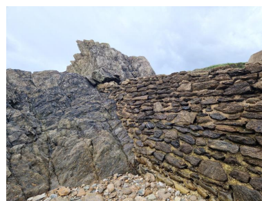
Vue de détail de la maçonnerie de moellon Phot. Guillaume Lécueillier IVR53_20242911241NUCA
