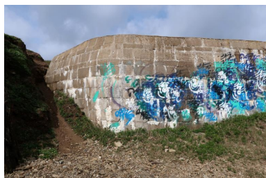
Vue depuis le sud-est. Le bunker est construit avec des parpaings dans lesquels a été coulé le béton. Il est tagué Phot. Guillaume Lécueillier IVR53_20242911227NUCA
