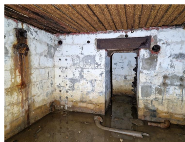
Vue intérieure : salle de garde ouest, accès à la petite salle du périscope. Au sol, des vestiges des tuyaux du système de ventilation ou de chauffage Phot. Guillaume Lécueillier IVR53_20242911262NUCA
