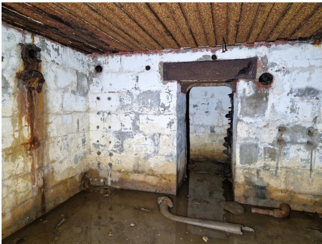
Vue intérieure : salle de garde ouest, accès à la petite salle du périscopes. Au sol, des vestiges des tuyaux du système de ventilation ou de chauffage
