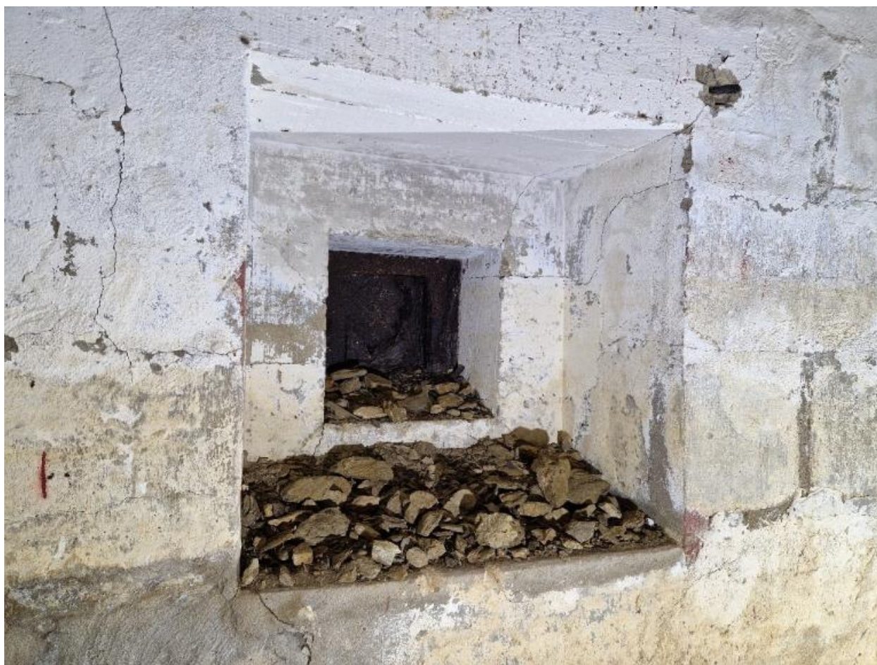
Vue intérieure : créneau blindé défendant l'accès sud
