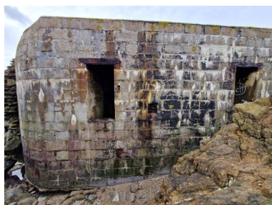
Vue de l'élévation nord. De ce côté, l'érosion marine a emporté le substrat de l'îlot : les deux entrées - est et ouest - sont dans le vide Phot. Guillaume Lécueillier IVR53_20242911245NUCA
