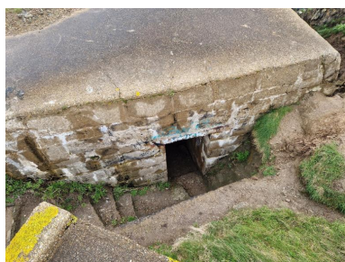
Vue de l'accès sud (percé dans l'élévation ouest) Phot. Guillaume Lécueillier IVR53_20242911254NUCA
