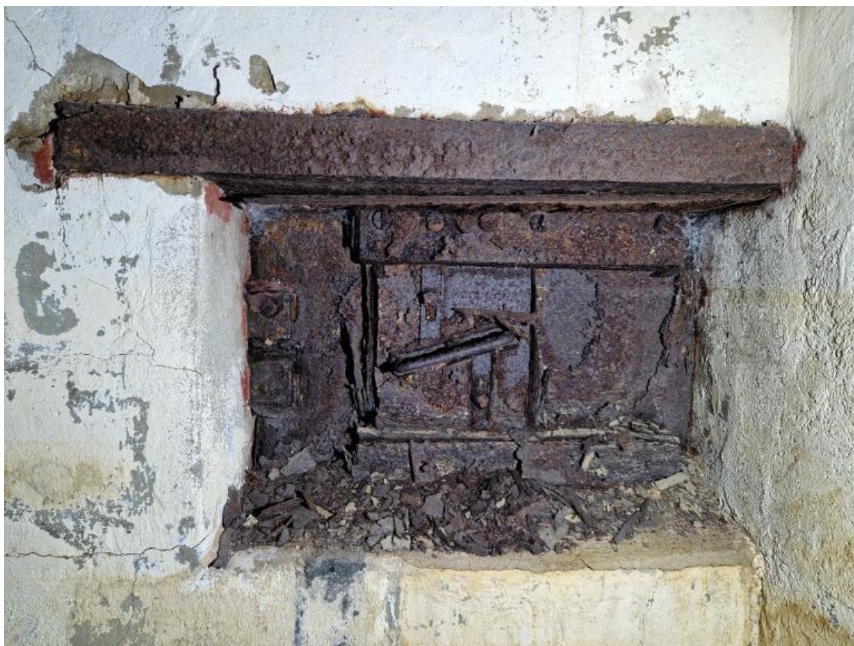
Vue intérieure : salle de garde ouest, créneau blindé défendant l'accès sud
