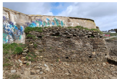
Vue depuis le sud. La maçonnerie de moellon masque le bunker - abri Phot. Guillaume Lécueillier IVR53_20242911229NUCA
