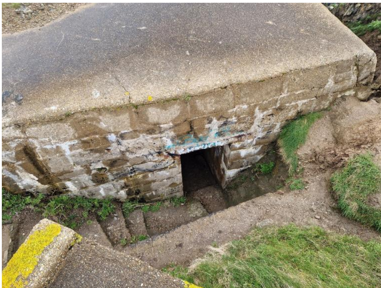
Vue de l'accès sud (percé dans l'élévation ouest)
