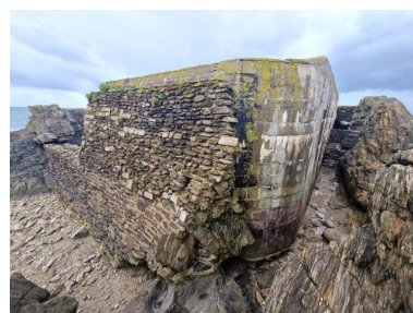
Vue de l'angle nord-est. De ce côté de l'îlot, l'érosion marine a emporté le substrat. Le bunker est construit avec des parpaings dans lesquels a été coulé le béton ; il est recouvert d'une maçonnerie de moellon Phot. Guillaume Lécueillier IVR53_20242911235NUCA
