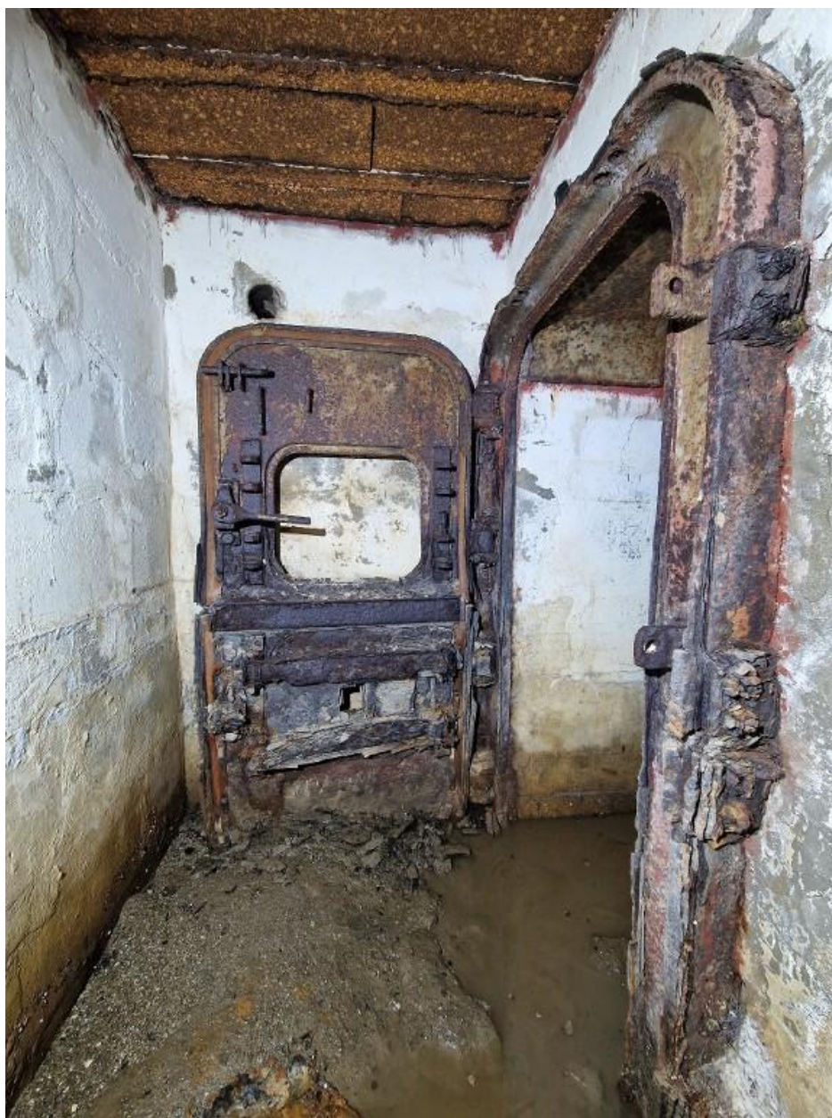
Vue intérieure : petite salle du périscopes, porte blindée à deux vantaux
