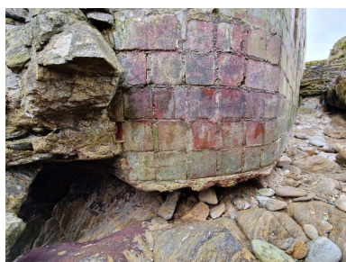
Vue de détail de l'angle nord-est. De ce côté de l'îlot, l'érosion marine a emporté le substrat. Le bunker est construit avec des parpaings dans lesquels a été coulé le béton Phot. Guillaume Lécueillier IVR53_20242911239NUCA
