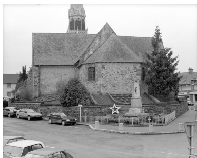
Vue partielle est Phot. Bernard Bègne, Phot. M. Loyon IVR53_19943500015X
