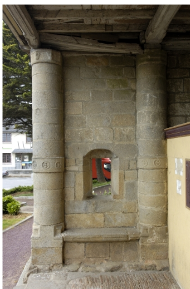
Porche sud ; mur ouest Phot. Bernard Bègne IVR53_20043500912NUCA
