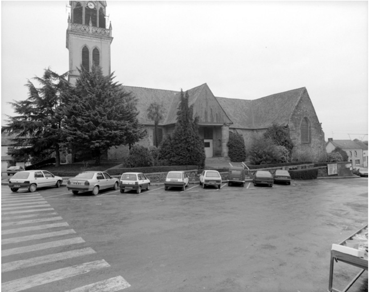
Vue partielle sud
