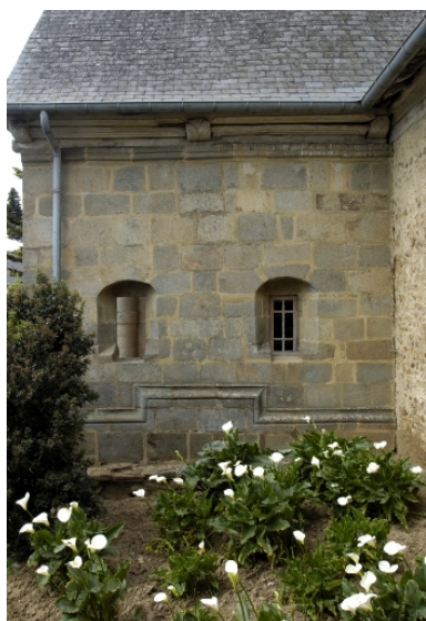
Porche sud ; mur est Phot. Bernard Bègne IVR53_20043500911NUCA
