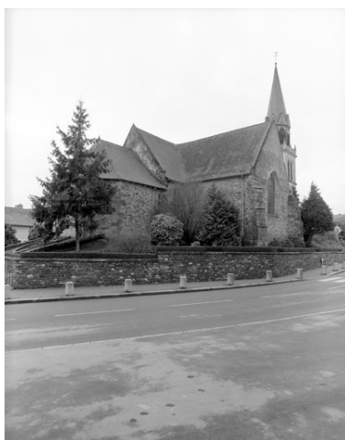
Vue générale nord est Phot. Bernard Bègne, Phot. M. Loyon IVR53_19943500014X
