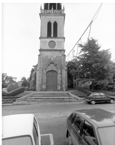
Vue partielle ouest Phot. Bernard Bègne, Phot. M. Loyon IVR53_19943500018X
