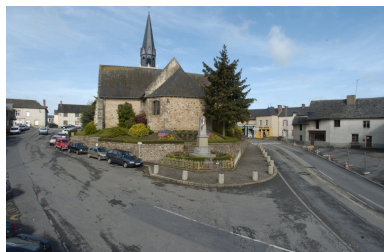
Vue générale est Phot. Norbert Lambart IVR53_20043500789NUCA
