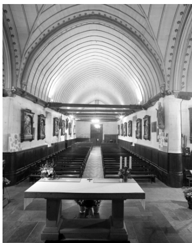
Vue intérieure : vue générale de la nef Phot. Bernard Bègne, Phot. M. Loyon IVR53_19943500019X
