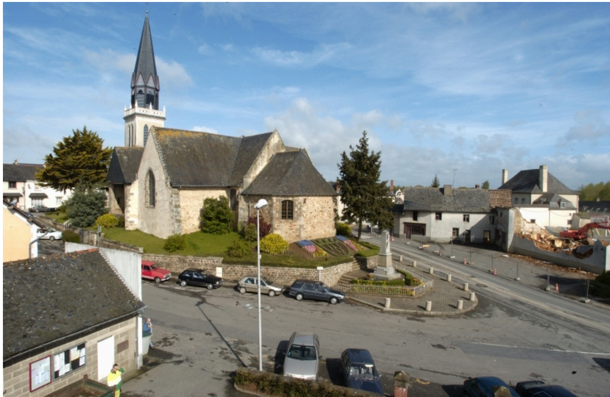
Vue de situation sud est
