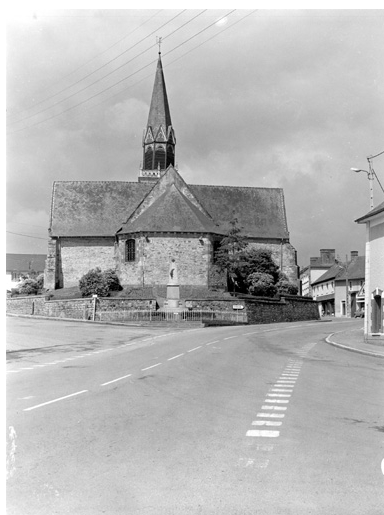
Vue générale est Phot. Guy Artur, Phot. Norbert Lambart IVR53_19863500718X
