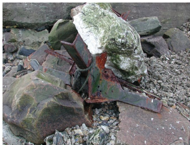
Vue d'un hérisson tchèque, obstacle anti-char statique en acier (état en 2002). Il est réutilisé pour la défense contre la mer des installations ostréicoles Phot. Guillaume Lécueillier IVR53_20022901683NUCA
