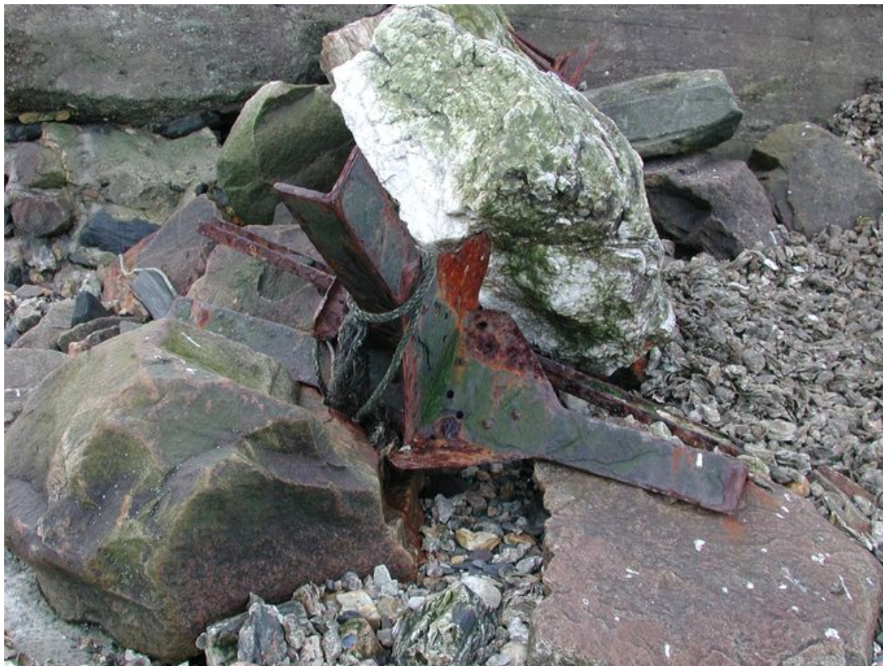
Vue d'un hérisson tchèque, obstacle anti-char statique en acier (état en 2002). Il est réutilisé pour la défense contre la mer des installations ostréicoles
