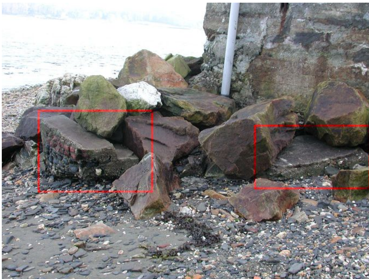
Vue des vestiges disloqués sur l'estran de l'une des quatre cuves pour canon antiaérien de 4 cm : escalier d'accès et dalle de couverture (état en 2002). Ces éléments sont réutilisés pour la défense contre la mer des installations ostréicoles
