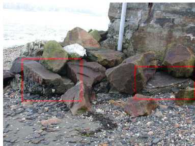
Vue des vestiges disloqués sur l'estran de l'une des quatre cuves pour canon antiaérien de 4 cm : escalier d'accès et dalle de couverture (état en 2002). Ces éléments sont réutilisés pour la défense contre la mer des installations ostréicoles Phot. Guillaume Lécueillier IVR53_20022901682NUCA
