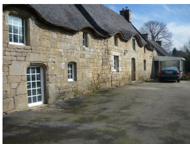
vue générale Phot. Jean-Pierre Martin IVR53_20185605636NUCA
