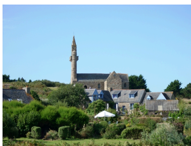
Carantec, chapelle Notre-Dame : vue de situation depuis le sud-ouest Phot. Gwénaél Fauchille IVR53_20082906593NUCA
