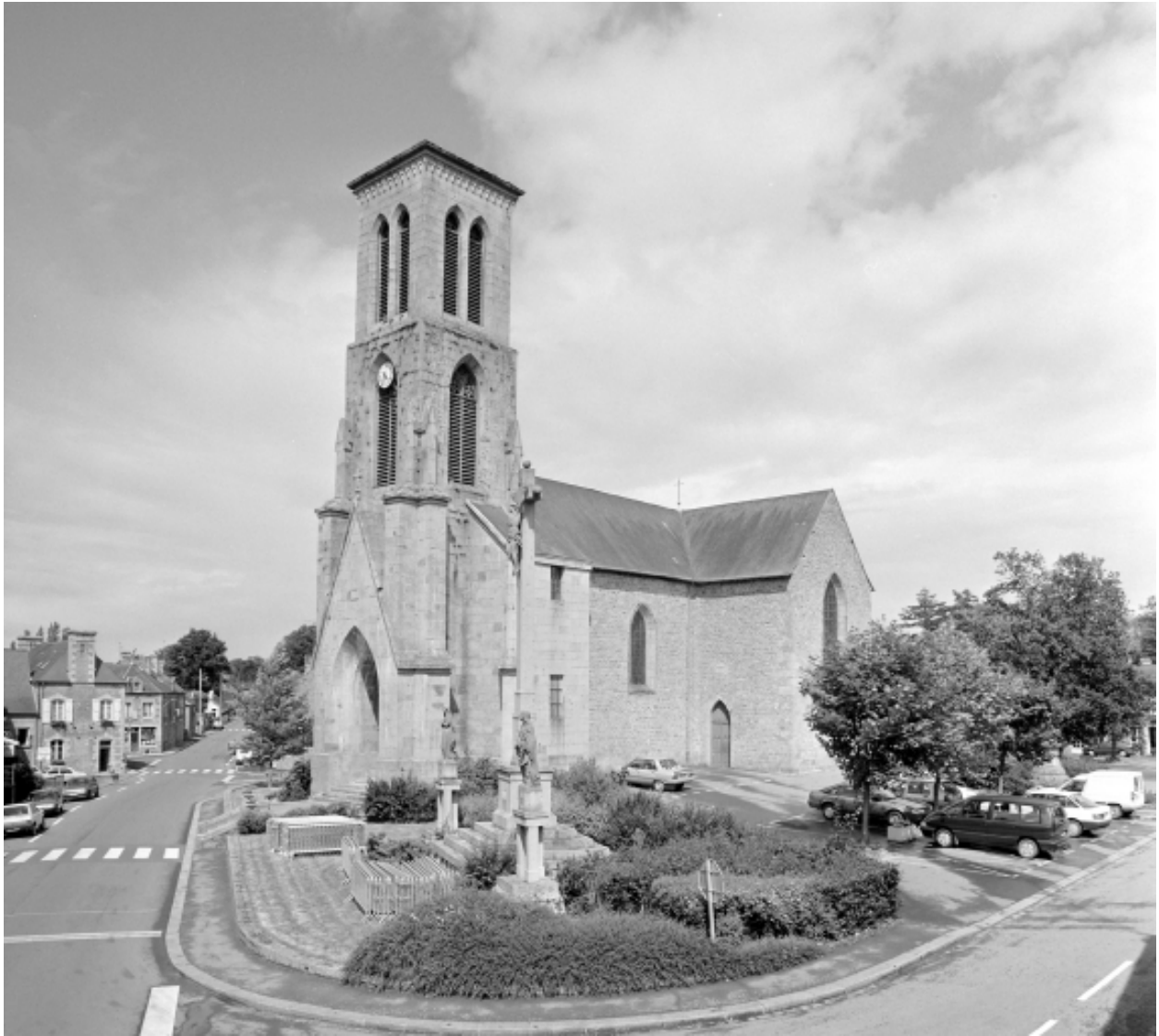
Elévation Sud-Ouest : vue générale
