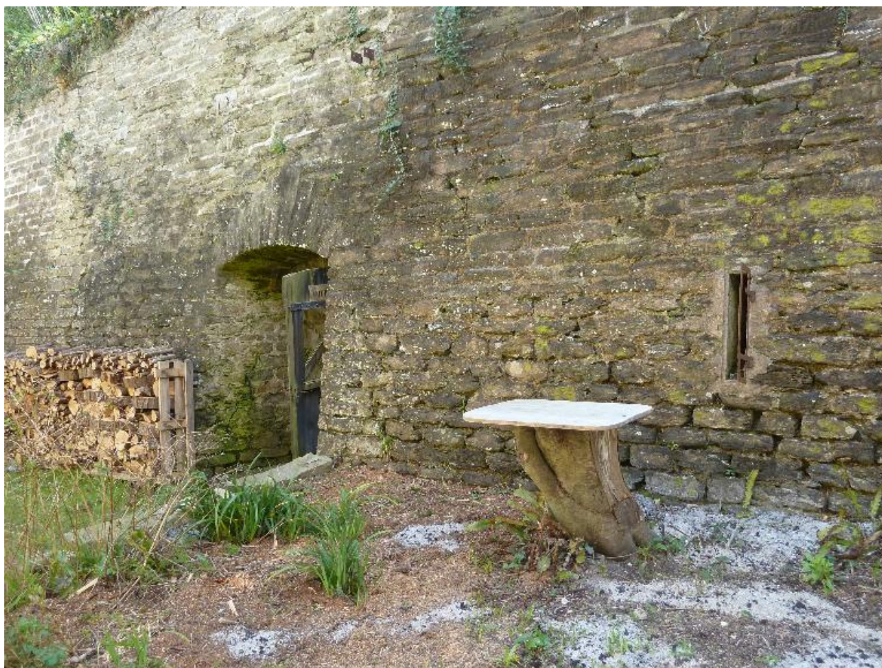
Le Palais, enceinte urbaine, magasin à poudre du bastion 19, extérieur.
