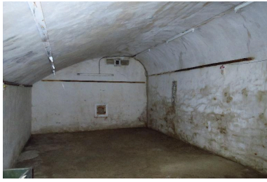
Le Palais, enceinte urbaine, magasin à poudre du bastion 19, chambre de stockage. Phot. Lionel Duigou IVR53_20175606926NUCA
