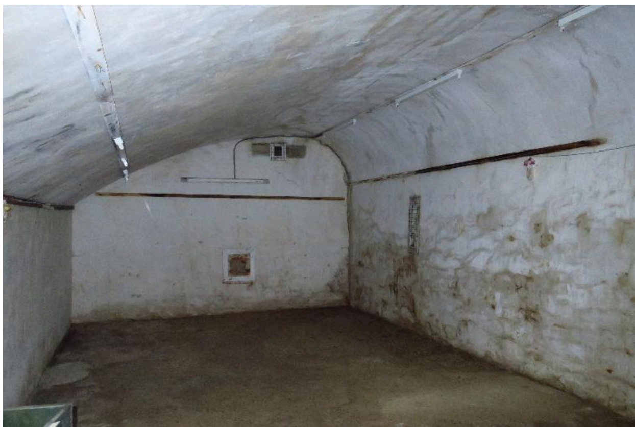
Le Palais, enceinte urbaine, magasin à poudre du bastion 19, chambre de stockage.
