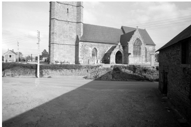
Façade sud, vue générale. Phot. François Dagorn IVR53_19723500702V
