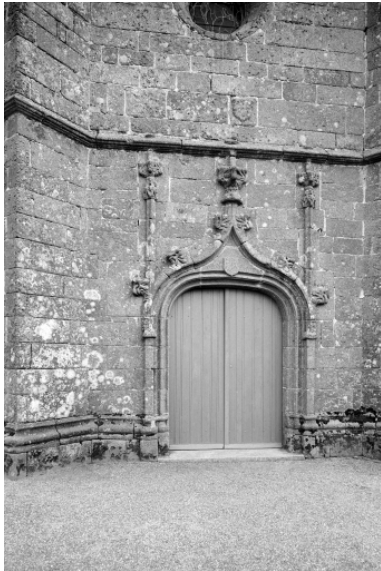
Façade ouest, détail porte. Phot. François Dagorn IVR53_19723500706V
