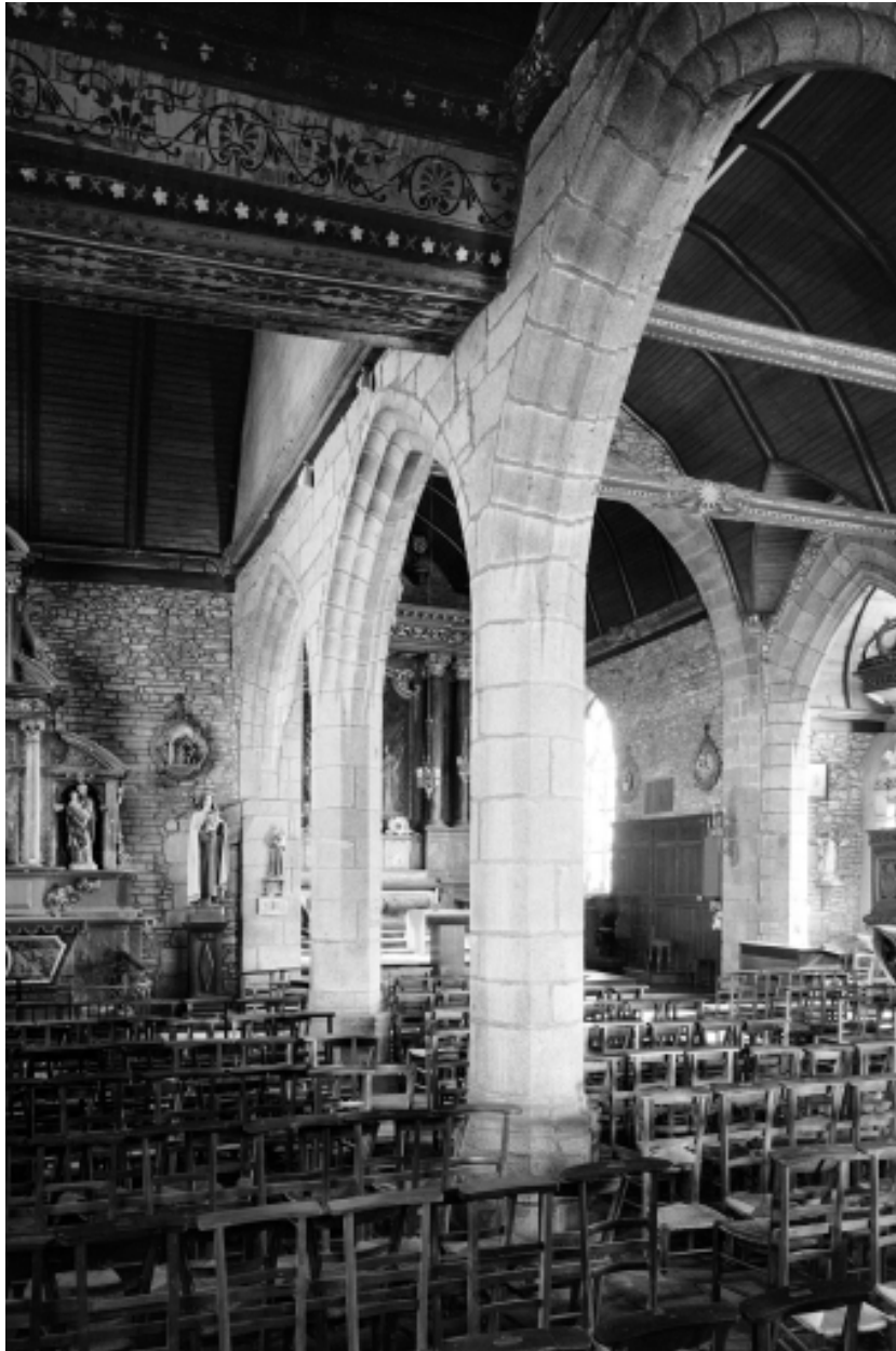
Intérieur, bas-côté nord, vue prise du nord-ouest.
