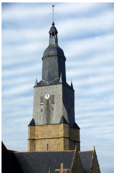
Détail du clocher Phot. Norbert Lambart IVR53_20143501537NUCA
