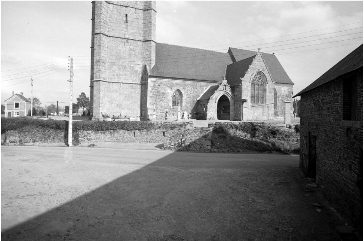
Façade sud, vue générale.
