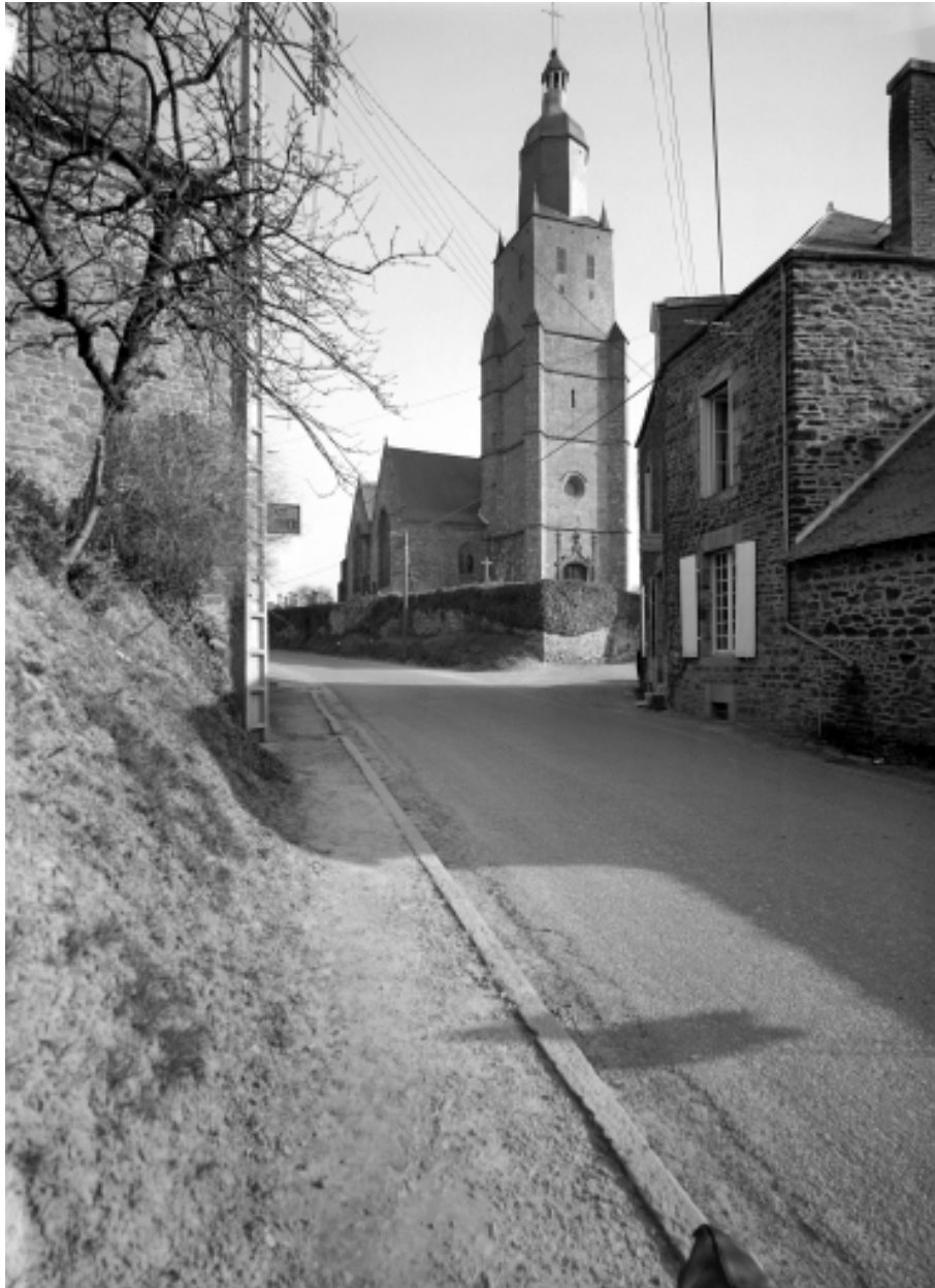
Elévation Nord-Ouest : vue générale
