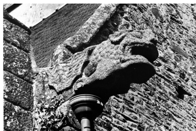
Façade nord, détail gargouille. Phot. Huart IVR53_19693500209V
