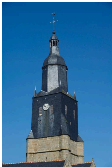
Détail du clocher Phot. Norbert Lambart IVR53_20143501597NUCA
