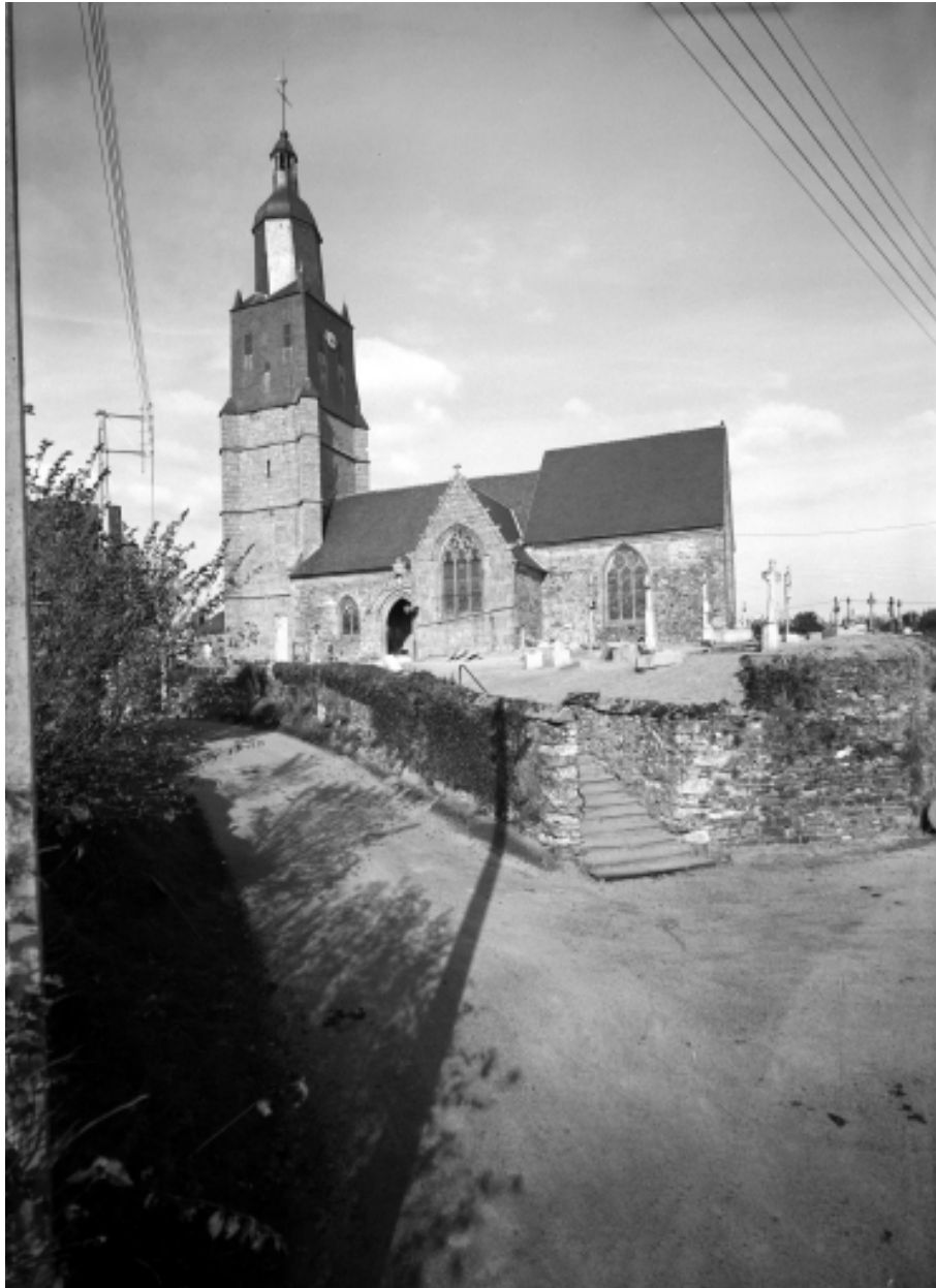
Elévation sud : vue générale
