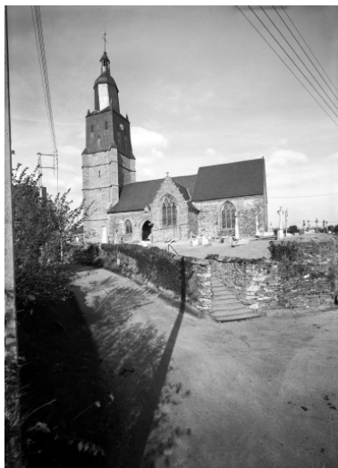
Elévation sud : vue générale Phot. François Dagorn IVR53_19723500701V
