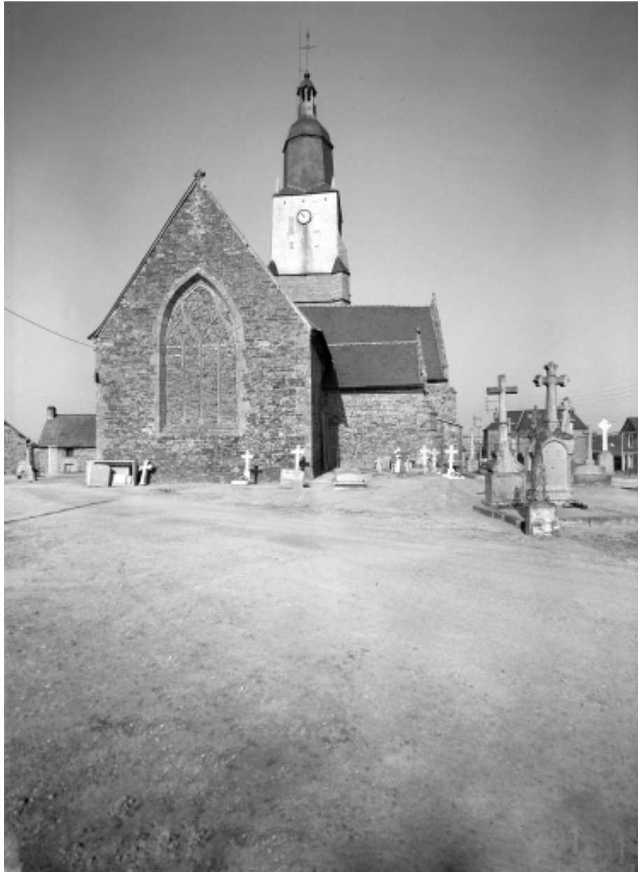
Elévation est : vue générale
