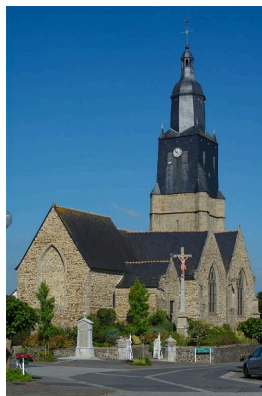
Vue générale nord-est Phot. Norbert Lambart IVR53_20143501598NUCA
