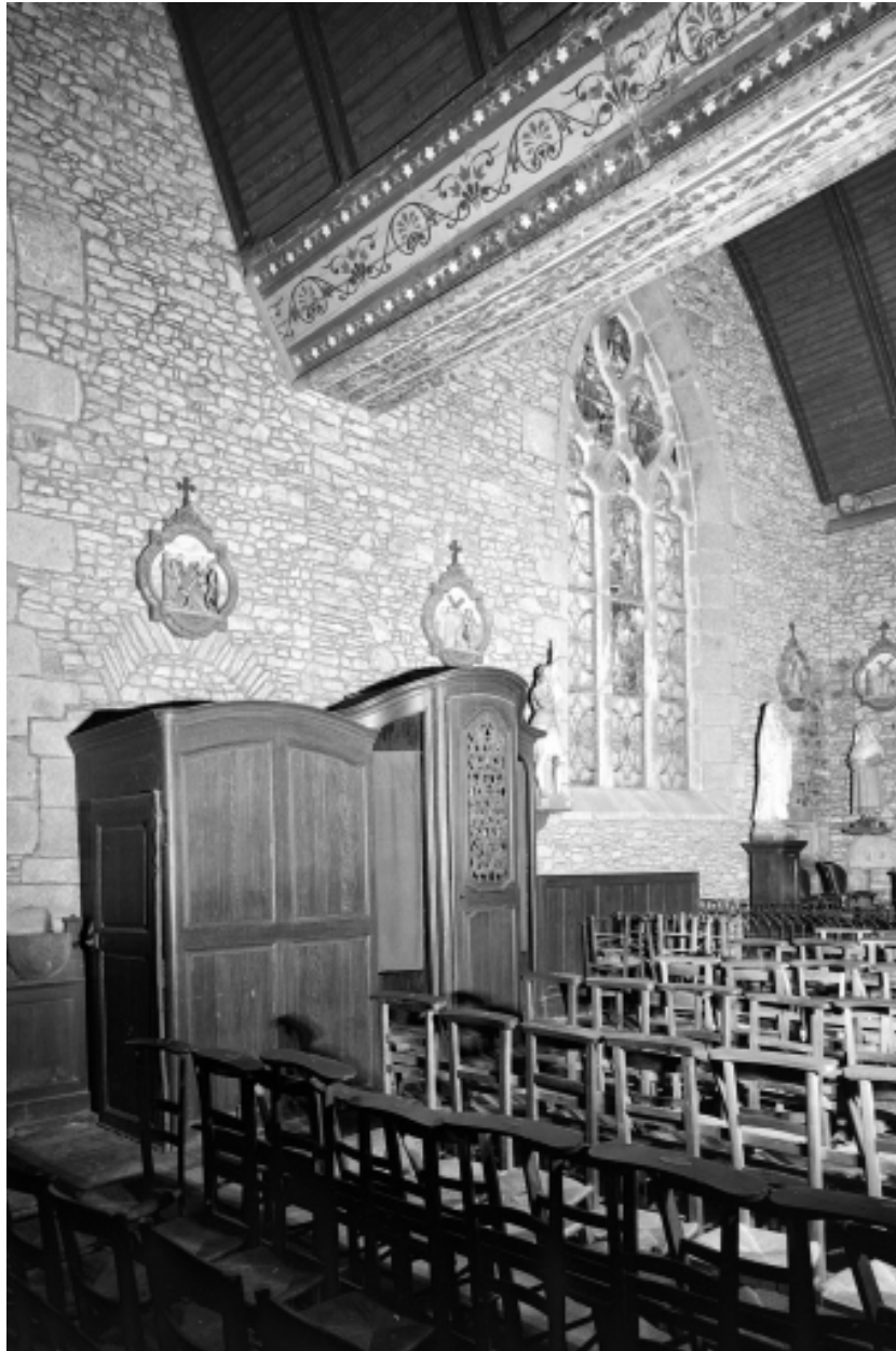
Intérieur, bas-côté nord, vue prise du sud-ouest.
