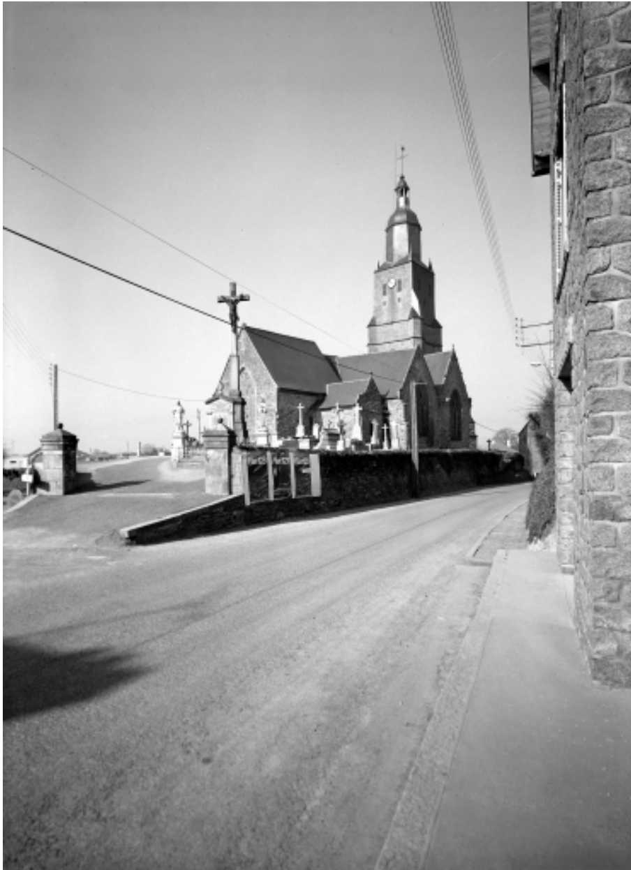
Elévation nord-est : vue générale
