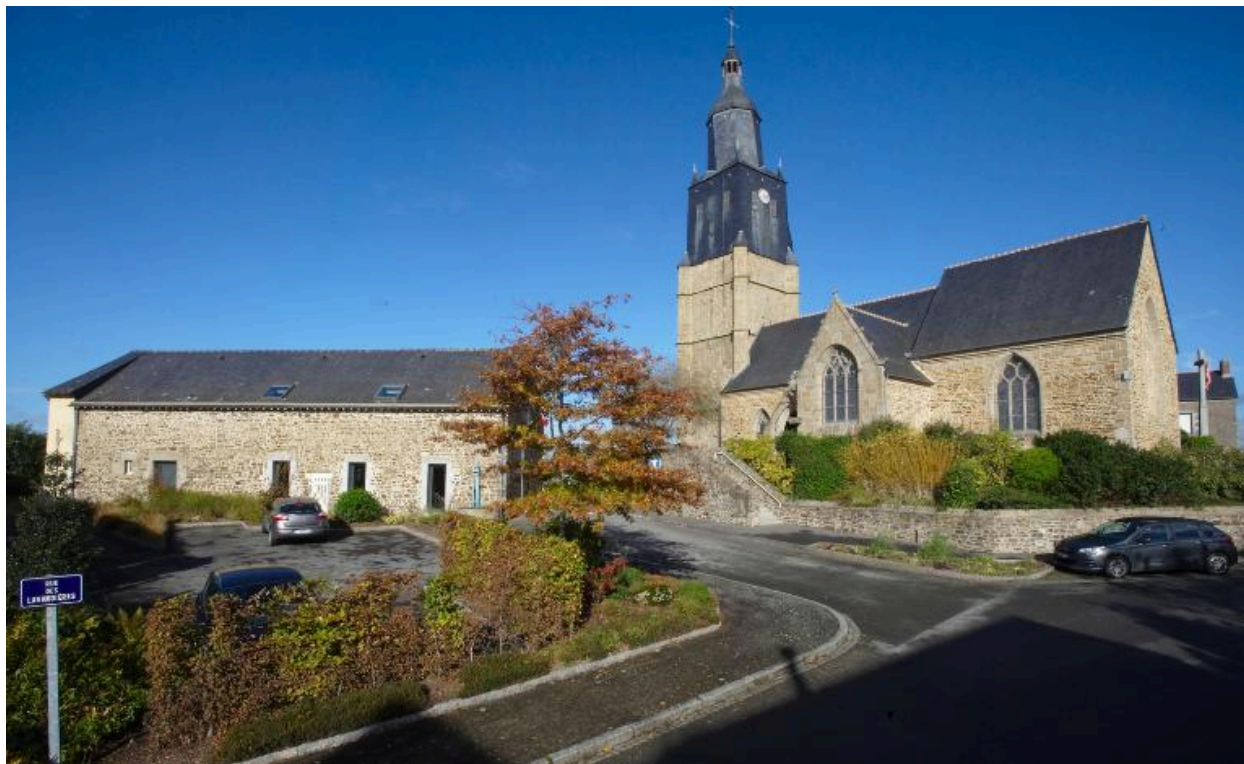
Vue générale sud-est
