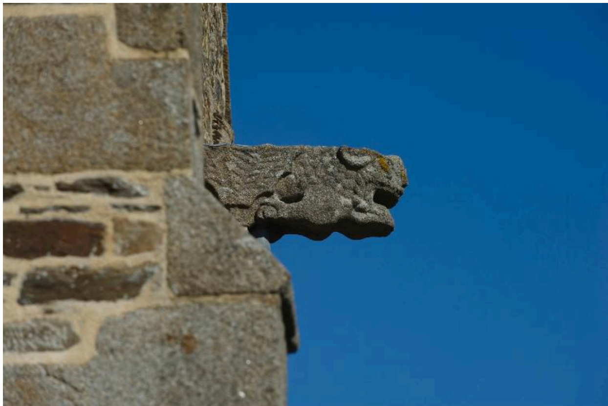
Gargouille de la façade nord
