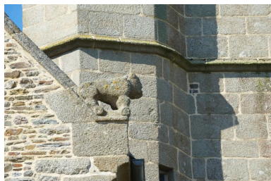
Détail d'une gargouille Phot. Norbert Lambart IVR53_20143501601NUCA
