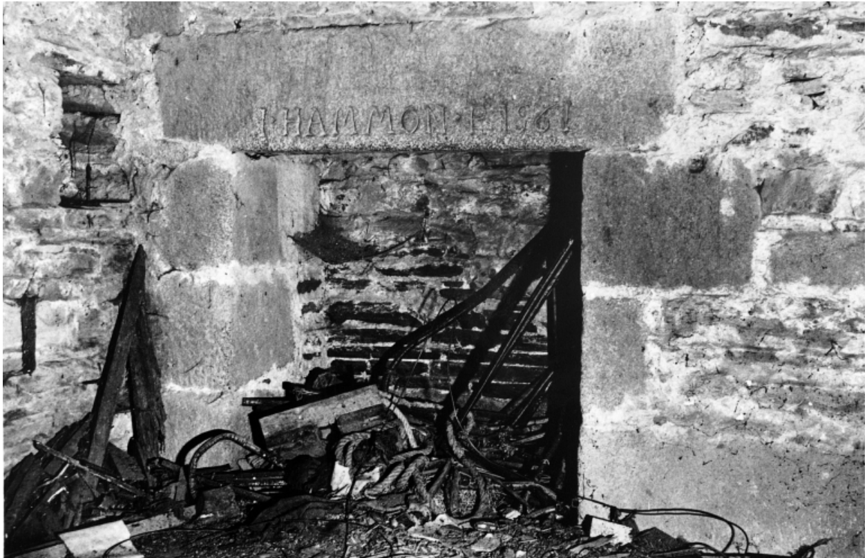
Cheminée du sommet de la tour, inscription n°6.
