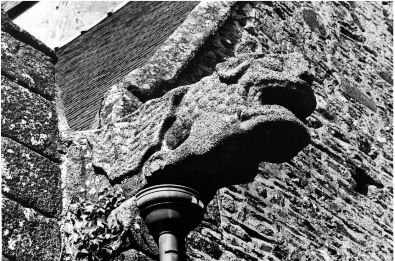
Façade nord, détail gargouille.
