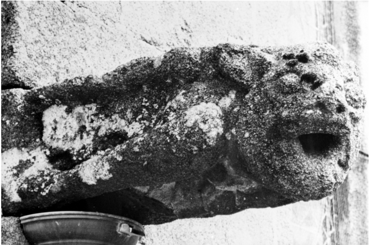
Façade sud, détail gargouille.
