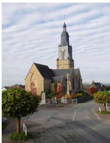
Vue générale nord-est Phot. Norbert Lambart IVR53_20143501531NUCA
