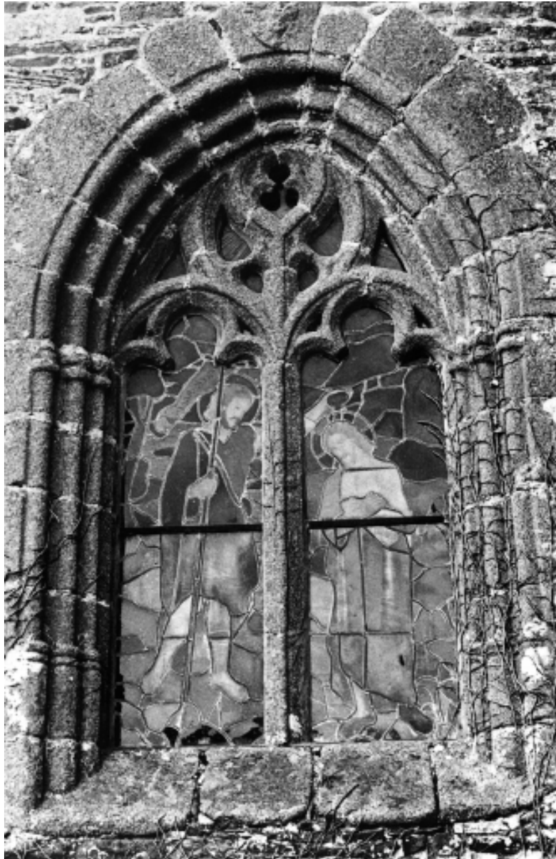
Façade ouest, bas-côté nord, détail fenêtre du mur ouest.
