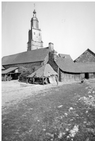
Vue de situation sud-ouest. Phot. François Dagorn IVR53_19733500261V
