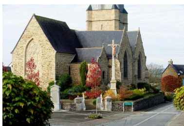
Vue nord-est Phot. Norbert Lambart IVR53_20143501536NUCA
