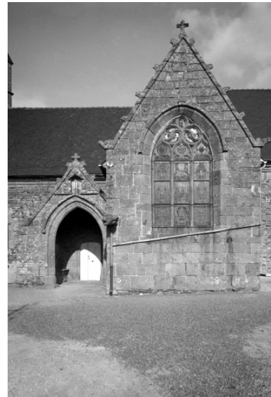
Façade sud, porche, chapelle. Phot. François Dagorn IVR53_19723500703V
