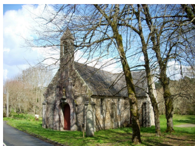
Moëlan-sur-Mer, chapelle de Lanriot : vue générale sud-ouest Phot. Gwénaél Fauchille IVR53_20082905683NUCA
