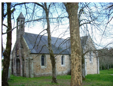
Moëlan-sur-Mer, chapelle de Lanriot : vue générale sud-ouest Phot. Gwénaél Fauchille IVR53_20082905684NUCA
