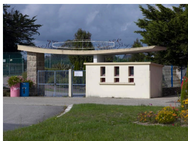
Entrée du stade Phot. Bernard Bègne IVR53_20195600428NUCA
