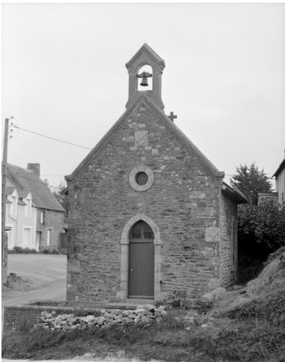
Elévation ouest : vue générale
