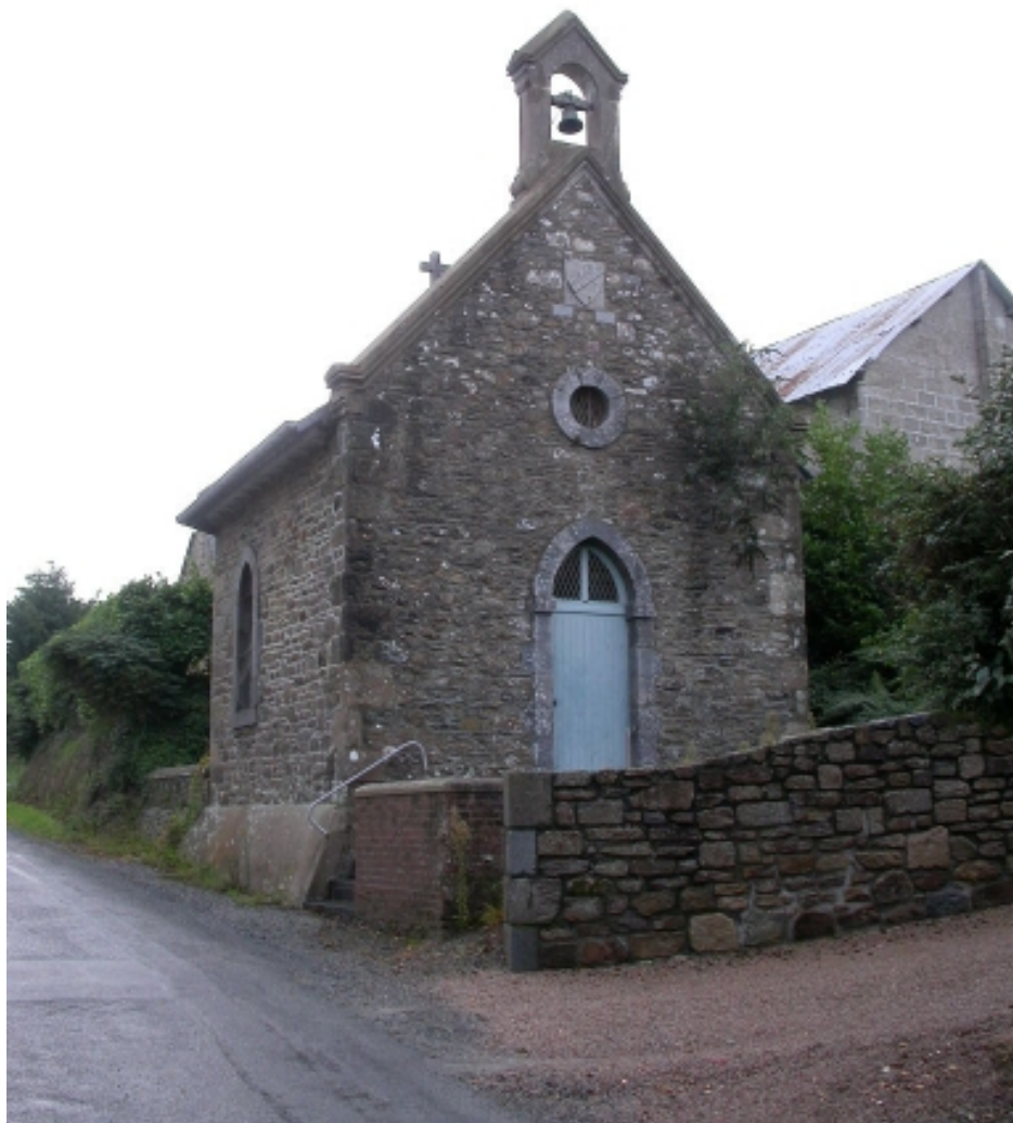
Vue de situation de la chapelle
