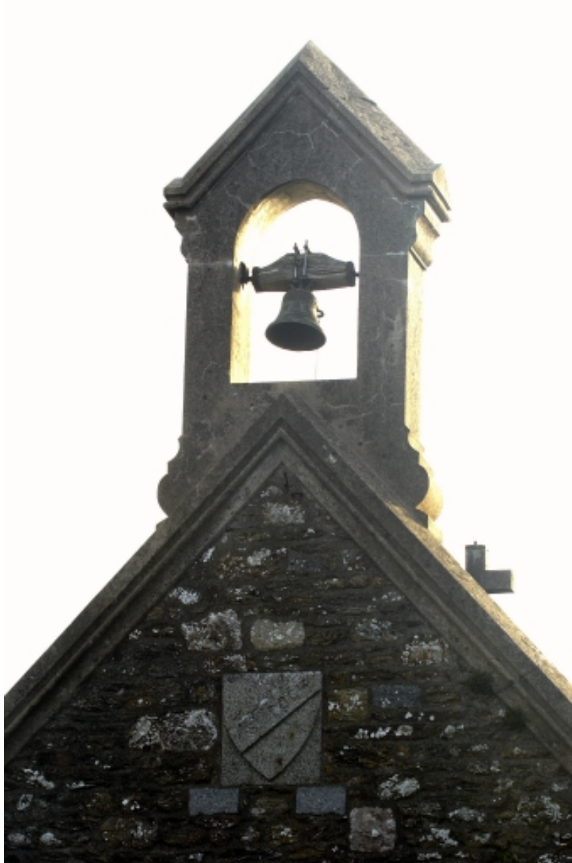
Elévation ouest : détail du clocher
