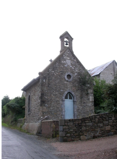
Vue de situation de la chapelle Phot. Sabrina Dalibard IVR53_20063515931NUCA
