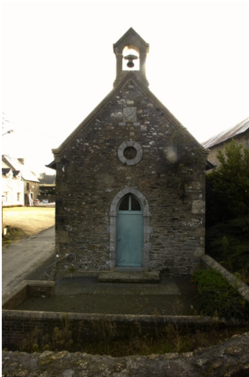
Vue générale de l'élévation ouest
