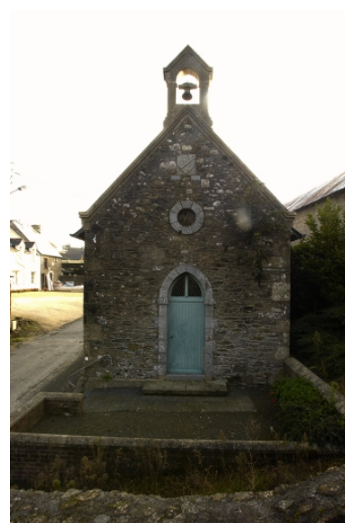
Vue générale de l'élévation ouest Phot. Norbert Lambart
