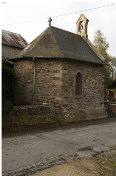
Vue générale des élévations est et nord Phot. Norbert Lambart IVR53_20063502373NUCA
