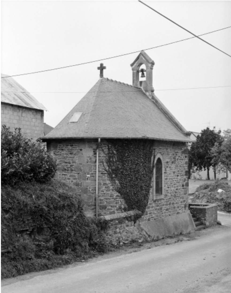
Elévation nord : vue générale
