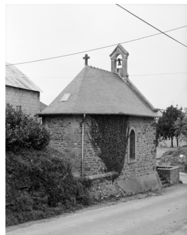
Elévation nord : vue générale Phot. Bernard Bègne, Phot. M. Loyon IVR53_19923500824X
