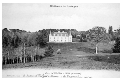
Vue de situation (Archives départementales d'Ille- et-Vilaine, 6 Fi Guer) Phot. Elise Lauranceau IVR53_20045606238NUCB
