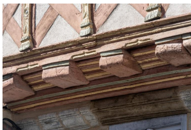
Encorbellement sur solives avec entretoises et sablières moulurées. Des accolades soulignent l'écart entre chaque solive. Phot. Léna Leroy IVR53_20252900547NUCA
