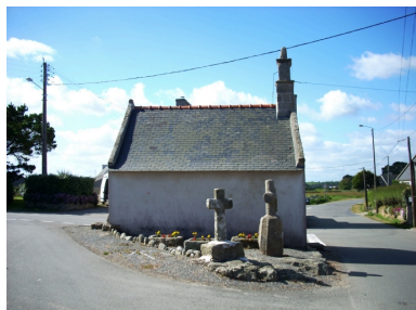
Kerlouan, chapelle Notre-Dame du Croazou : élévation nord Phot. Gwénaél Fauchille IVR53_20082906293NUCA
