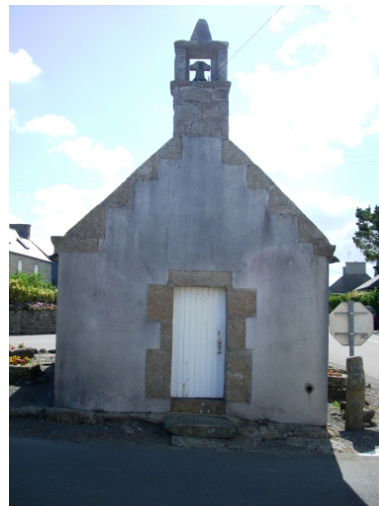
Kerlouan, chapelle Notre-Dame du Croazou : élévation ouest Phot. Gwénaél Fauchille IVR53_20082906292NUCA
