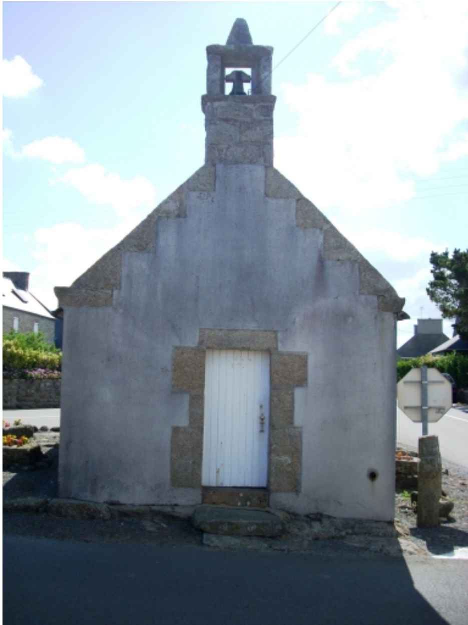
Kerlouan, chapelle Notre-Dame du Croazou : élévation ouest
