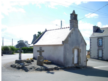
Kerlouan, chapelle Notre-Dame du Croazou : vue générale nord-ouest Phot. Gwénaél Fauchille IVR53_20082906291NUCA
