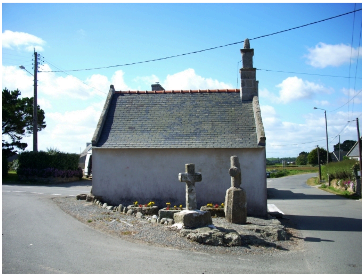
Kerlouan, chapelle Notre-Dame du Croazou : élévation nord
