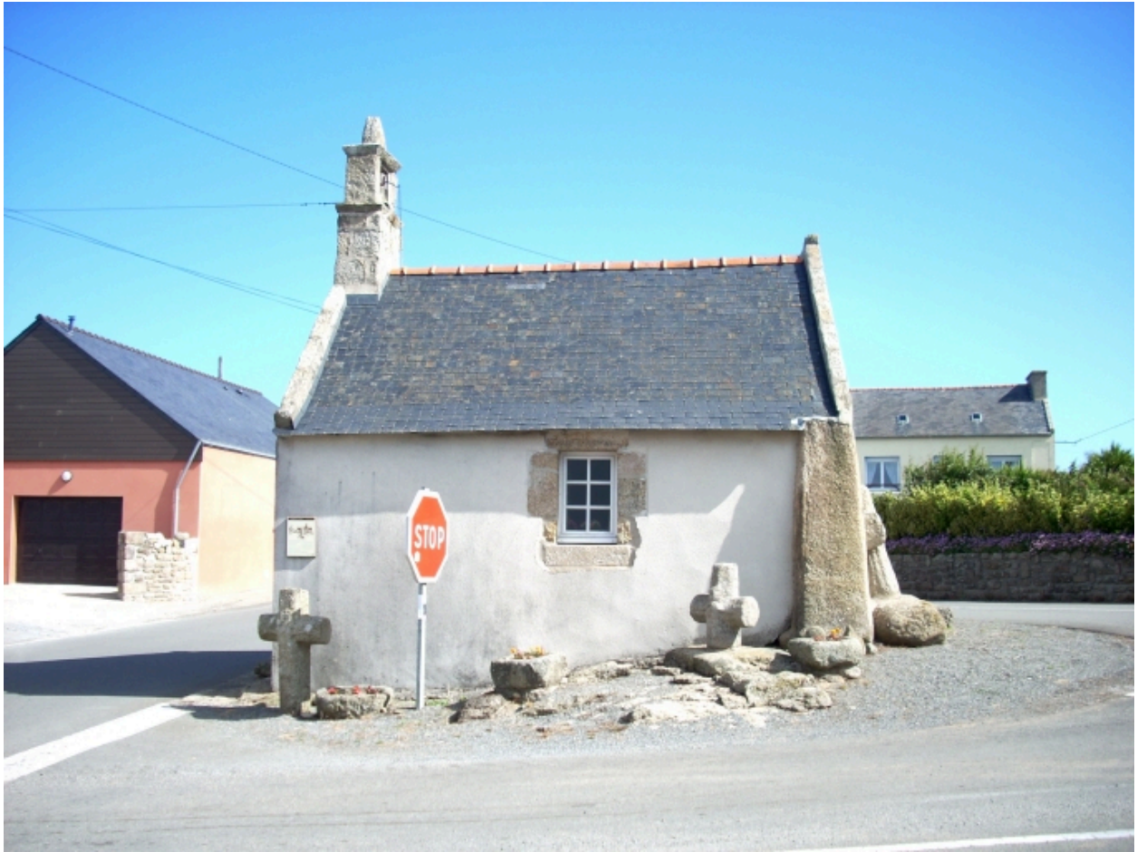
Kerlouan, chapelle Notre-Dame du Croazou : élévation sud
