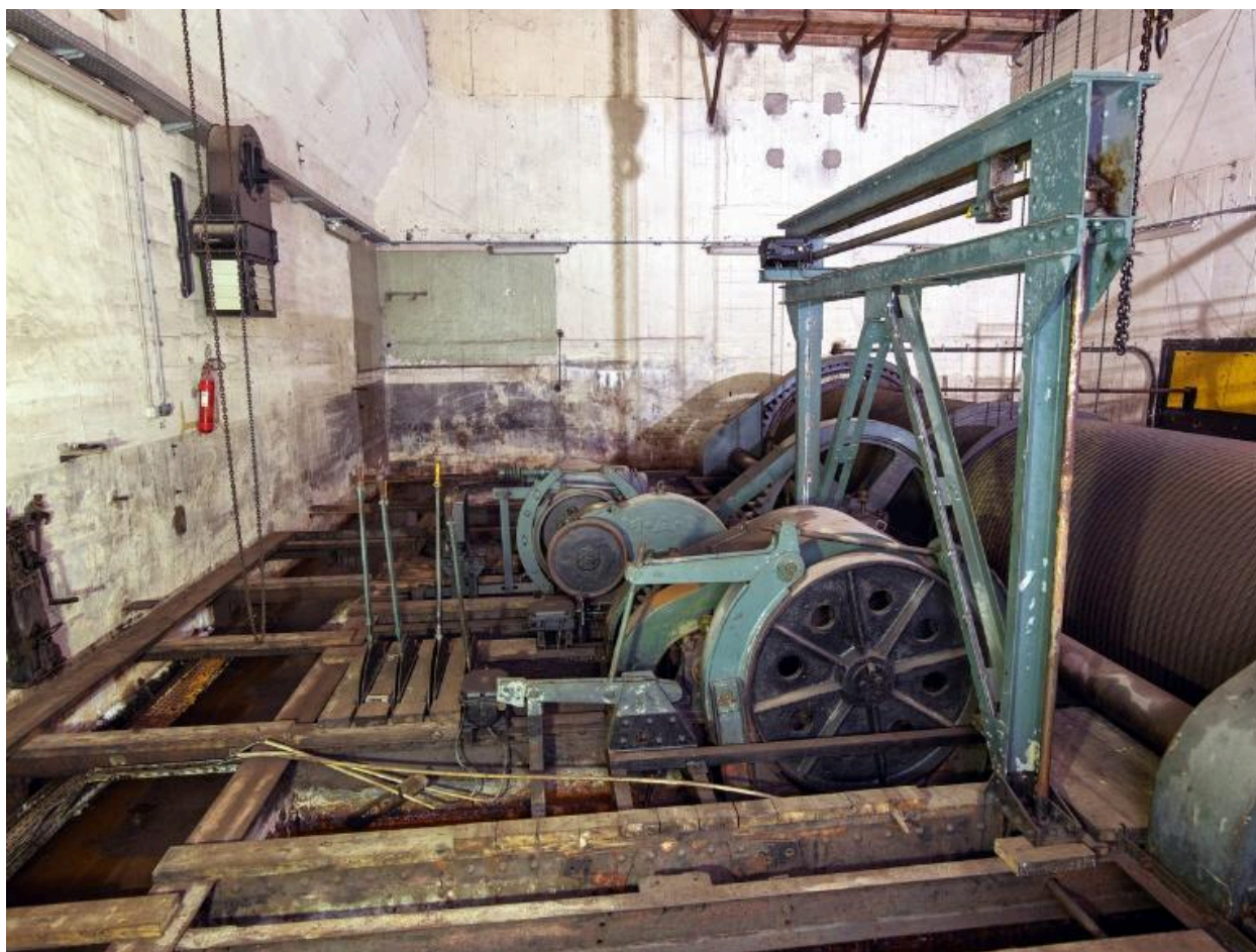
Vue des commandes du treuil et des deux moteurs électriques avec leur frein à tambour. A droite, les deux grands tambours pour les câbles de hissage du charriot du slipway
