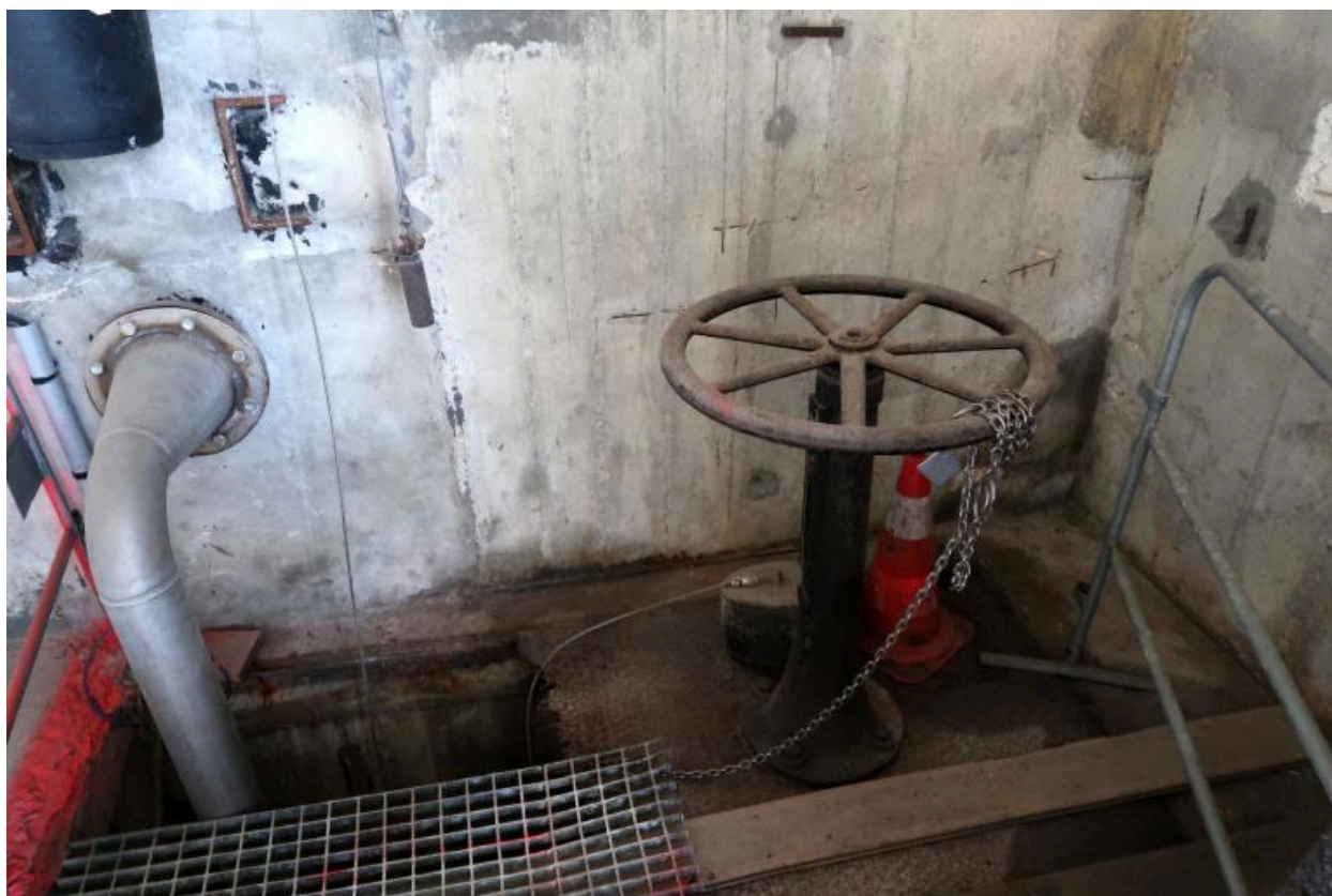
Vue de la vanne située dans l'atelier de la chaudronnerie, magasin puis atelier du Port de La Base de Lorient
