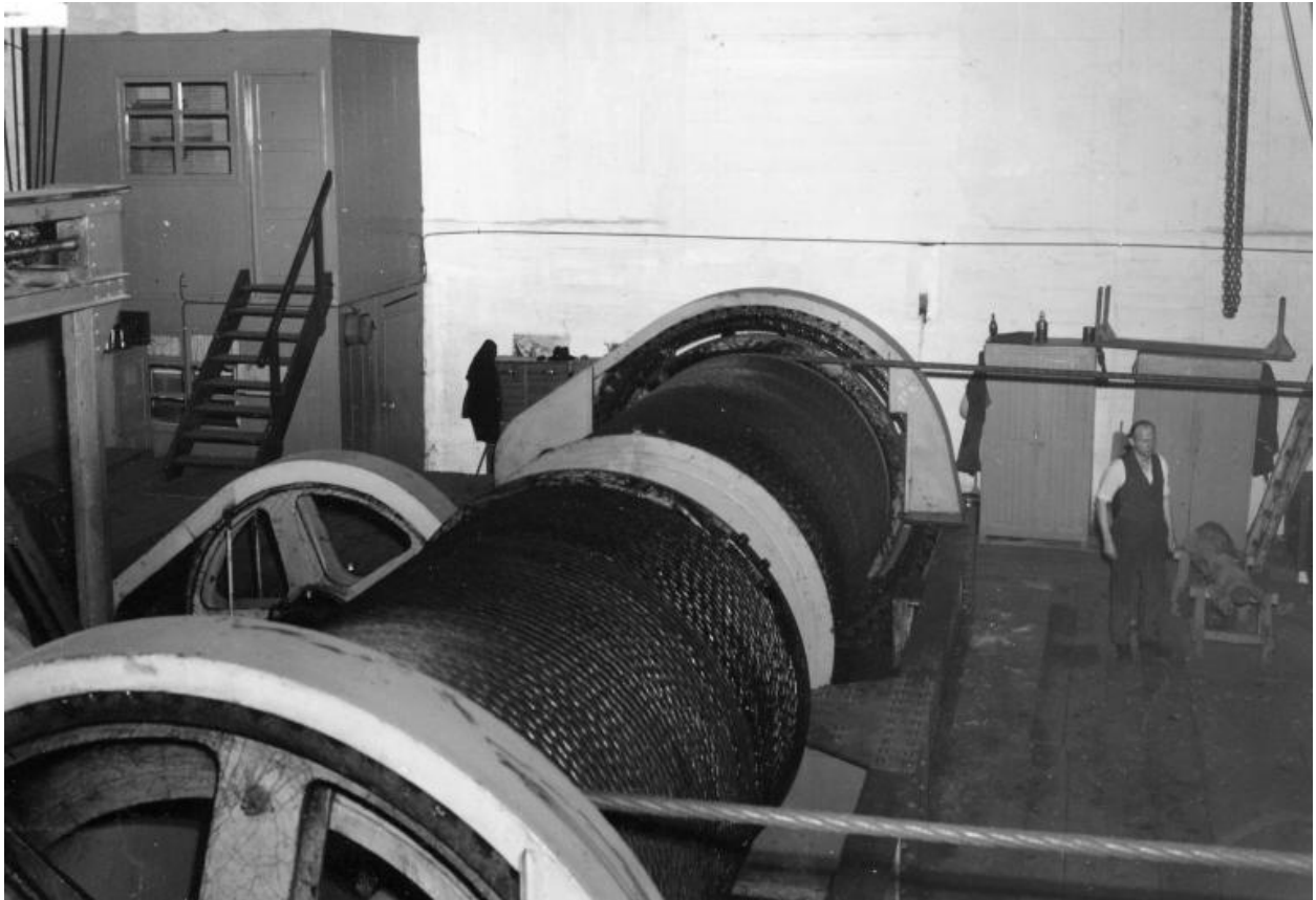
Vue générale de la salle du treuil du bunker Keroman I, photographie non datée (Archives municipales de Lorient)
