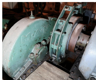
Vue du système d'accouplement et de frein à lame dit à tambour de l'arbre moteur. Sur le carter de protection du pignon et de la roue, on reconnaît l'acronyme M.A.N. de la marque allemande Maschinenfabrik Augsburg-Nürnberg Phot. Guillaume Lécueillier IVR53_20235605347NUCA
