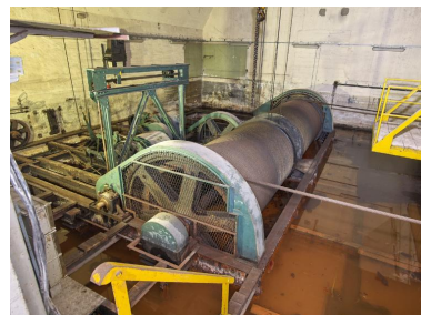
Vue des deux grands tambours pour les câbles de hissage du charriot du slipway. La salle est inondée (état en janvier 2023) Phot. Bernard Bègne IVR53_20235600018NUCA
