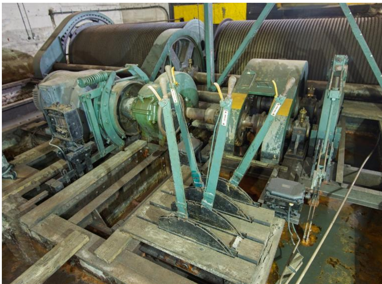
Vue des leviers des commandes mécaniques du treuil. Sur les plaques des leviers, on peut lire : Frein tambour, Embrayage, Frein moteur ; au sol, Petite vitesse (non visible : Grande vitesse)
