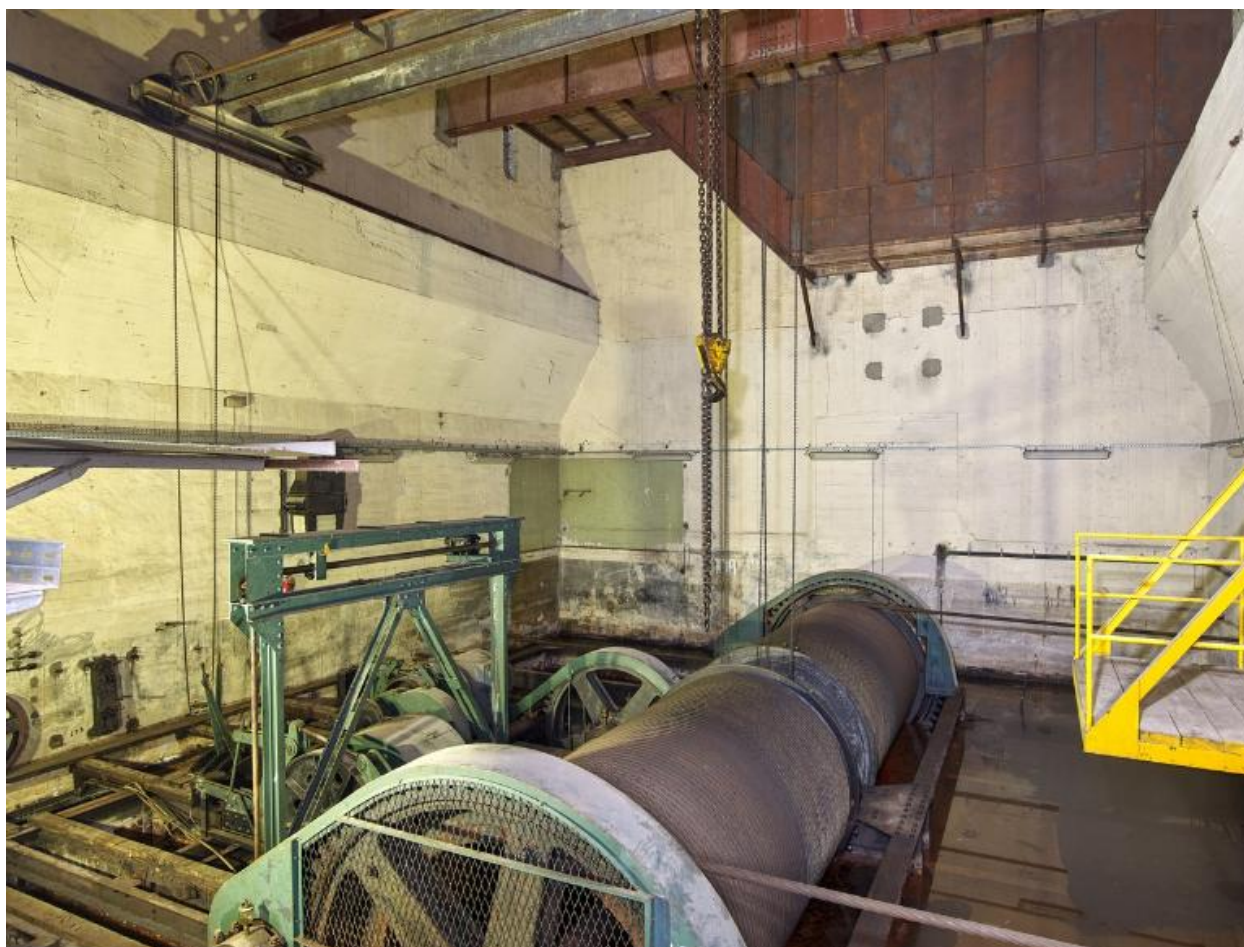
Vue des deux grands tambours pour les câbles de hissage du charriot du slipway. La salle est inondée (état en janvier 2023) mais le plafond demeure en bon état
