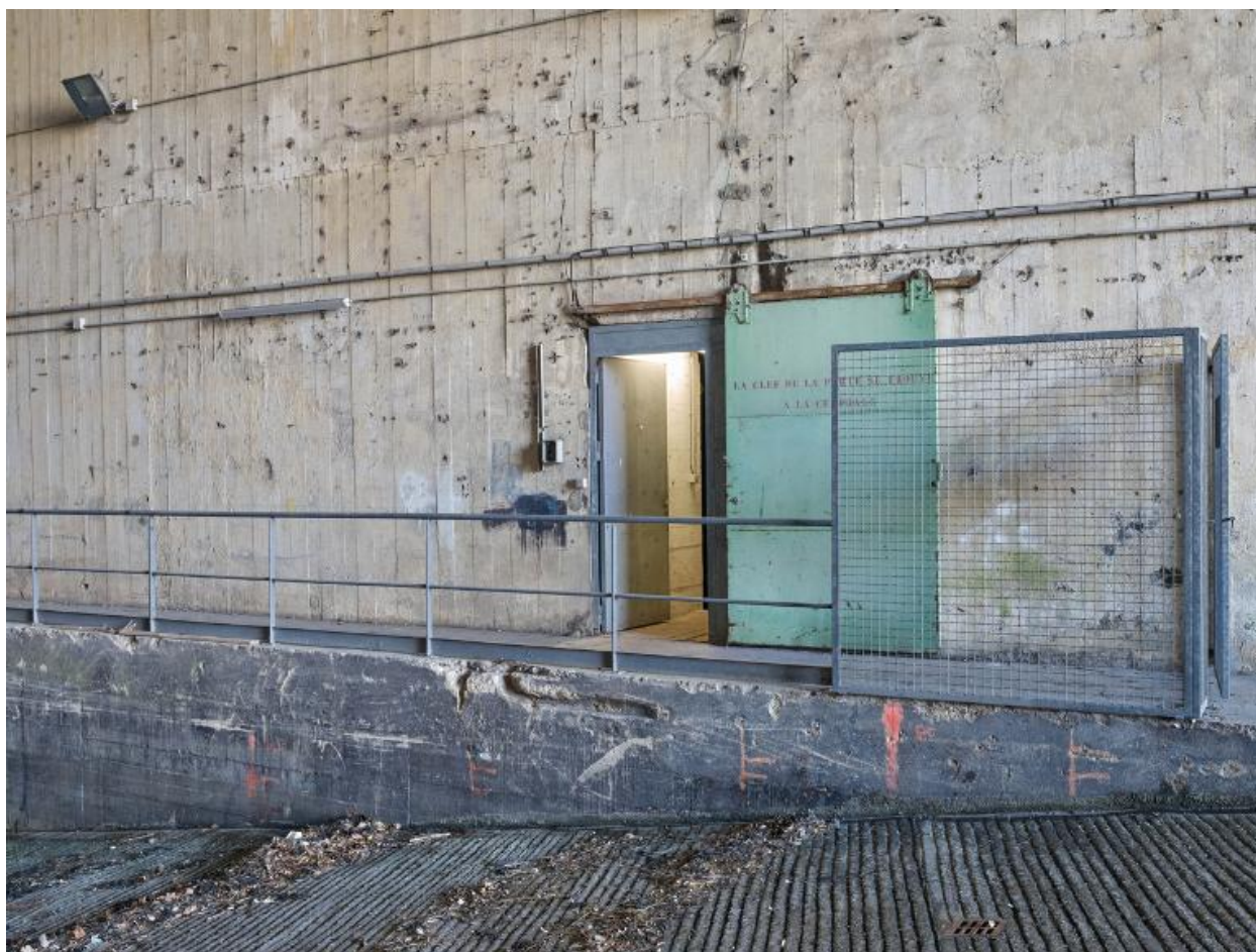
Vue de la porte d'accès depuis l'alvéole du slipway (porte coulissante)
