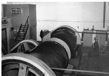
Vue générale de la salle du treuil du bunker Keroman I, photographie non datée (Archives municipales de Lorient) Phot. Anonyme IVR53_20225606367NUCA
