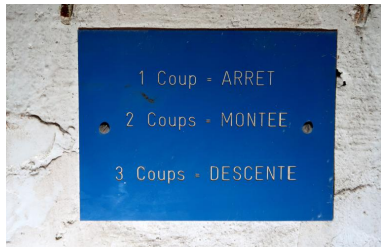
Vue de la signalétique présente entre les deux portes coulissantes d'accès : 1 Coup = ARRET ; 2 Coups = MONTEE ; 3 Coups = DESCENTE Phot. Guillaume Lécueillier IVR53_20235605344NUCA
