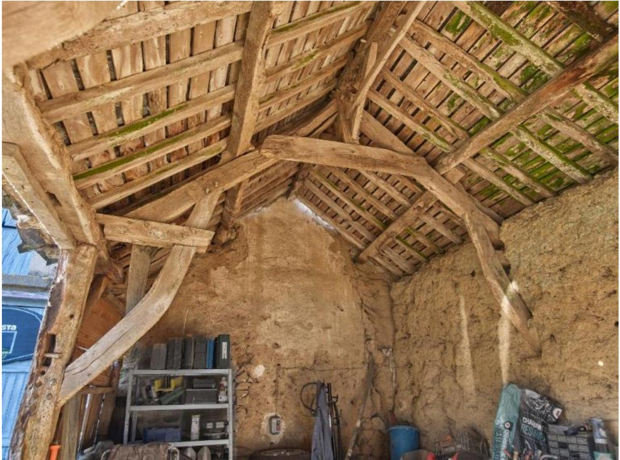
Remise. Charpente à sous-fâchage et jambes de force courbes
