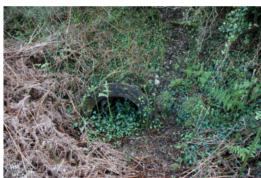
Vue des vestiges de l'un des quatre affûts pour canon antiaérien de 10,5 cm de la batterie de la pointe des Espagnols (état en 2005). Il a été projeté près du chemin menant à la batterie de Pourjoint Phot. Guillaume Lécueillier IVR53_20052904047NUCA
