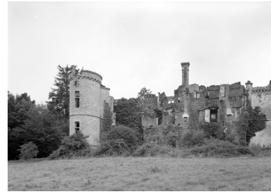
Château (vestiges), élévation sud-est. Phot. François Dagorn IVR53_19775601172V
