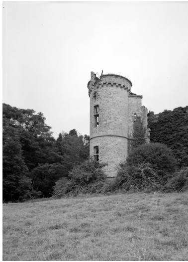
Château (vestiges), tour sud-ouest. Phot. François Dagorn IVR53_19775601175V
