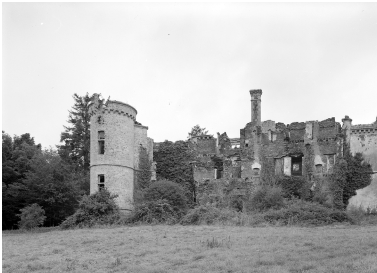
Château (vestiges), élévation sud-est.
