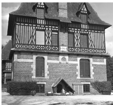
Détail : façade sud Phot. Jean-Pierre Ducouret IVR53_19823500952X
