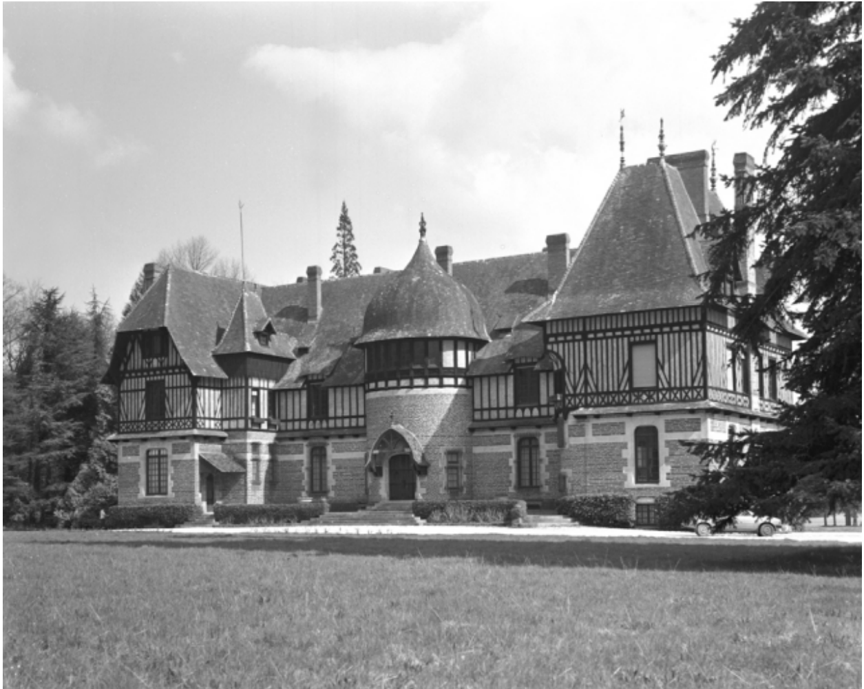
Vue générale sud-ouest en 1982
