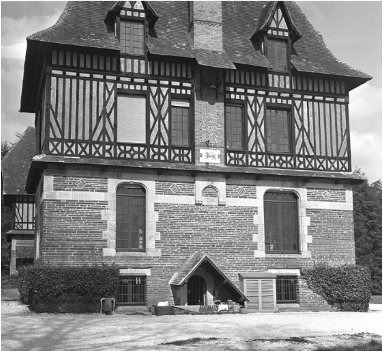
Détail : façade sud
