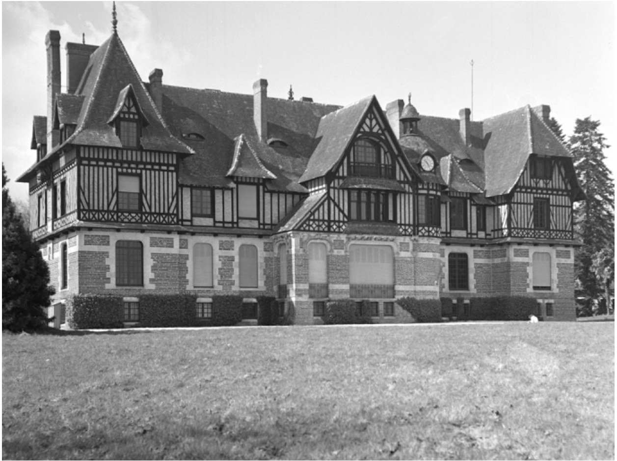
Vue générale est
