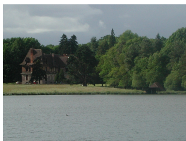
Vue de situation sud Phot. Claude Quillivic IVR53_20023512859NUCA
