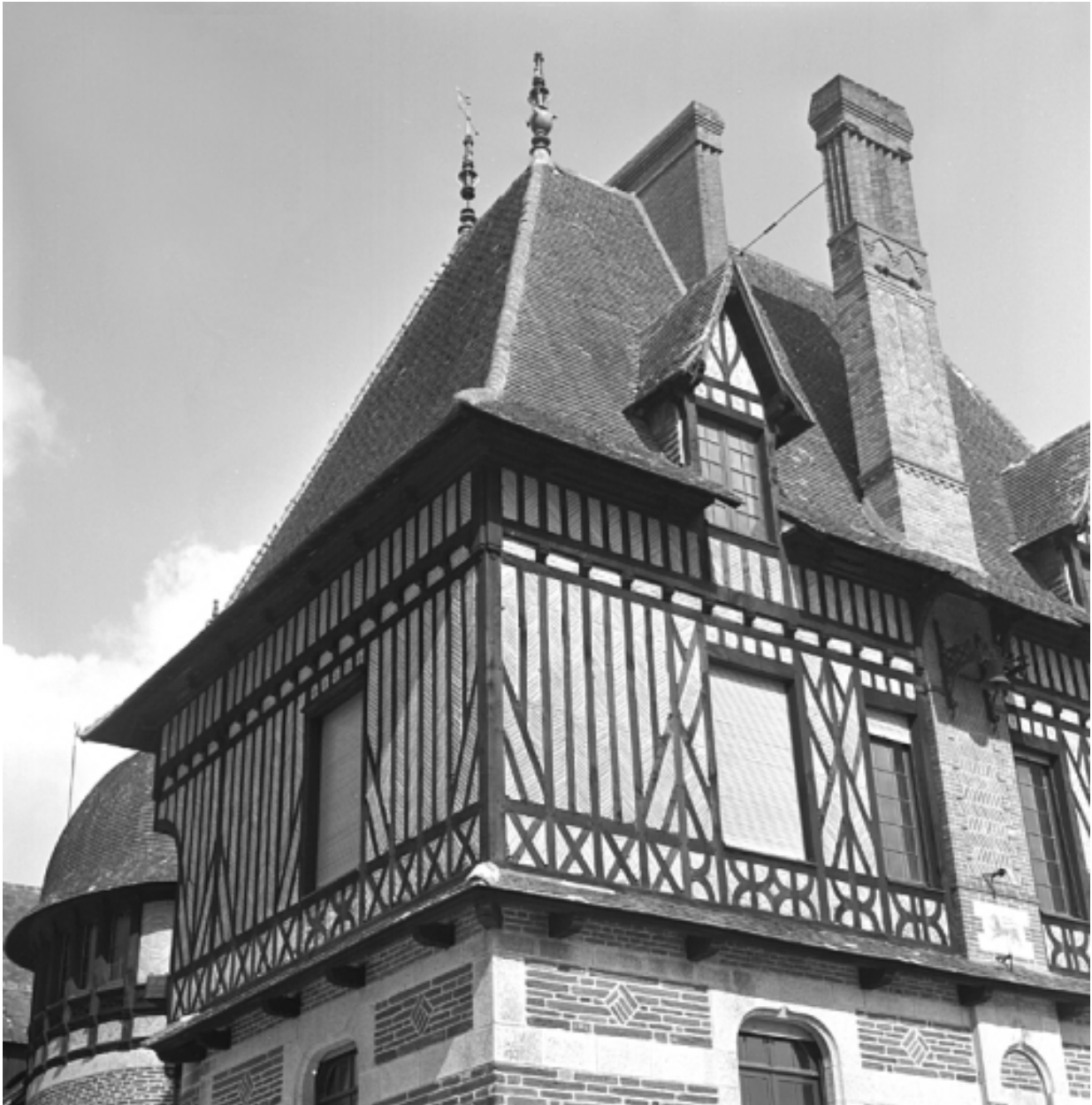
Détail : façade sud
