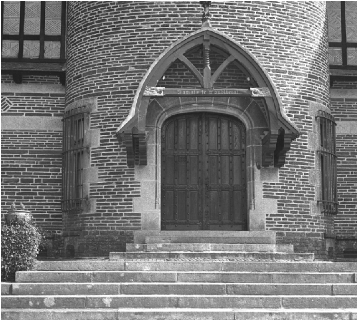
Détail : façade ouest, porte d'entrée
