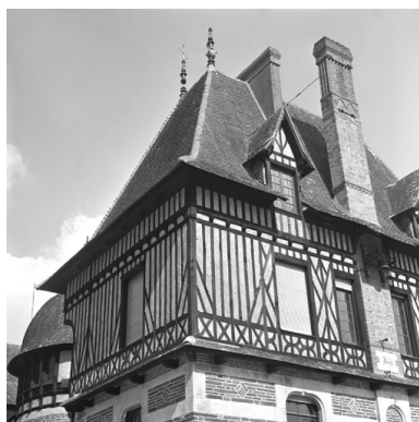
Détail : façade sud Phot. Jean-Pierre Ducouret IVR53_19823500951X
