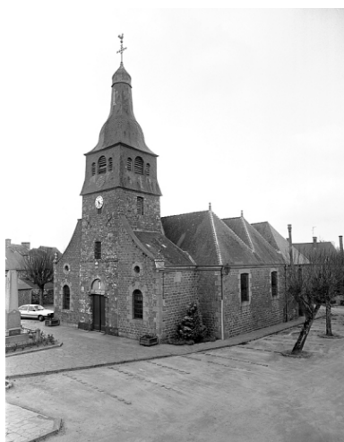
Elévation sud-ouest ; vue générale (état en 1994) Phot. Guy Artur, Phot. Norbert Lambart IVR53_19943500763X
