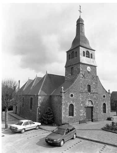
Elévation nord-ouest ; vue générale (état en 1994) Phot. Guy Artur, Phot. Norbert Lambart IVR53_19943500764X
