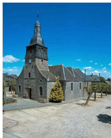
Vue générale sud-ouest (état en 2001) Phot. Guy Artur, Phot. Norbert Lambart IVR53_20013501168XA
