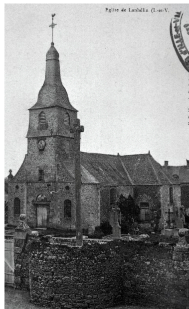
Élévation sud-ouest ; vue générale au début du 20e siècle Repro. Guy Artur, Repro. Norbert Lambart IVR53_19933500579X
