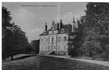
Vue générale sur la façade principale Phot. Auteur inconnu IVR53_19883500283XB
