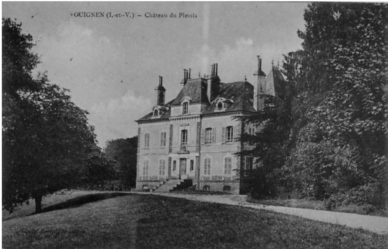
Vue générale sur la façade principale
