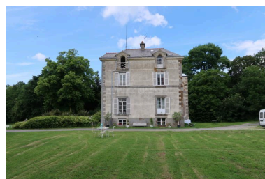
Vue latérale Phot. Véronique Orain IVR53_20182206571NUCA
