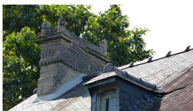
Détails de la souche de cheminée Phot. Laurence Marquet IVR53_20243531151NUCA
