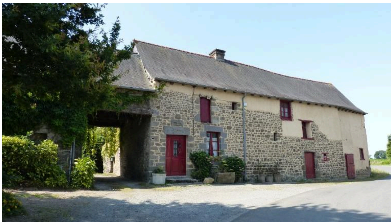
Façade nord, ancienne ferme, 3 rue de l'ancienne école
