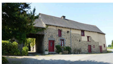
Façade nord, ancienne ferme, 3 rue de l'ancienne école Phot. Laurence Marquet IVR53_20243531086NUCA
