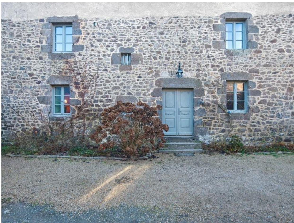
Logis. Façade nord
