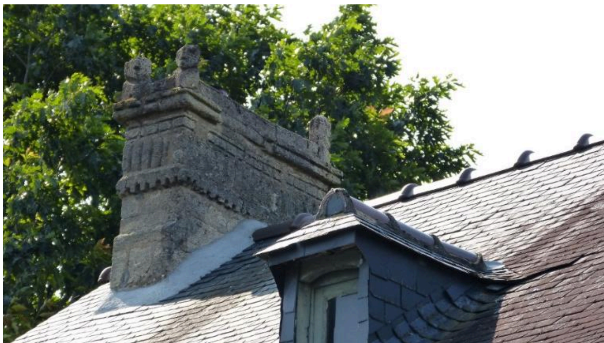
Détails de la souche de cheminée
