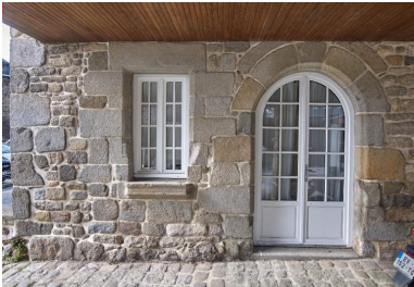
Une porte en plein cintre et une fenêtre à appui mouluré constituent les seules baies du rez-de-chaussée. Phot. Bernard Bègne IVR53_20243501137NUCA
