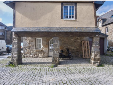
Trois piliers maçonnés soutiennent le porche et remplacent probablement des poteaux de bois. Phot. Bernard Bègne IVR53_20243501134NUCA
