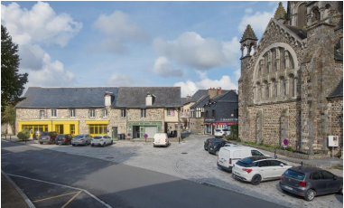
Insertion de l'ensemble bâti dans le tissu urbain, à proximité directe de l'église. Phot. Bernard Bègne IVR53_20243501129NUCA
