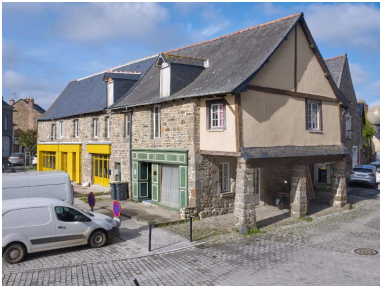
Le porche prolonge au-dessus de la voie publique l'alignement bâti. Phot. Bernard Bègne IVR53_20243501131NUCA
