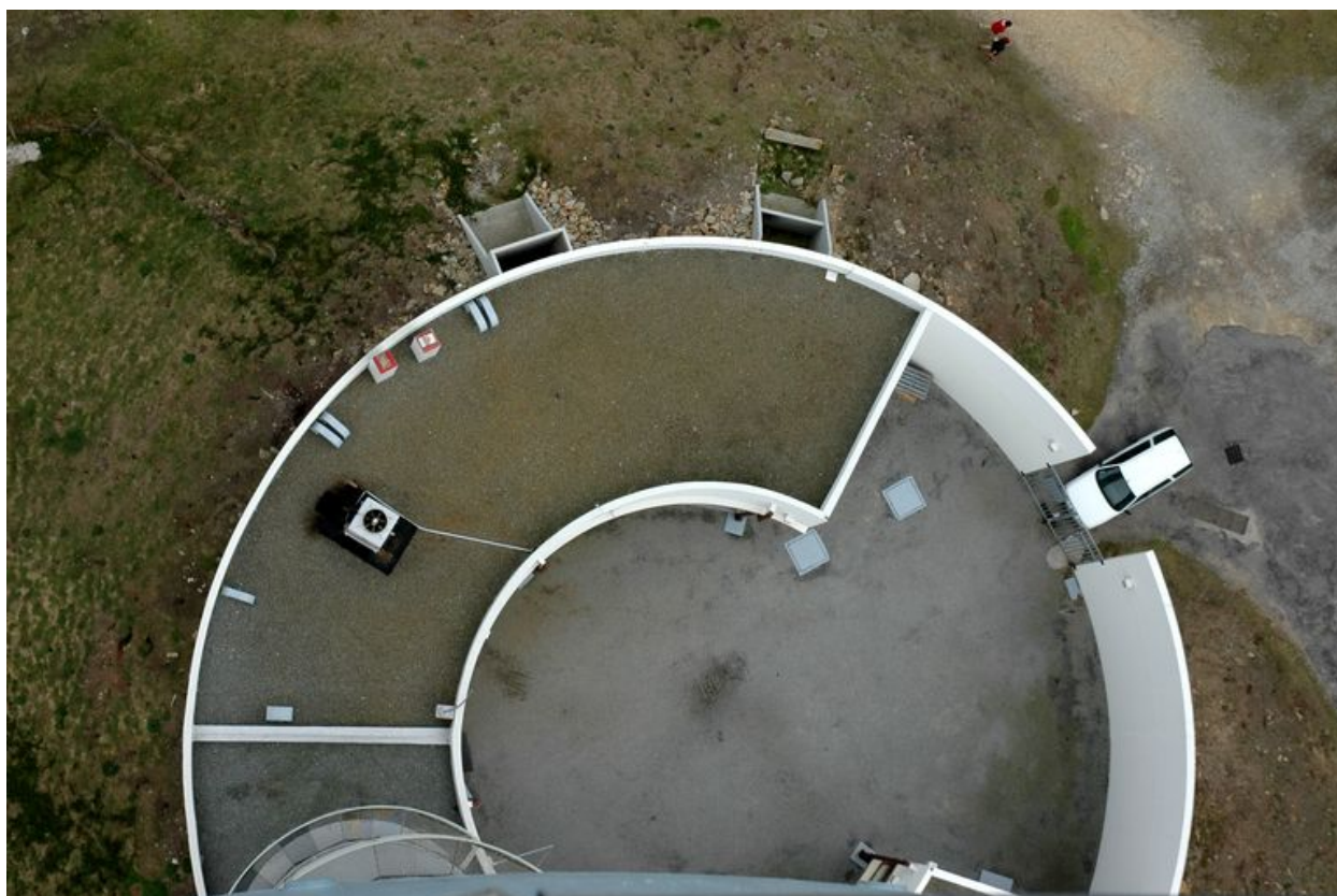
Vue de la partie basse (état en 2005)
