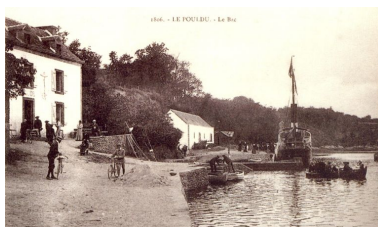
Le port du Pouldu au début du 20e siècle, avec la maison Jacob à gauche Repro. Johan Vincent, Autr. Auteur inconnu IVR53_20082908693NUCB
