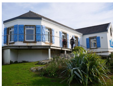
Façade nord du sémaphore Phot. Auteur inconnu IVR53_20242910559NUCA
